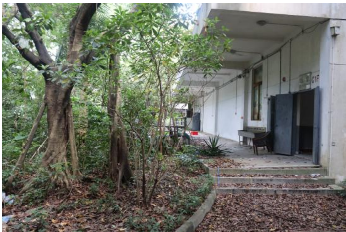
图 17 地块内中部现状（东-西）
