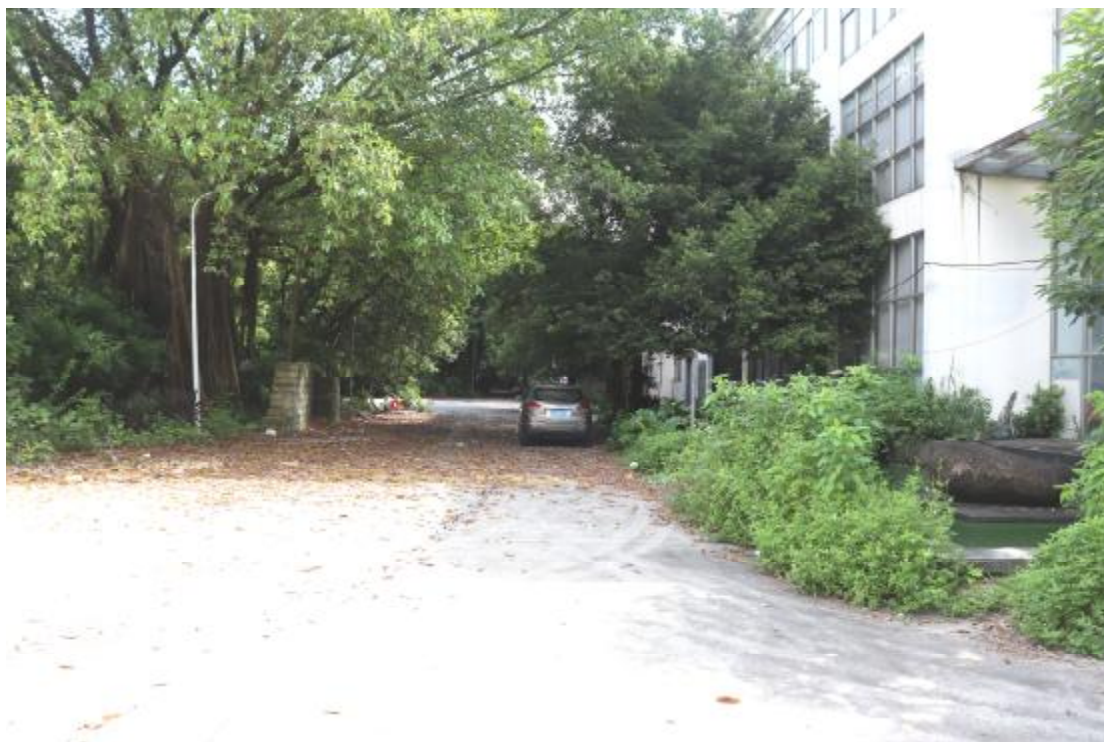
图 18 地块内中部现状（南-北）
