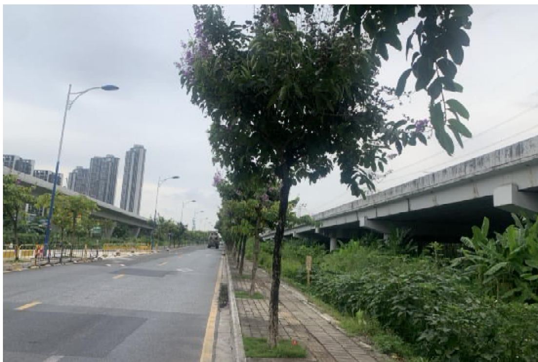
图 15 项目东北部现状（西北-东南）
