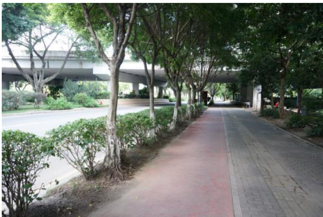
图 8 项目西北部现状（东北-西南）
