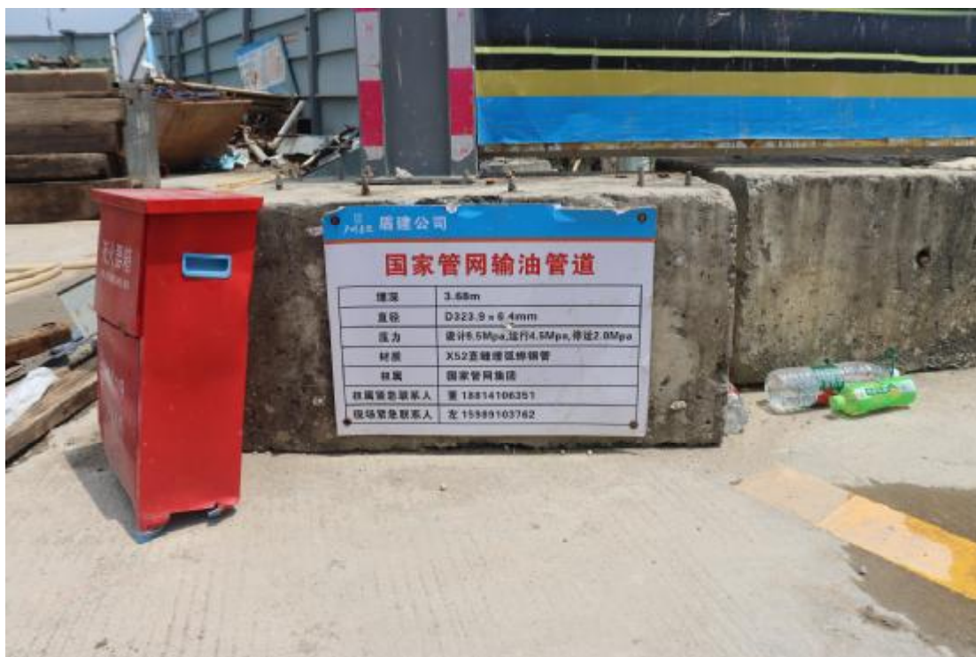
图 23 国家管网输油管道标识牌
