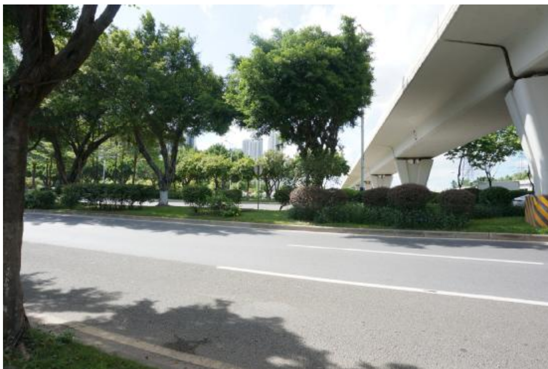
图 9 项目西北部现状（西北-东南）
