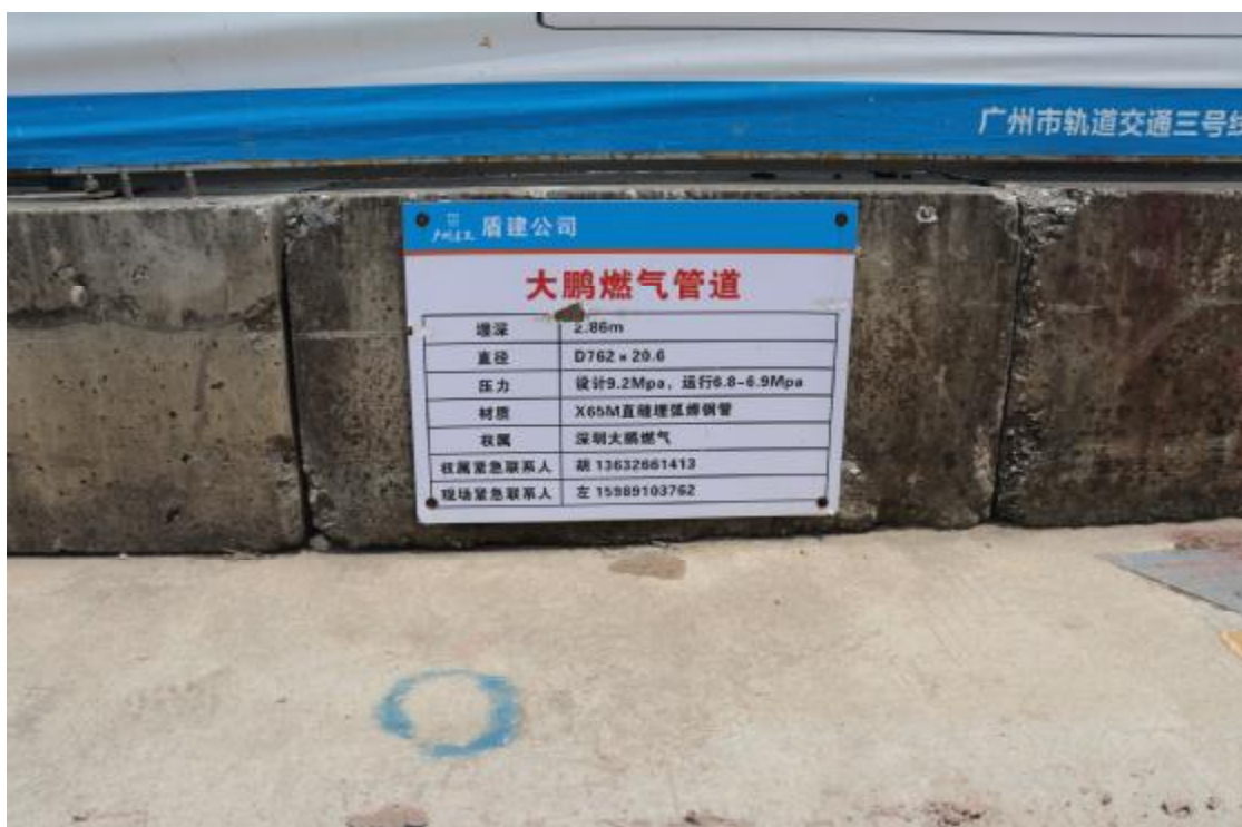
图 24 大鹏燃气管道标识牌
