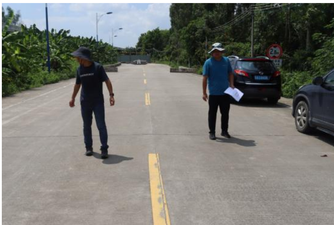
图 7 现场踏查（东南-西北）
