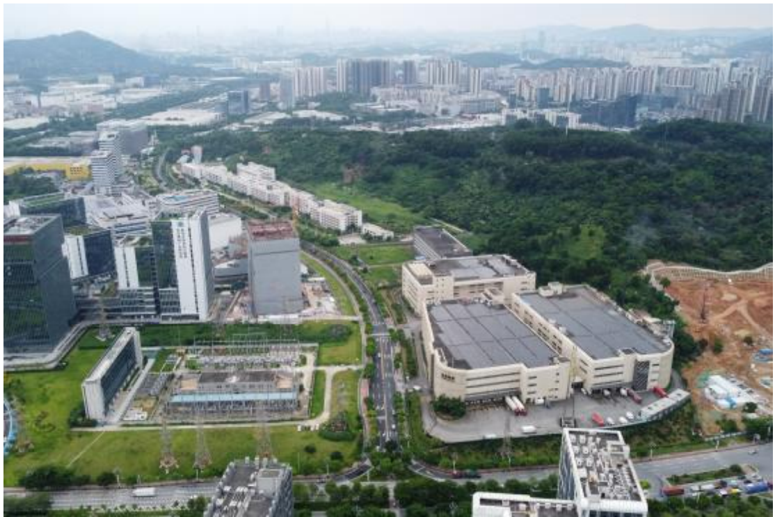
图 13 地块外西部地形地貌（东-西）
