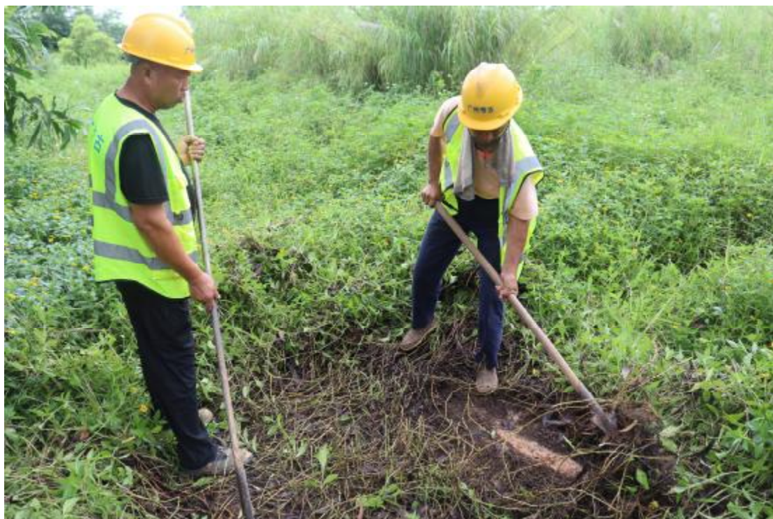
图 31 地表清理（东北-西南）
