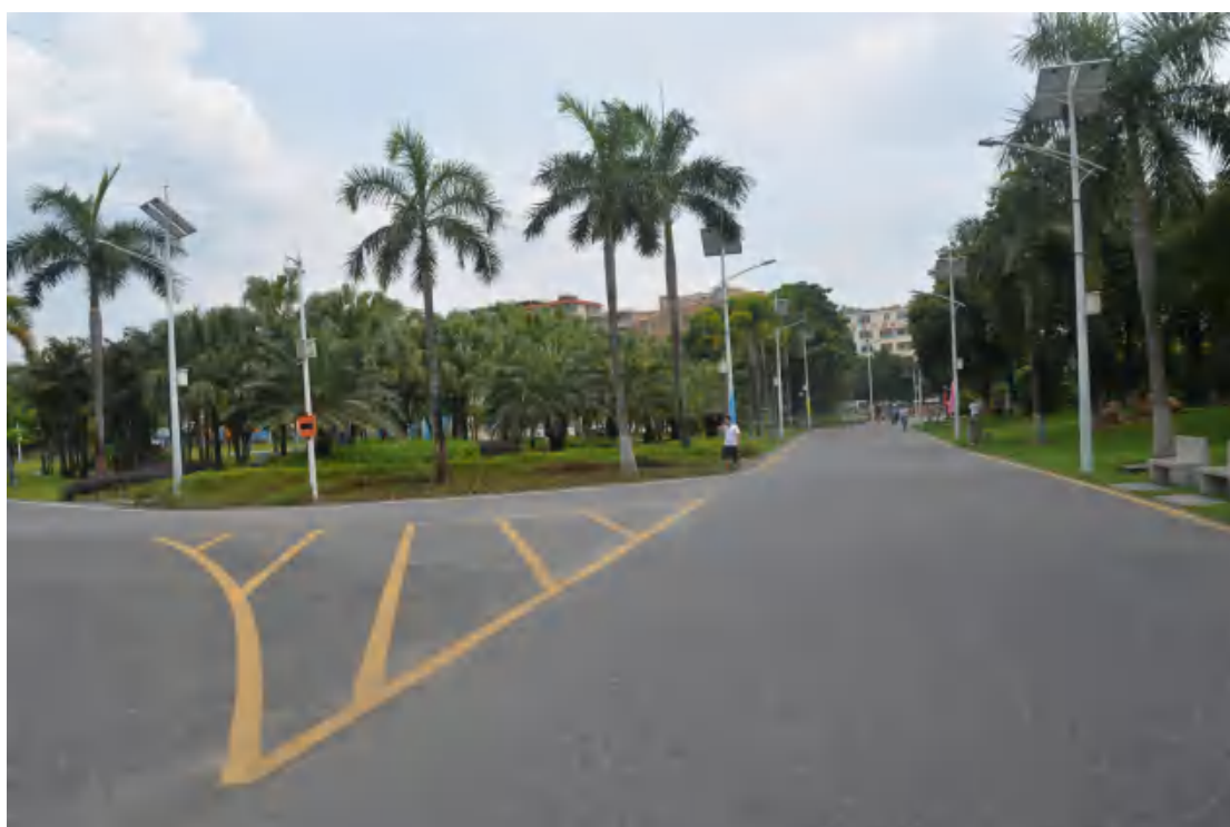
图 11 项目用地东湖地表现状（北—南）
