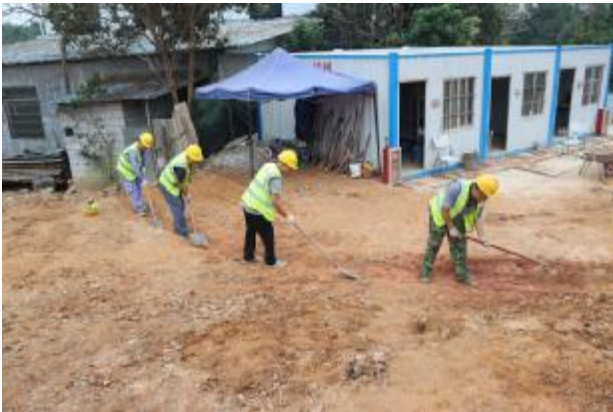
图 36 挖防水沟工作照（东北-西南）
