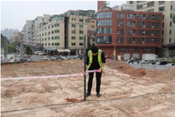
图 34 拉警戒线工作照（西北-东南）
