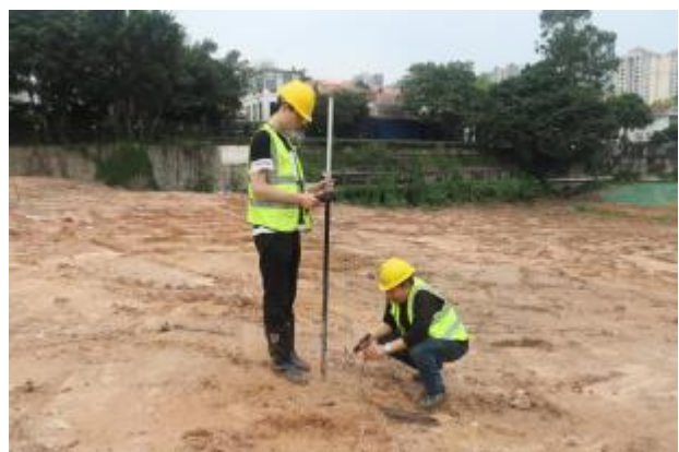
图 33 RTK 工作照（南-北）
