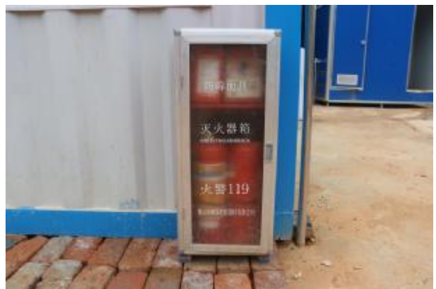
图 27 发掘现场消防器材
