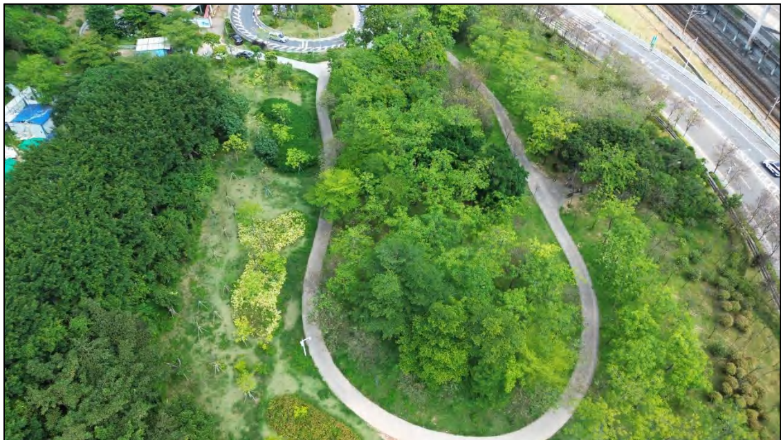
图 17 地块现状（西-东）
