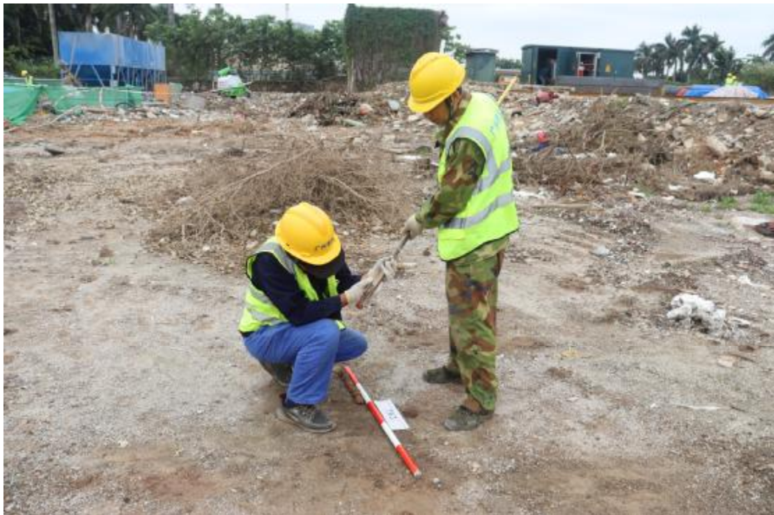
图 30 试探孔土样分析（西北-东南）
