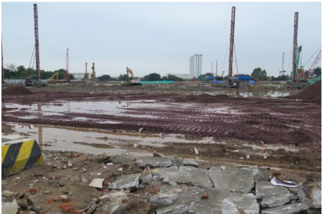
图 18 地块内中部现状（西北-东南）
