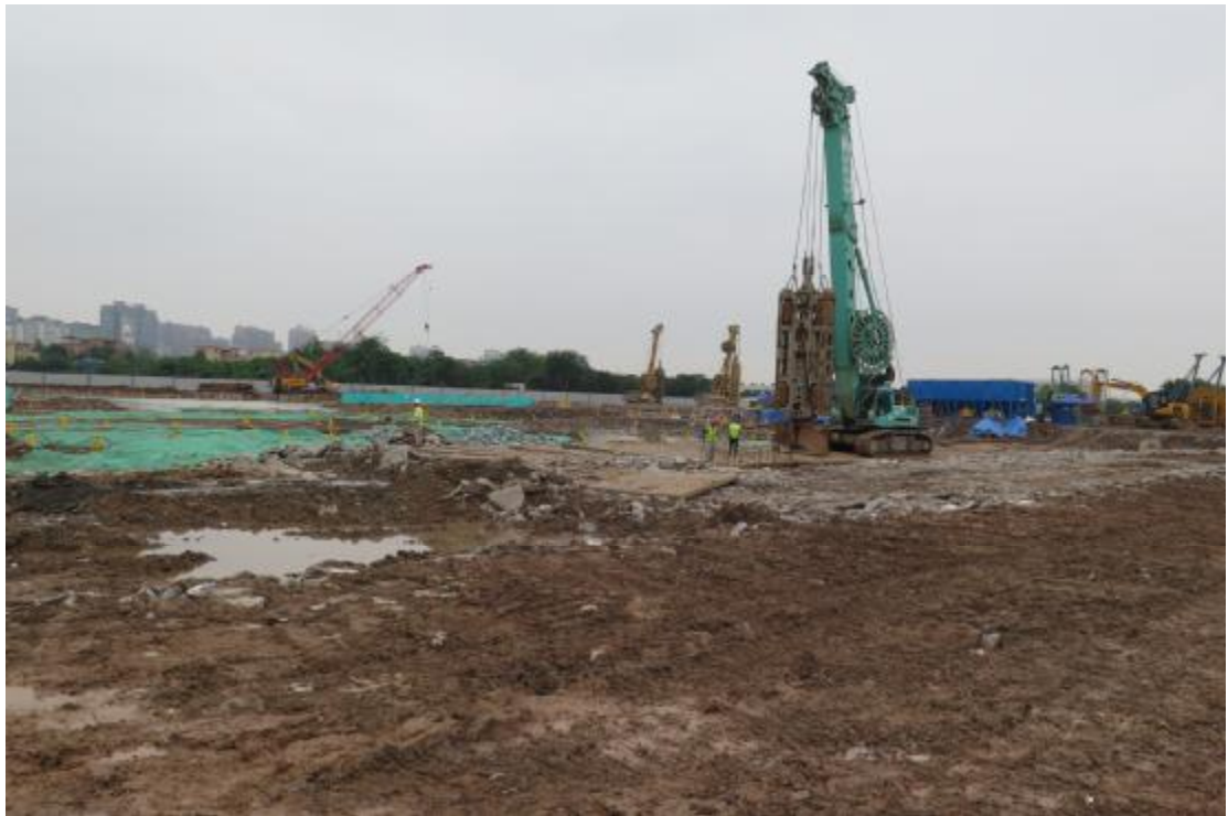
图 22 地块内南部现状（西北-东南）
