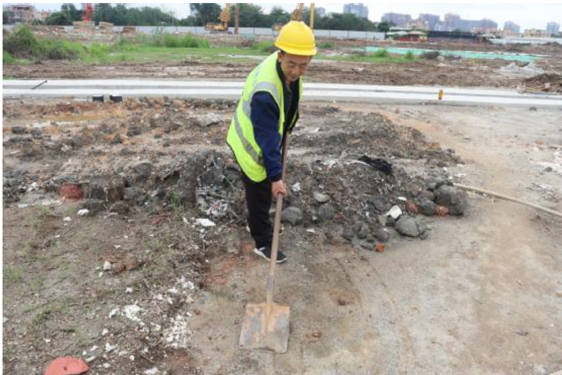
图 28 试探孔土样表面清理（西南-东北）
