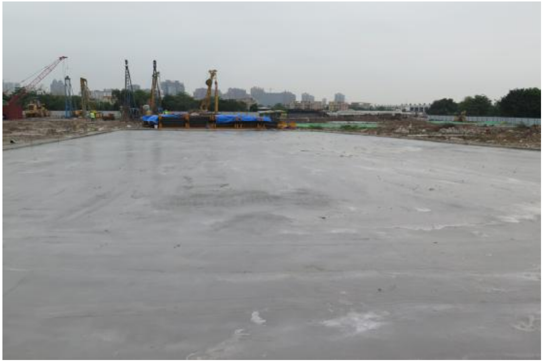
图 23 地块内南部现状（西-东）
