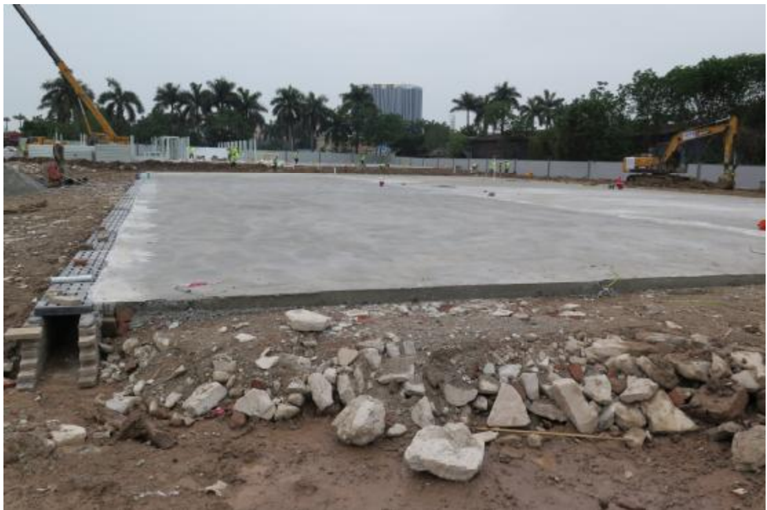
图 24 地块内西部现状（北-南）
