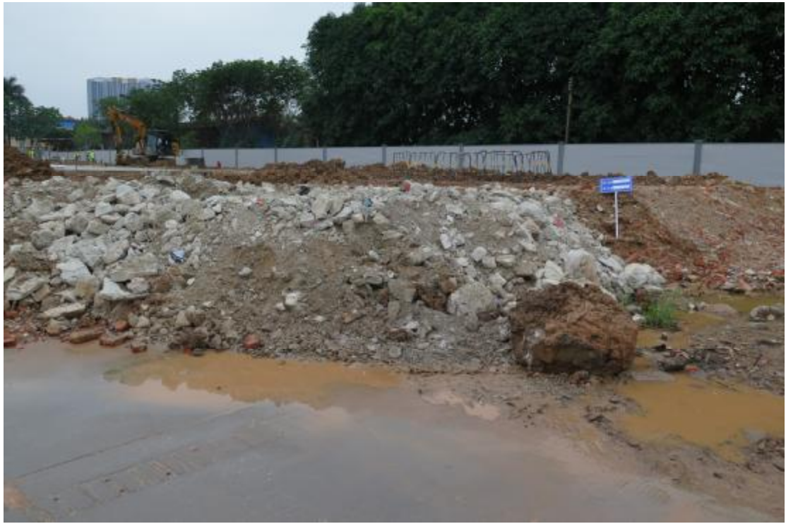
图 25 地块内西部现状（北-南）
