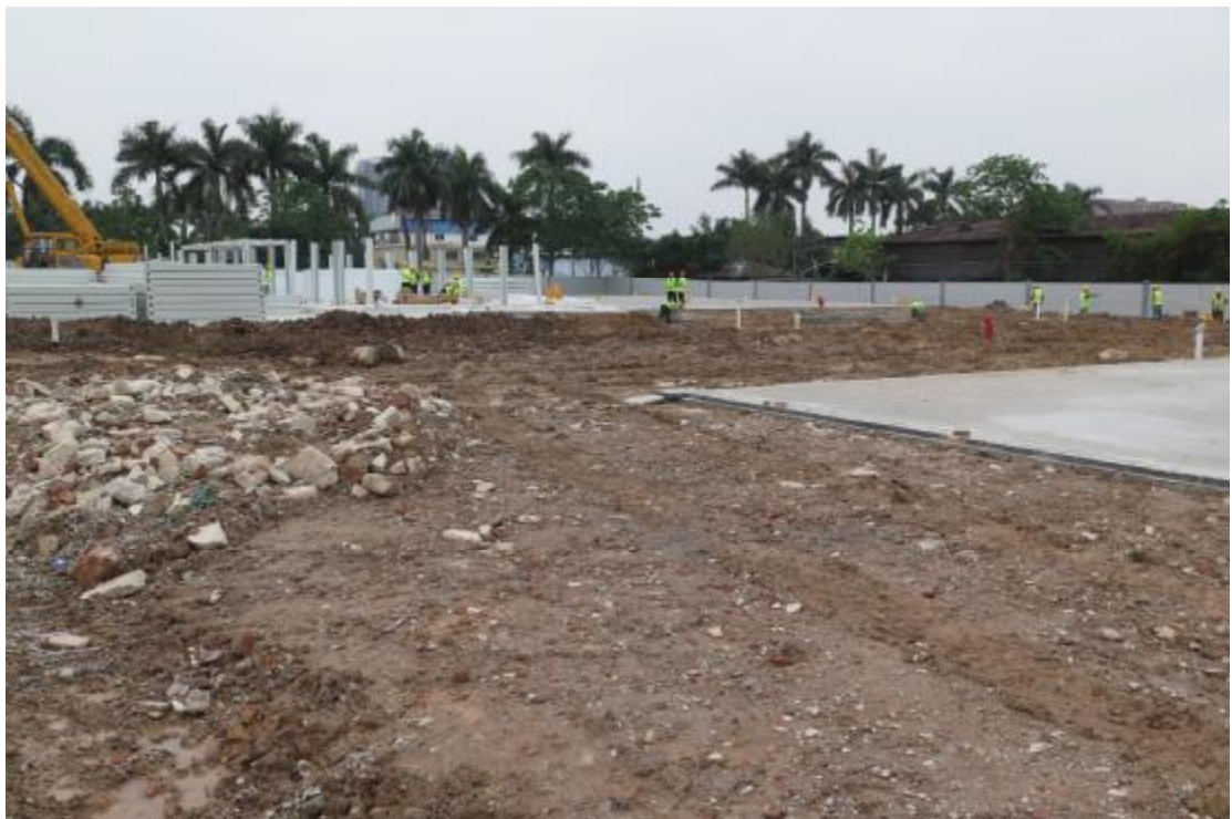
图 20 地块内南部现状（东北-西南）
