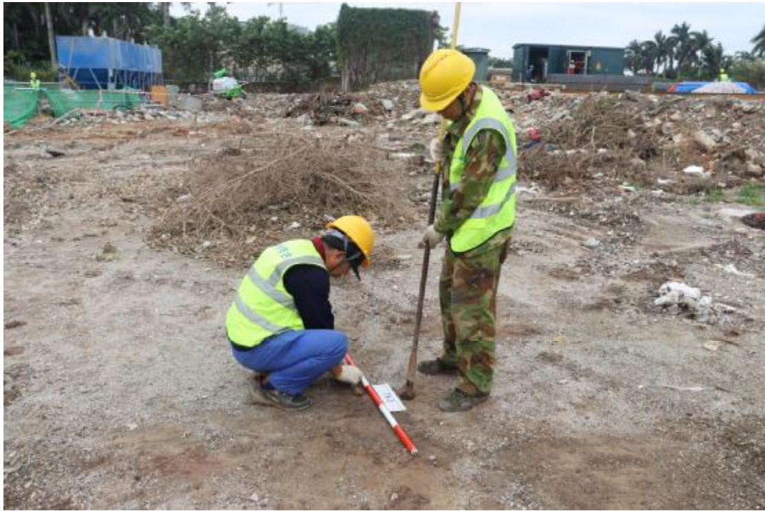
图 29 试探孔提取土样（西北-东南）
