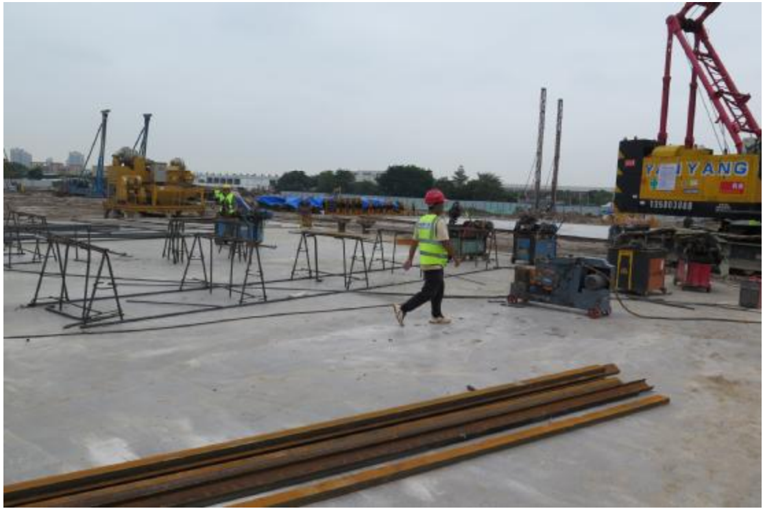
图 21 地块内南部现状（西北-东南）
