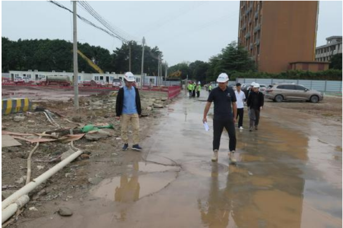
图 9 现场踏查（东-西）
