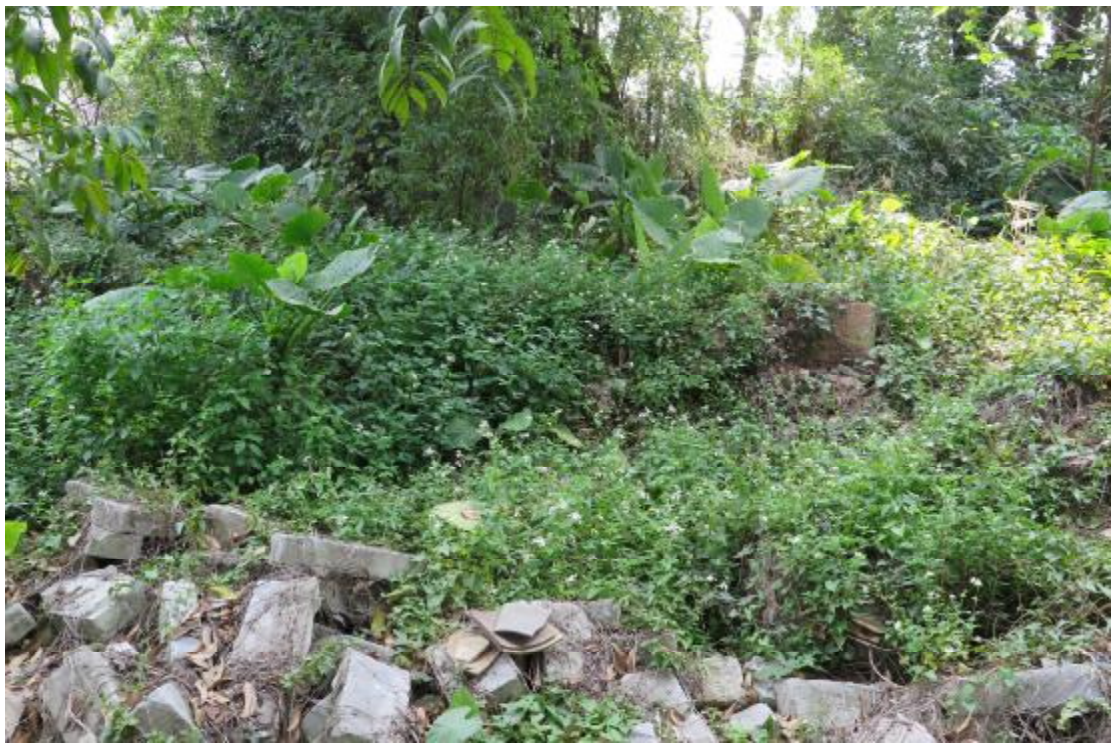
图 17 地块内中部现状（西-东）
