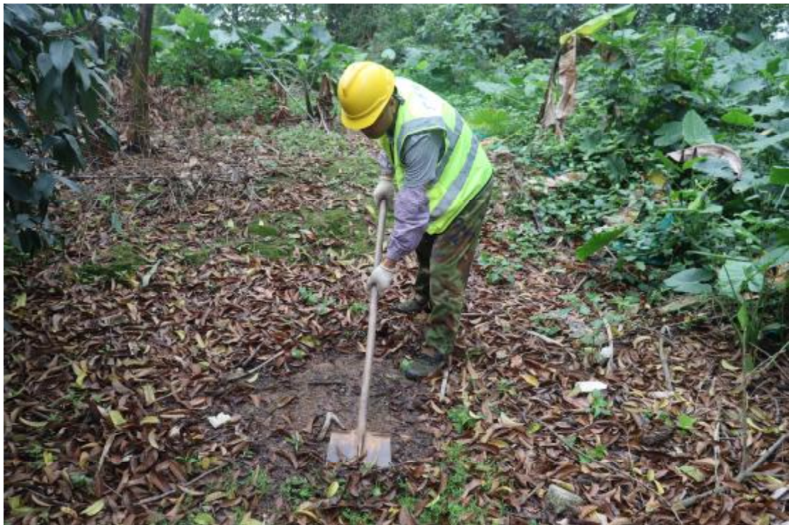
图 31 试探探孔地表清理（西南-东北）
