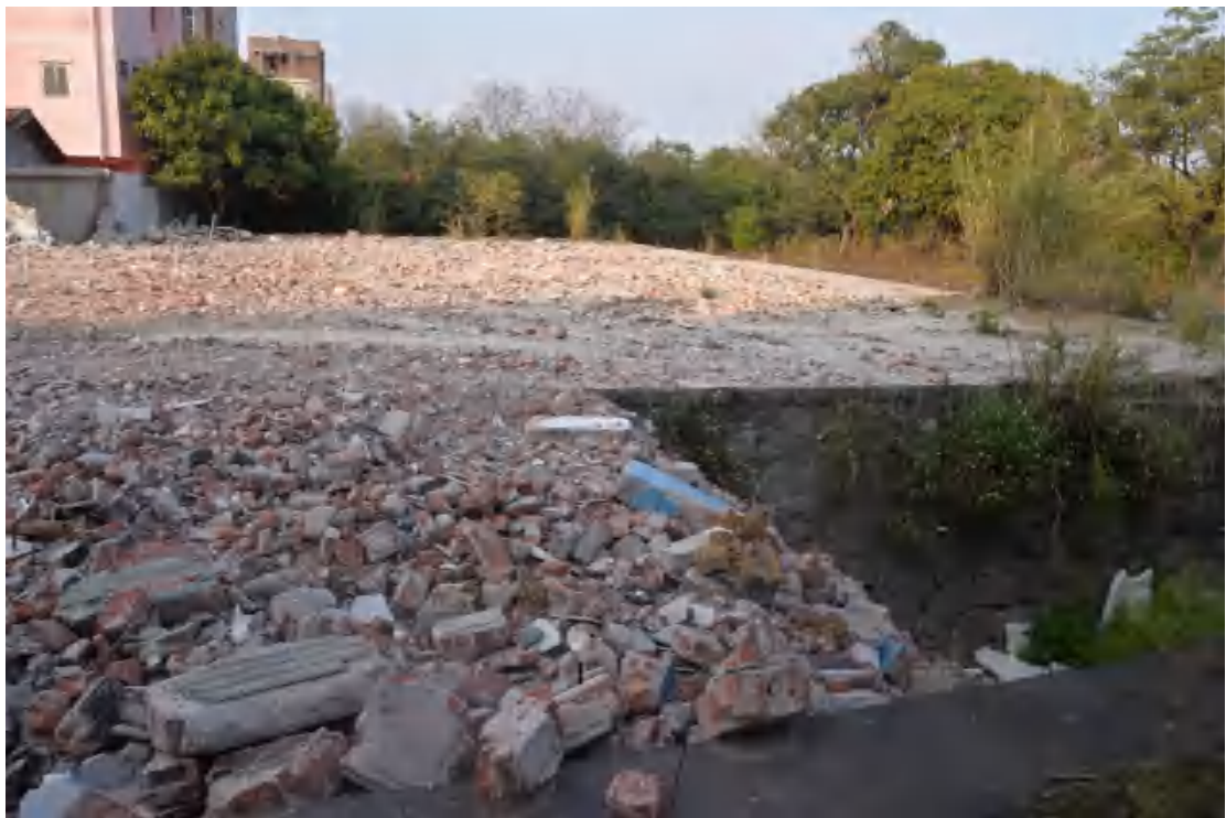
图 28 地块中部地表现状（南-北）
