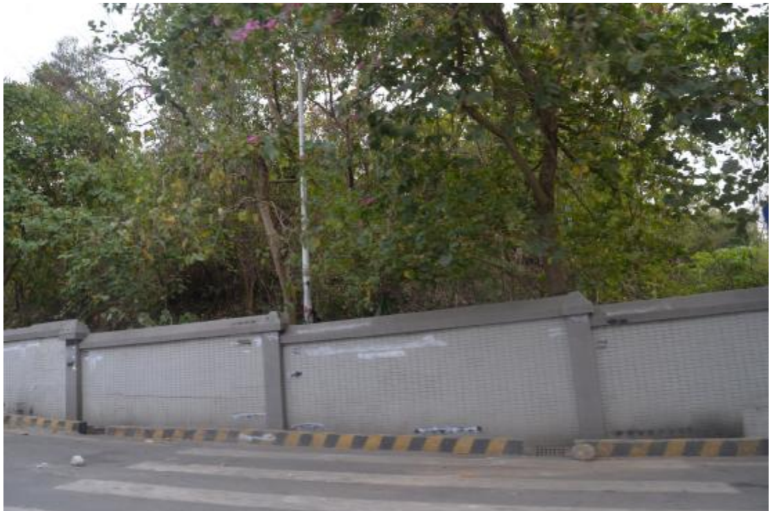
图 18 地块东部地表现状（北-南）
