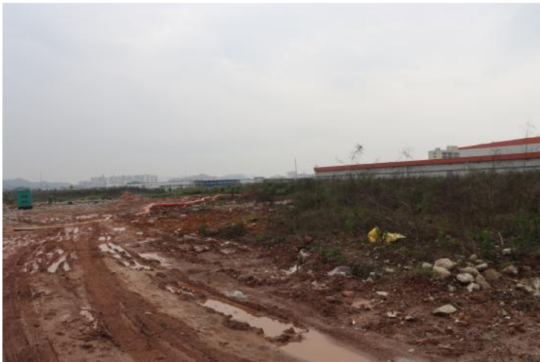
图 12 地块内北部现状（东-西）
