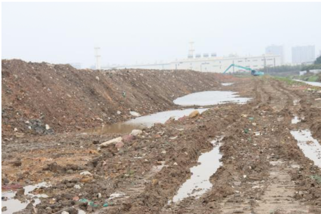
图 19 地块内南部现状（西-东）
