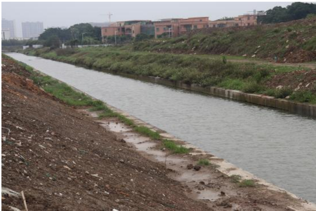
图 16 地块内东南部现状（西-东）
