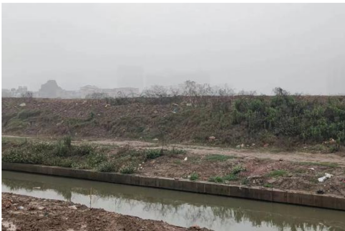
图 15 地块内东南部现状（西北-东南）
