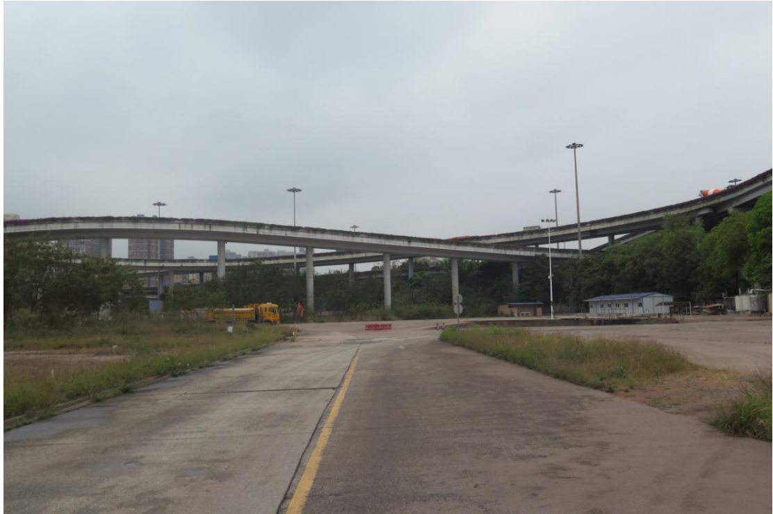
图 10 地块内北部现状（东-西）
