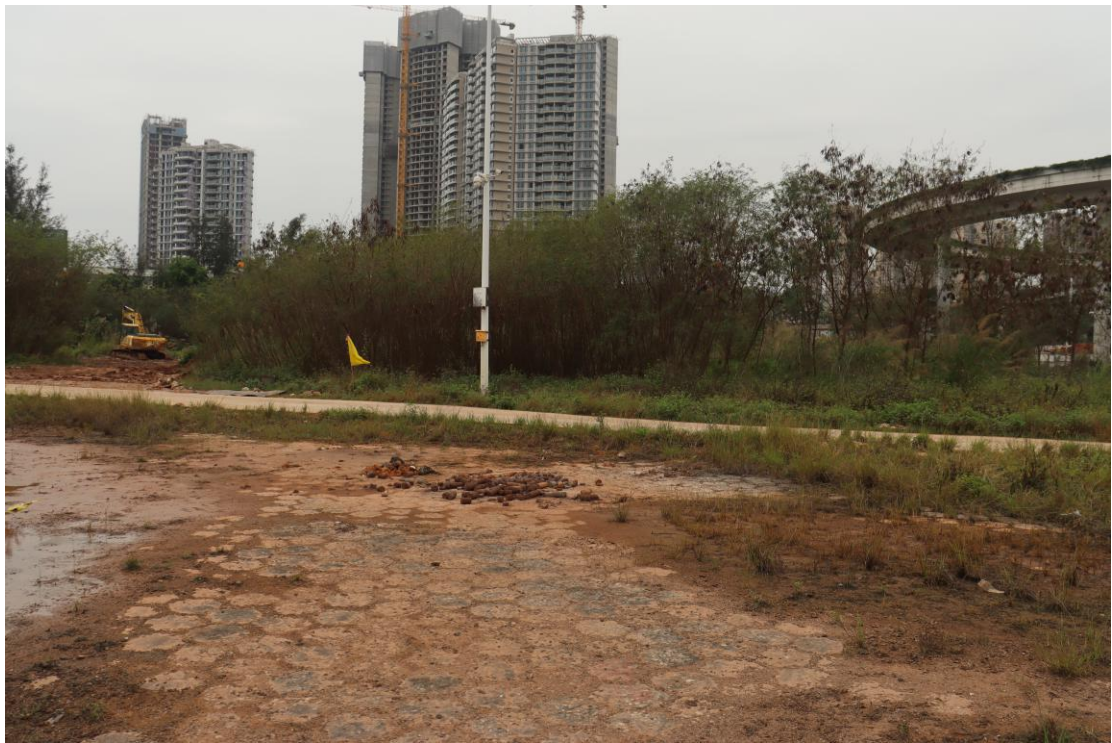
图 21 地块内西部现状（北-南）
