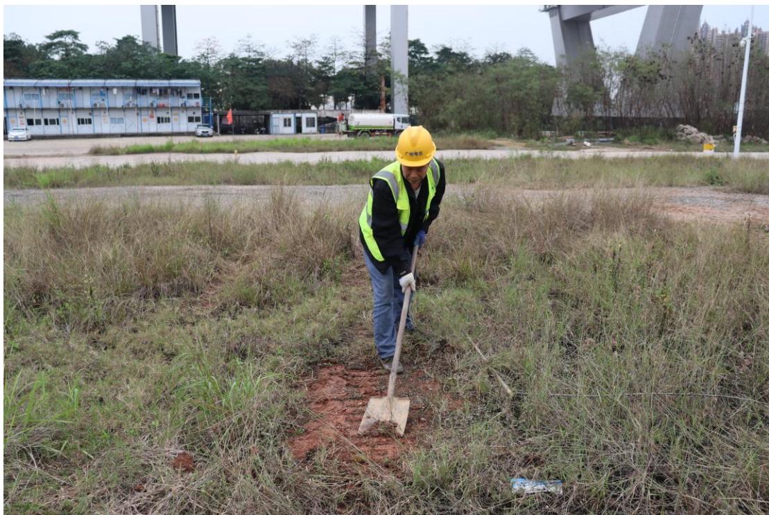
图 25 试探孔土样表面清理(南-北)
