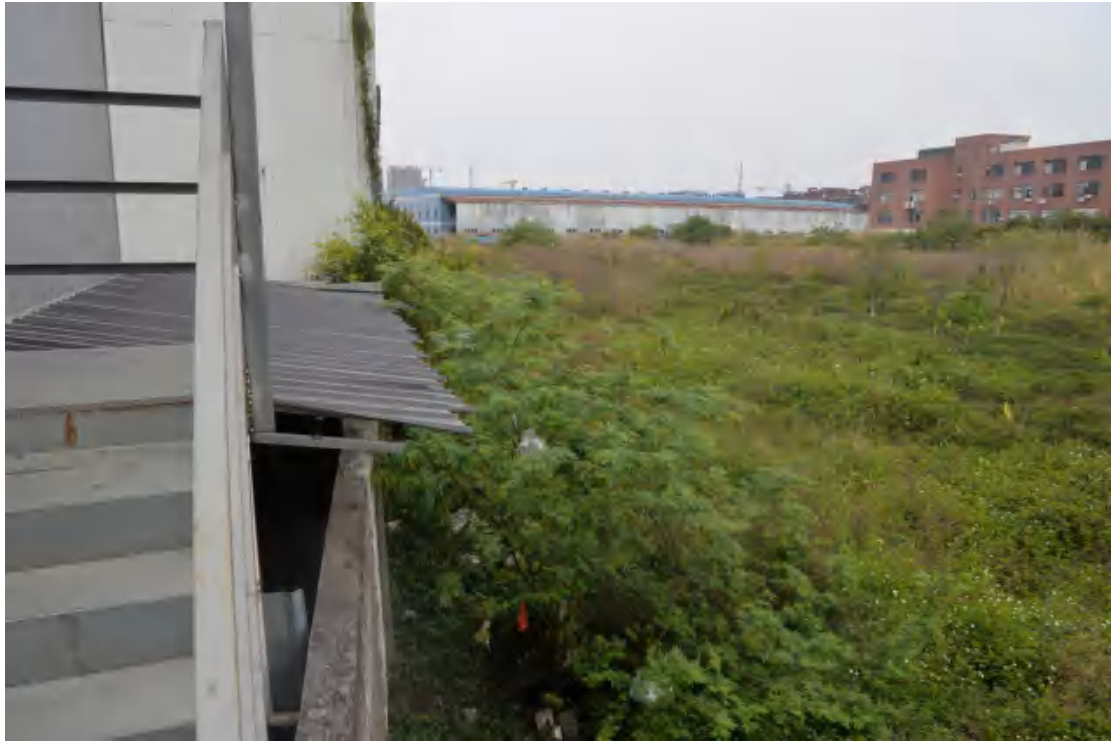
图 19 地块三地表现状（西—东）
