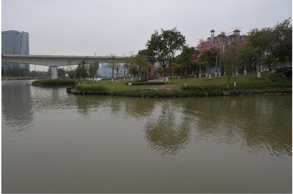
图 47 融通大厦前人行桥周边地表现状（北-南）
