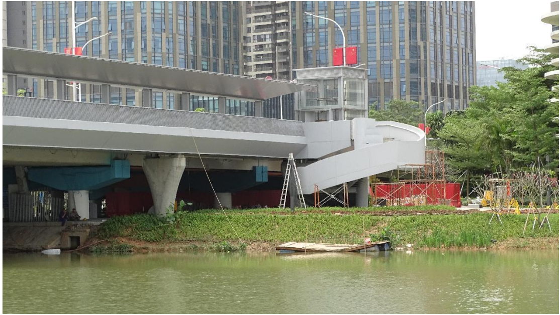
图 41 进港大道人行桥周边地表现状（东-西）
