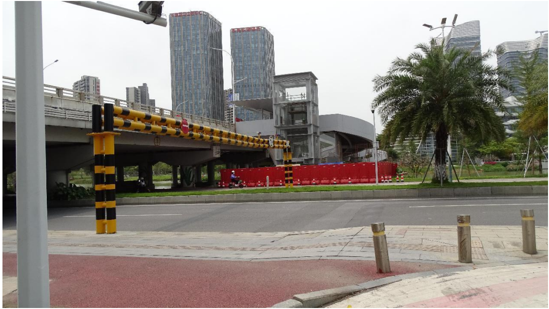
图 39 进港大道人行桥周边地表现状（北-南）
