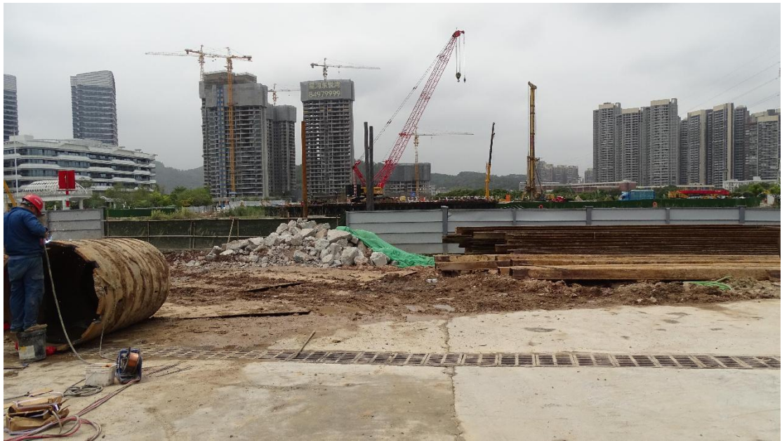
图 22 聚星桥桥体周边地表现状（东-西）
