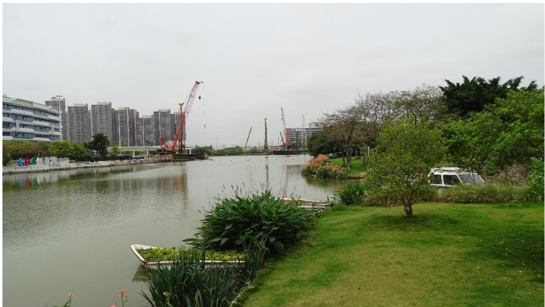
图 18 聚星桥桥体周边地表现状（南-北）
