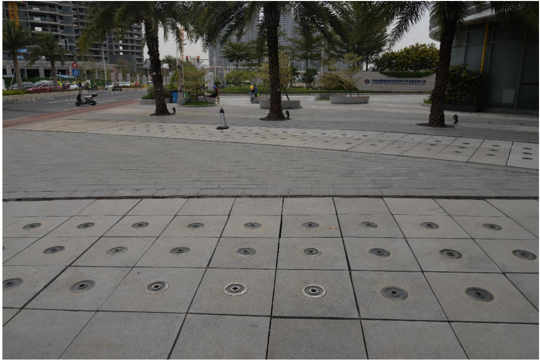
图 25 创享湾与东悦汇连廊周边地表现状（南-北）
