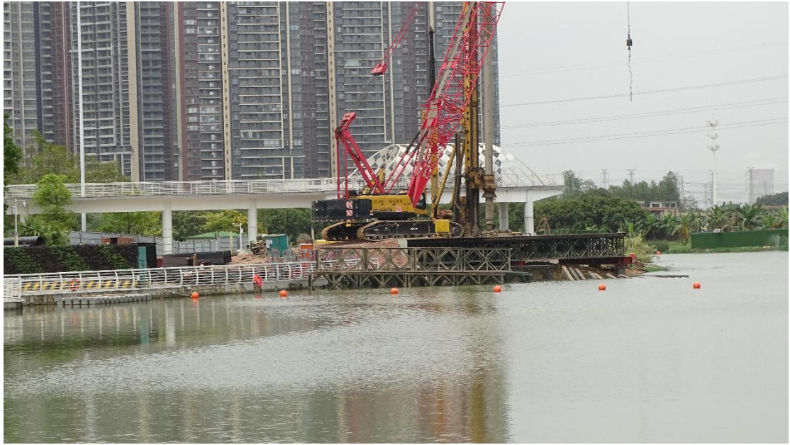
图 19 聚星桥桥体周边地表现状（南-北）
