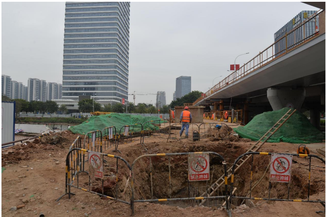
图 36 进港大道人行桥周边地表现状（西-东）
