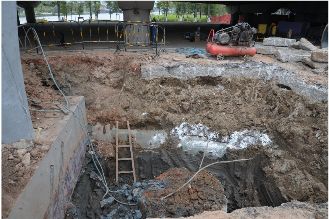
图 35 进港大道人行桥周边地表现状（北-南）
