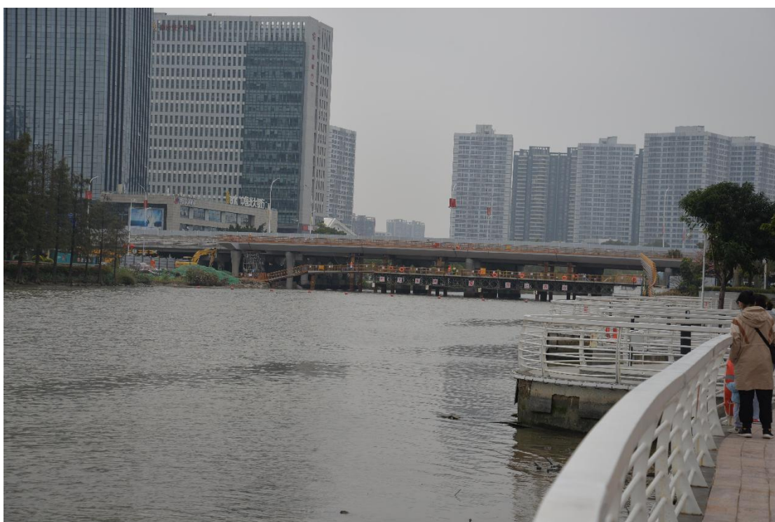
图 38 进港大道人行桥周边地表现状（北-南）
