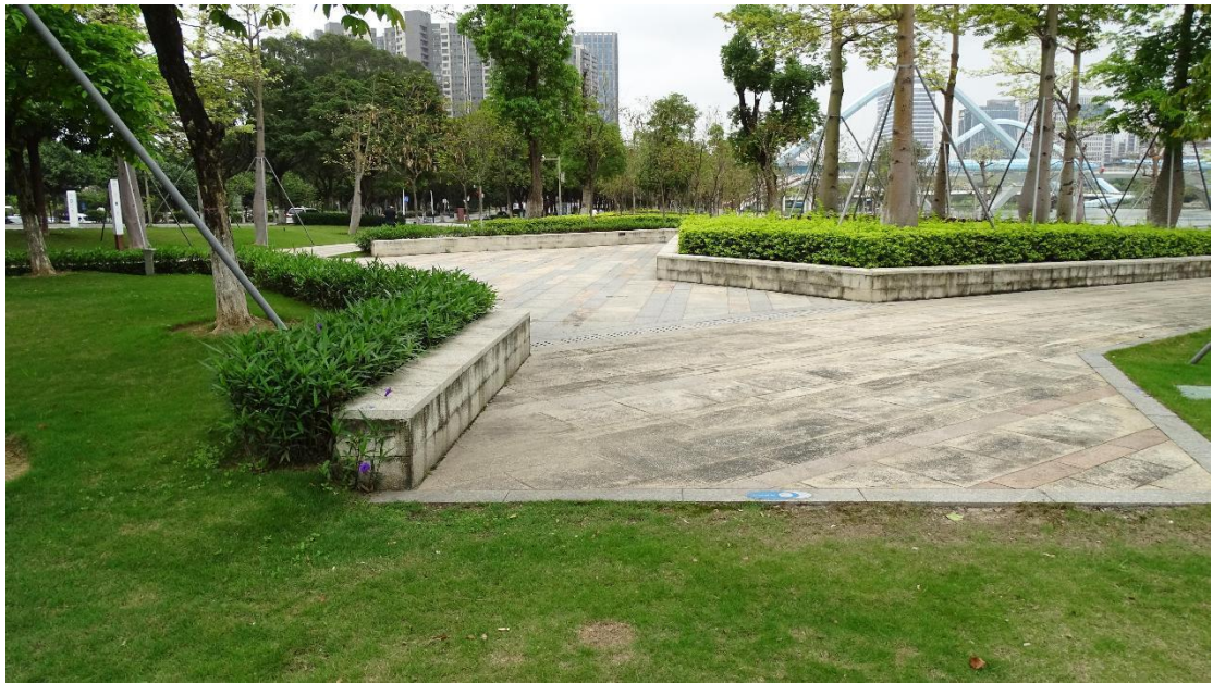
图 49 融通大厦前人行桥周边地表现状（南-北）
