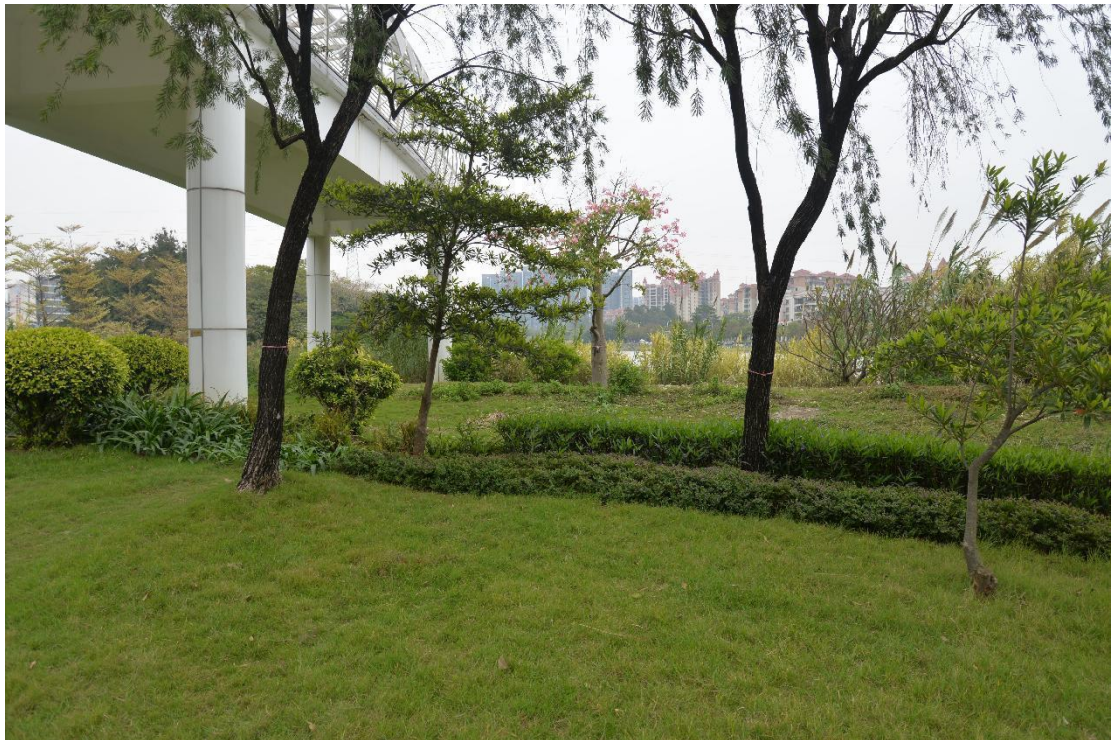
图 16 聚星桥桥体周边地表现状（南-北）
