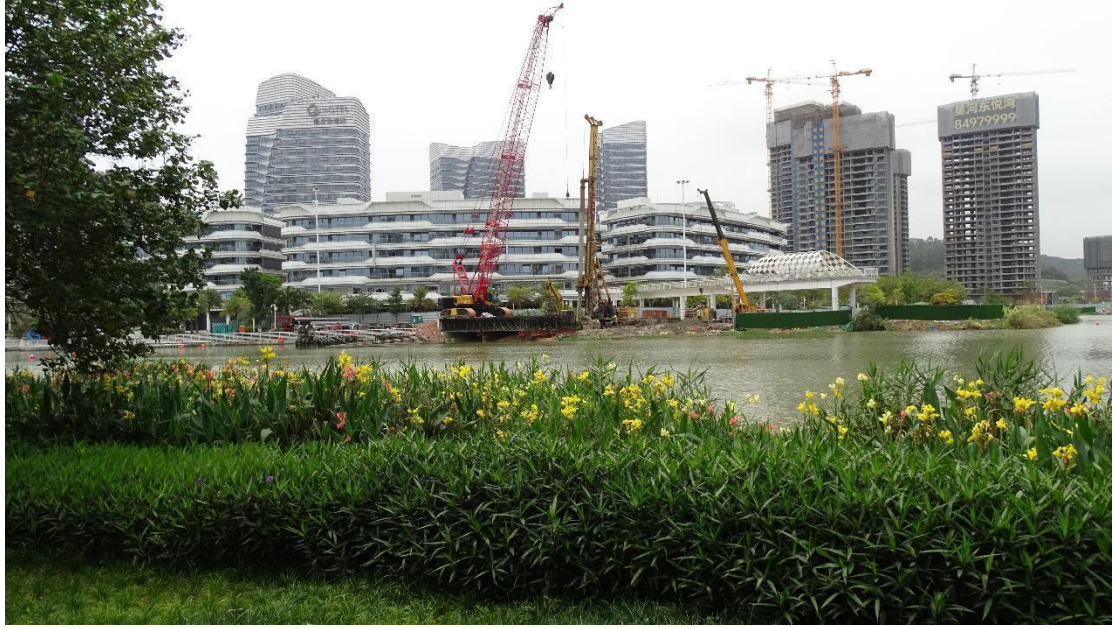
图 21 聚星桥桥体周边地表现状（东-西）
