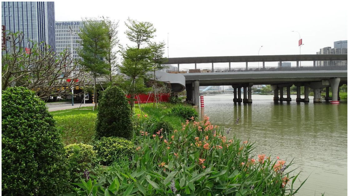
图 42 进港大道人行桥周边地表现状（北-南）
