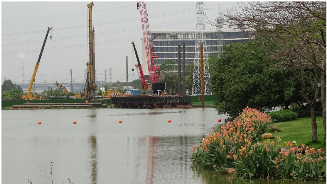
图 20 聚星桥桥体周边地表现状（南-北）
