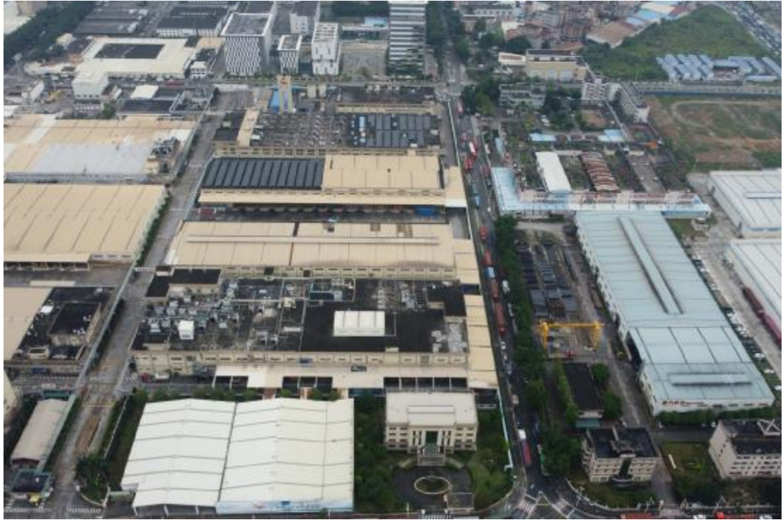
图 16 地块外西部现状（东-西）
