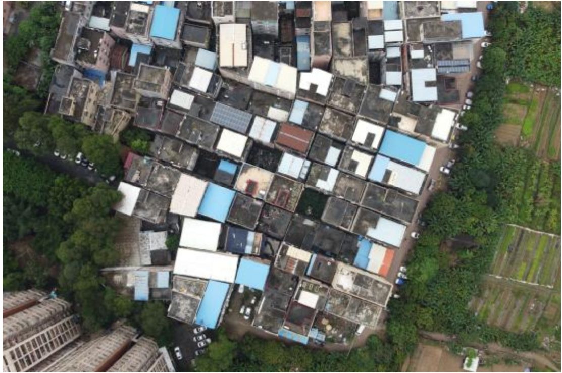
图 18 地块内西北部现状（上南下北）
