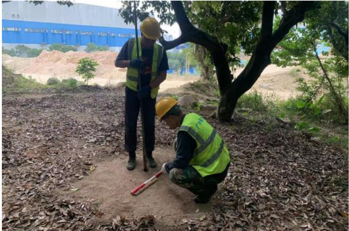
图 32 标准探孔提取土样工作照（西南-东北）
