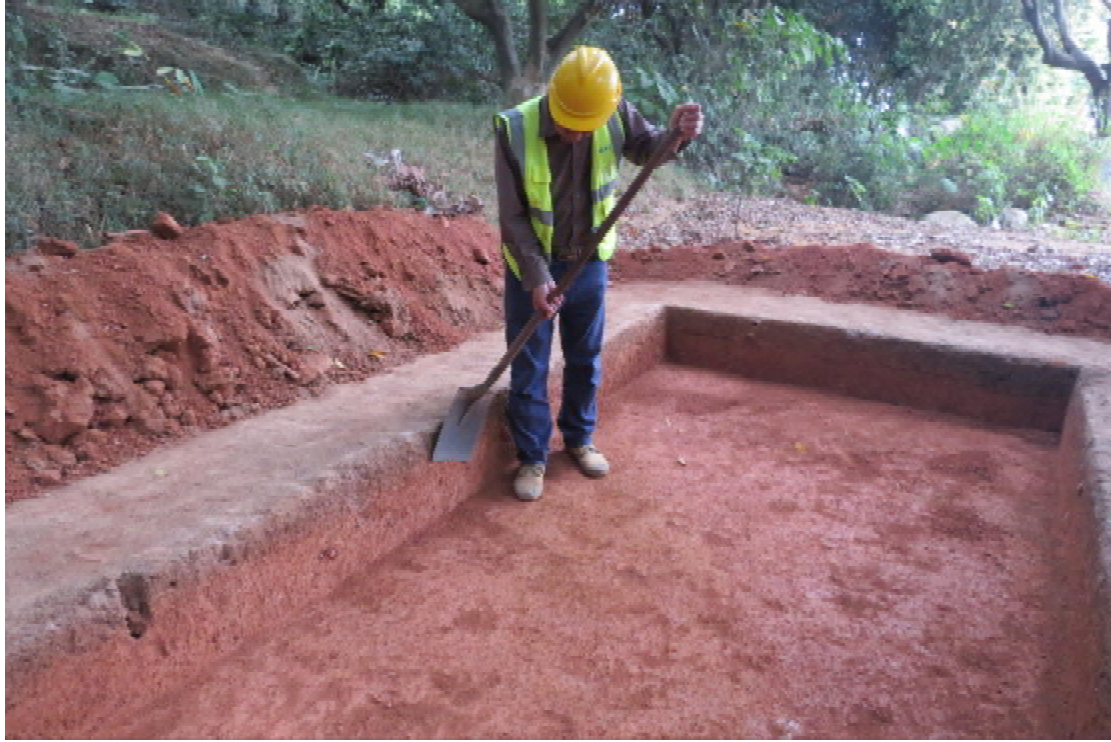
图 55 修整探沟壁（东南-西北）
