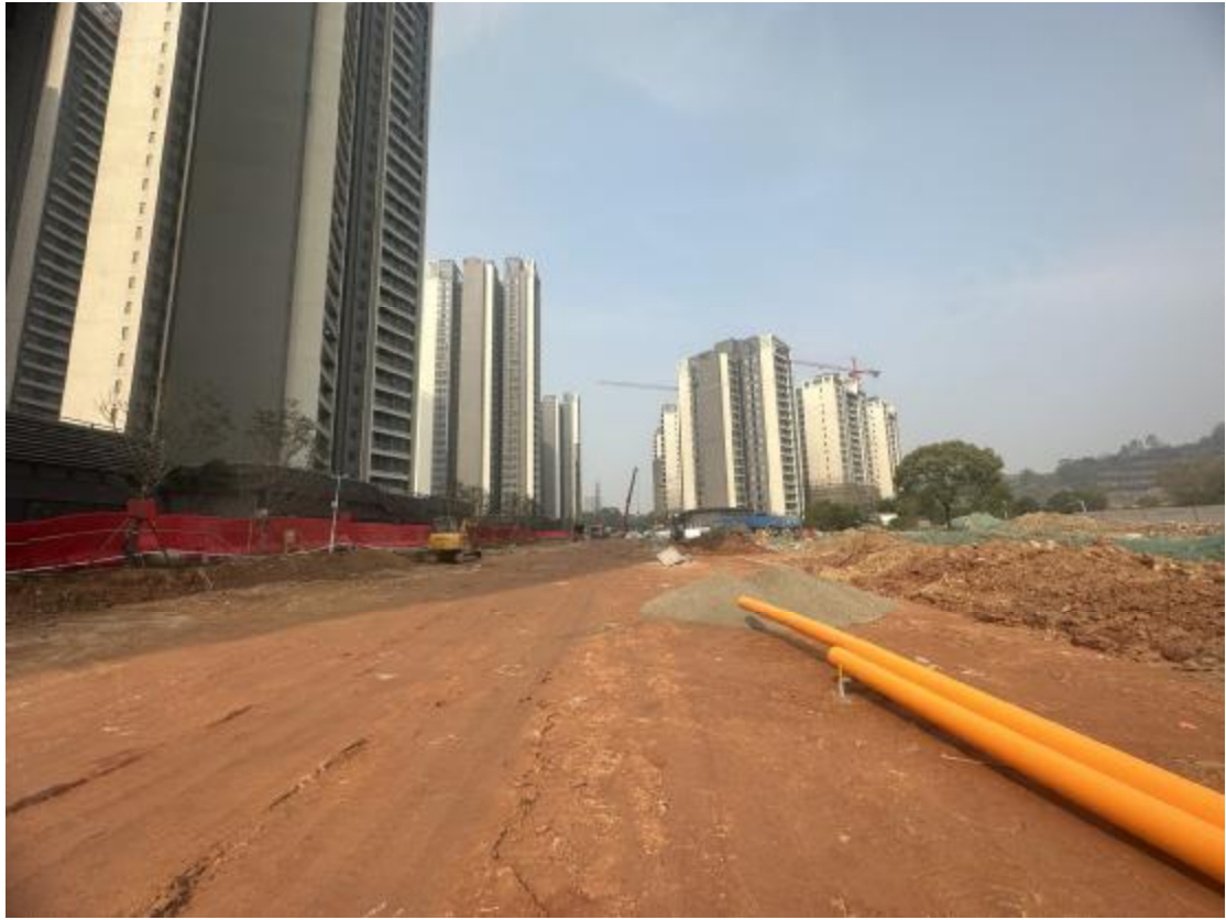
图 27 地块地表现状（东—西）
