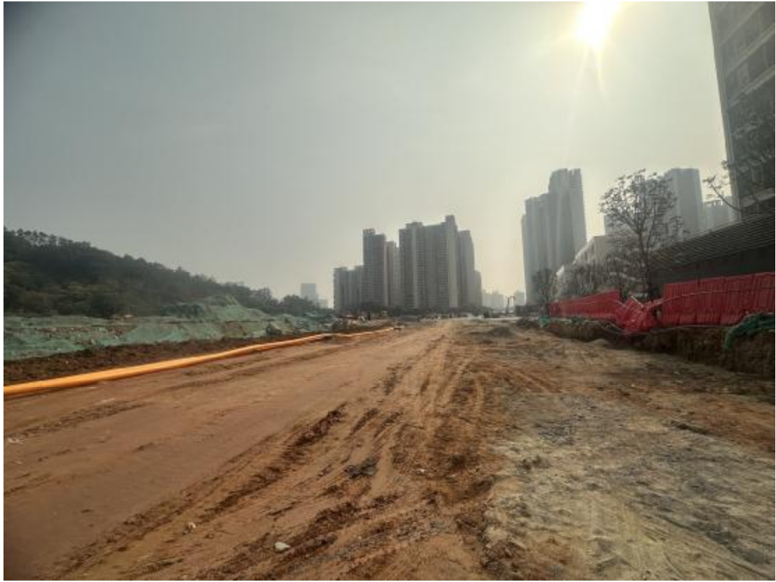
图 25 地块地表现状（西—东）
