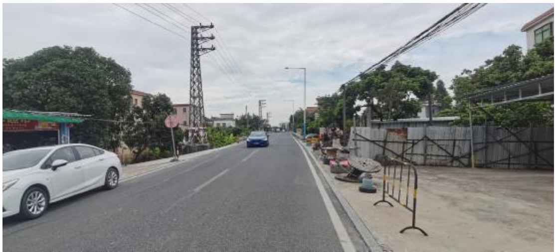
图 9 工程用地地表现状（东—西）
