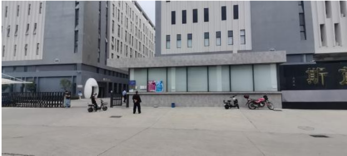
图 17 工程用地地表现状（西—东）
