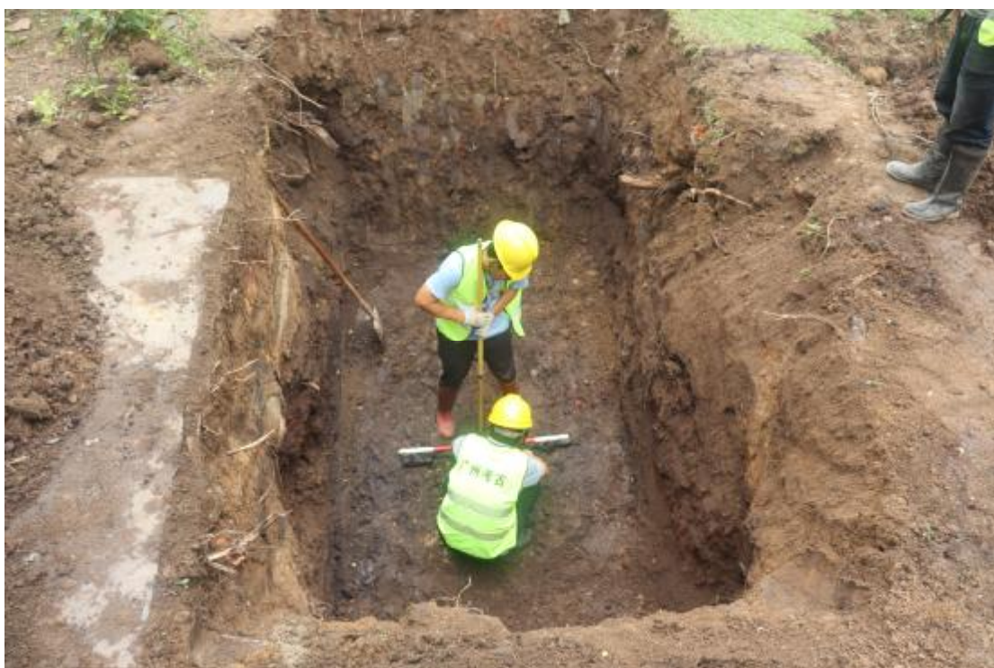
图 37 探沟底部钻探工作照（南-北）
