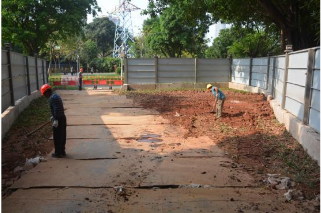
图 22 地块北部现状（东-西）
