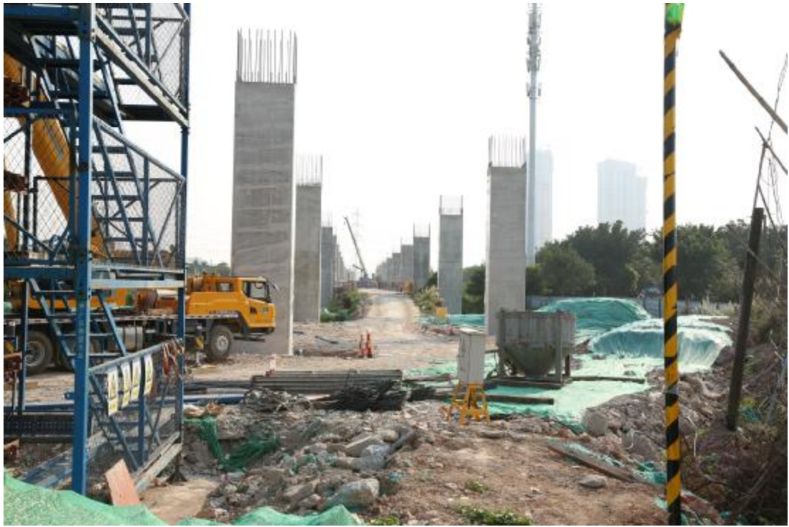
图 14 项目北部地表现状（东北-西南）
