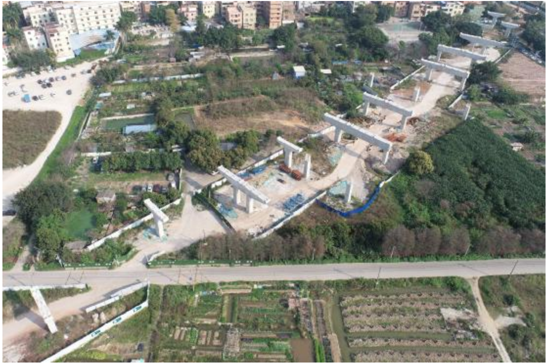
图 12 项目南部现状航拍（西北-东南）
