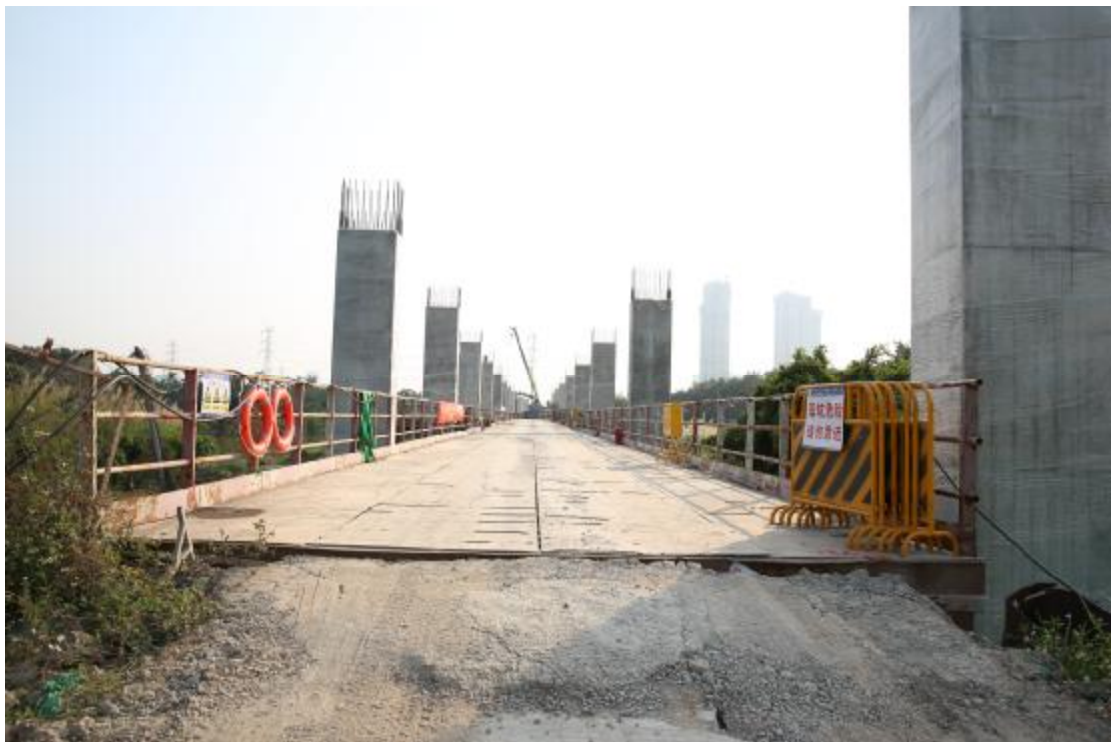
图 15 项目北部地表现状（东北-西南）
