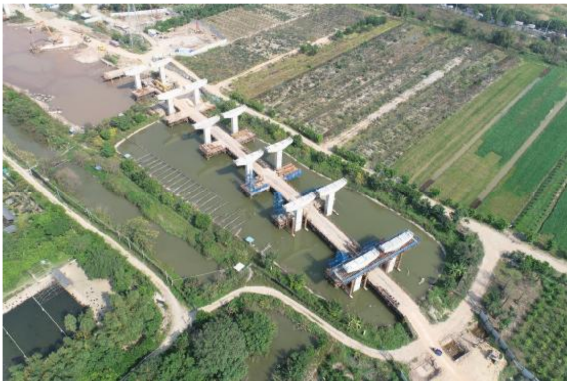
图 8 项目中北部现状航拍（东北-西南）
