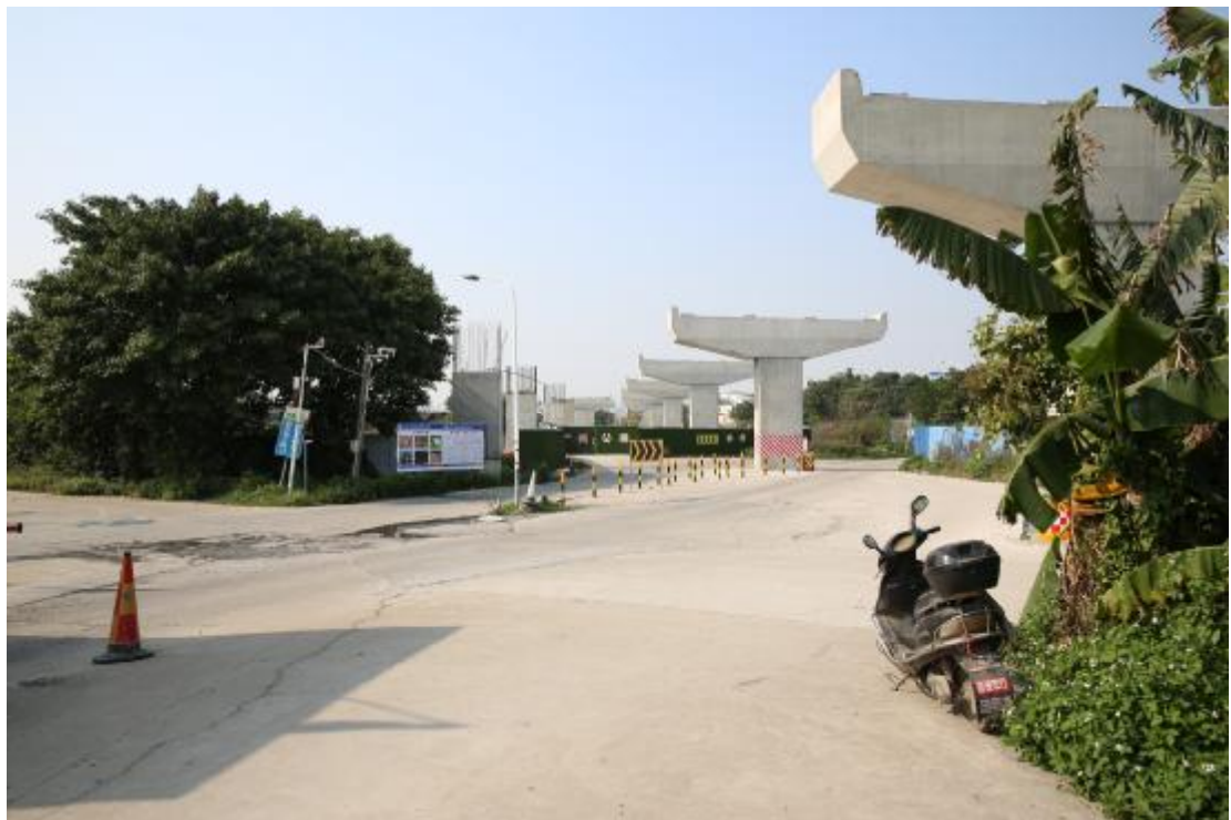
图 23 项目南部地表现状（东南-西北）
