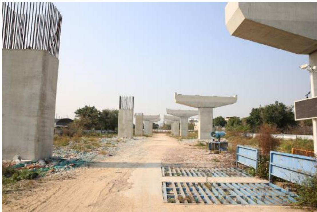
图 24 项目南部地表现状（东南-西北）
