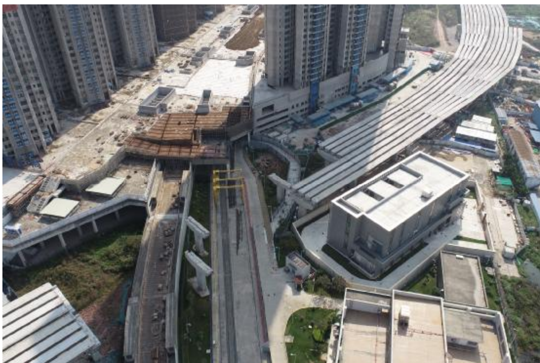
图 9 项目中部现状航拍（东北-西南）
