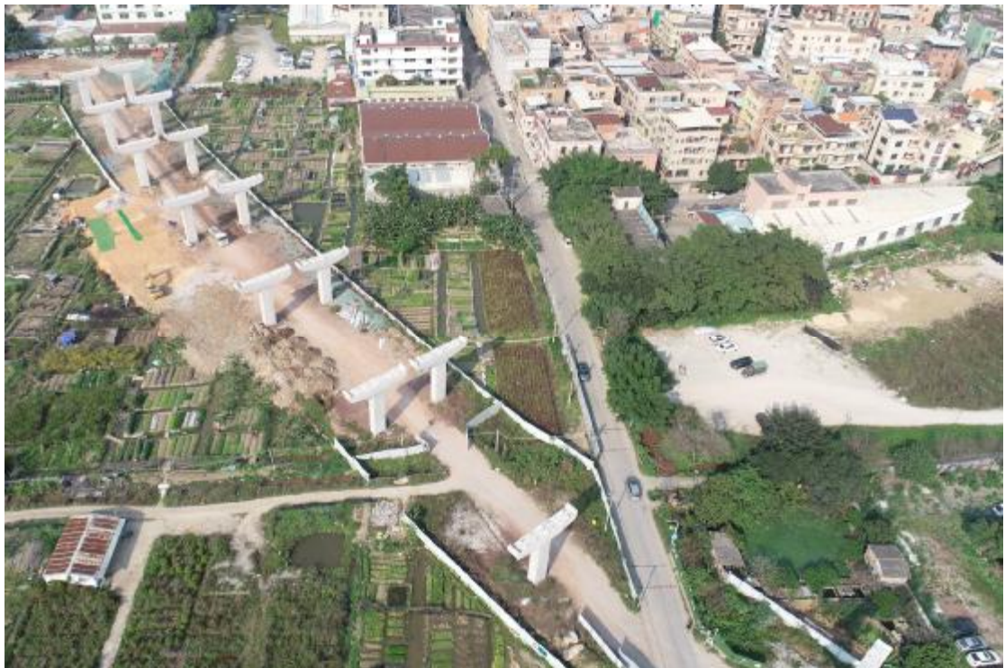
图 13 项目南部现状航拍（西南-东北）
