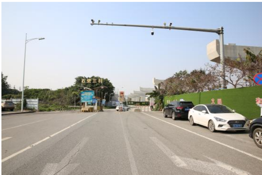
图 25 项目南部地表现状（东南-西北）
