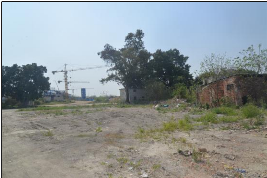
图 35 地块一西部现状（北-南）
