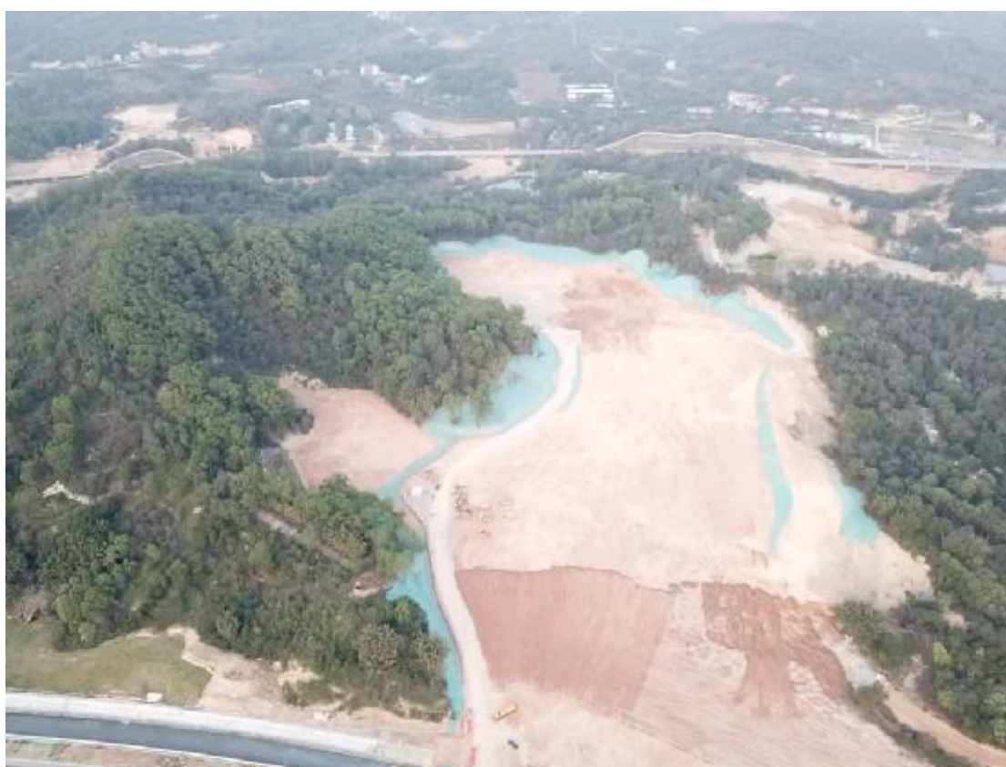
图 19 地块中部地表现状
