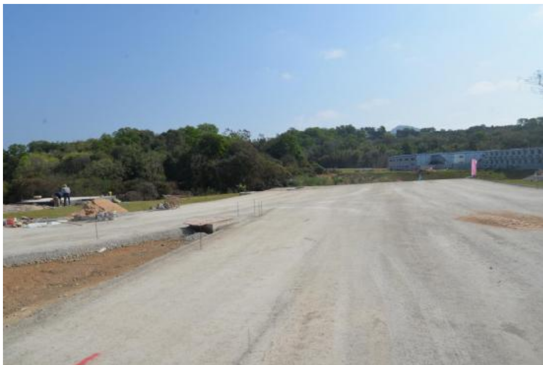
图 28 地块南部地表现状
