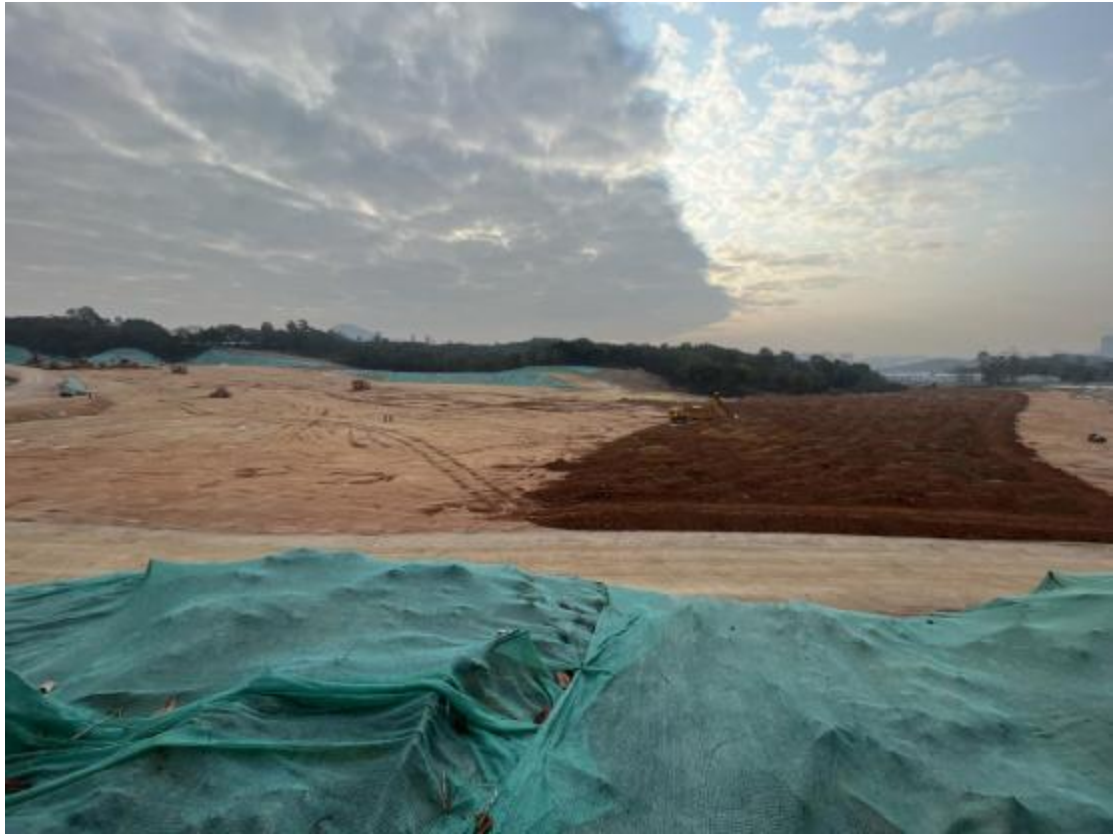
图 20 地块中部地表现状
