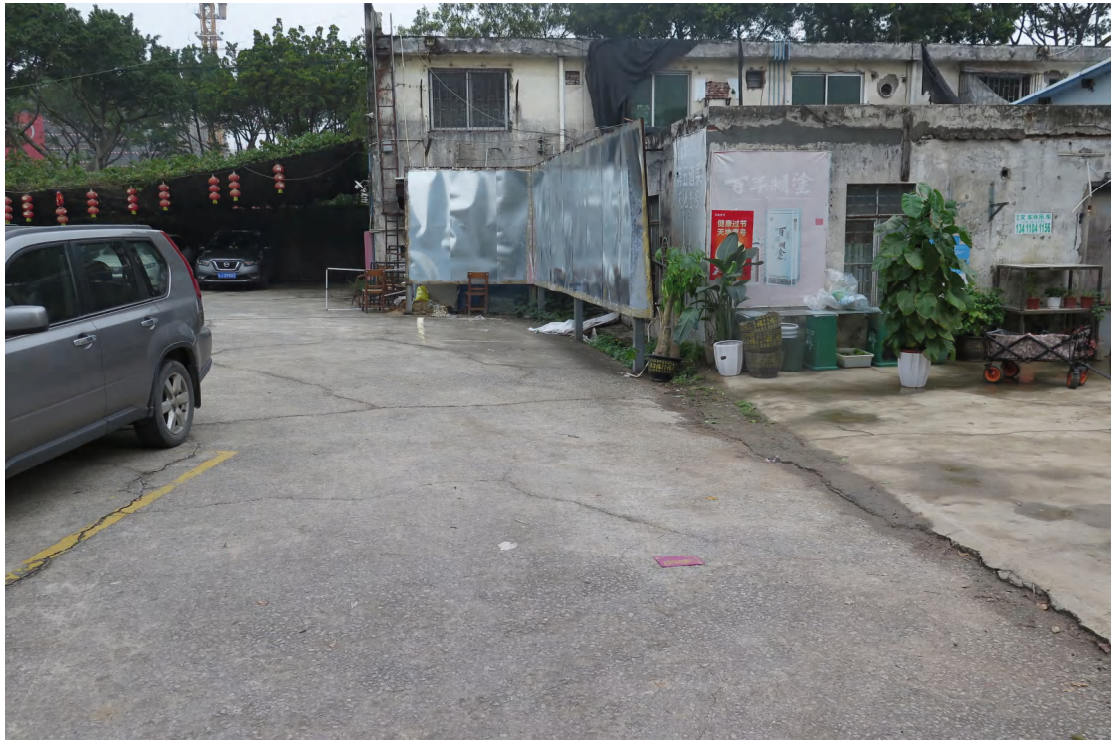
图 17 东部地块内现状（南-北）
