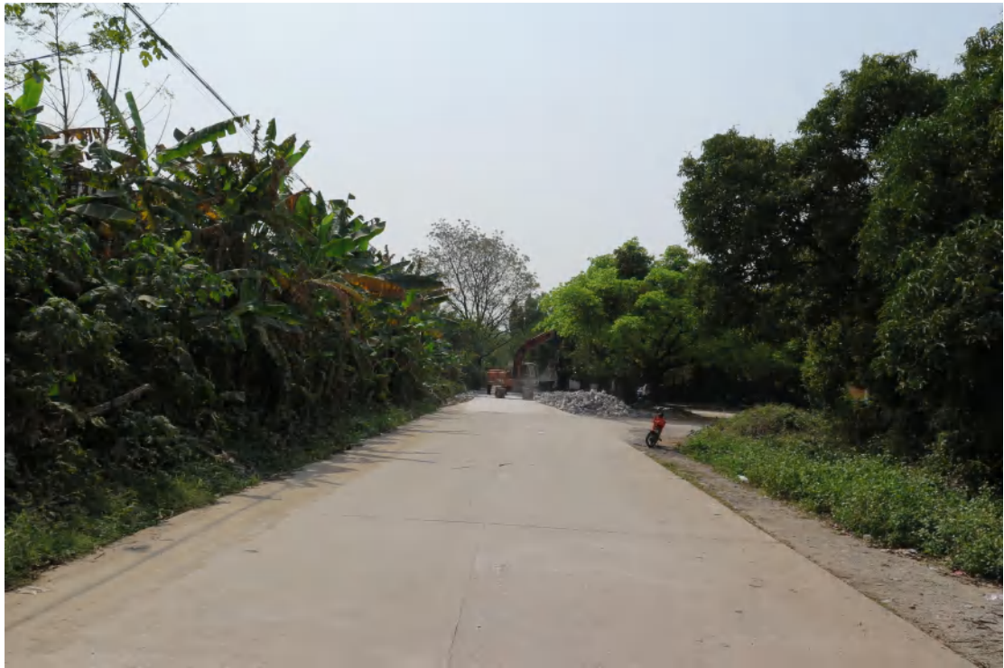
图 27 地块内中部现状（北-南）
