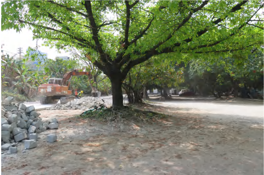
图 26 地块内中部现状（北-南）
