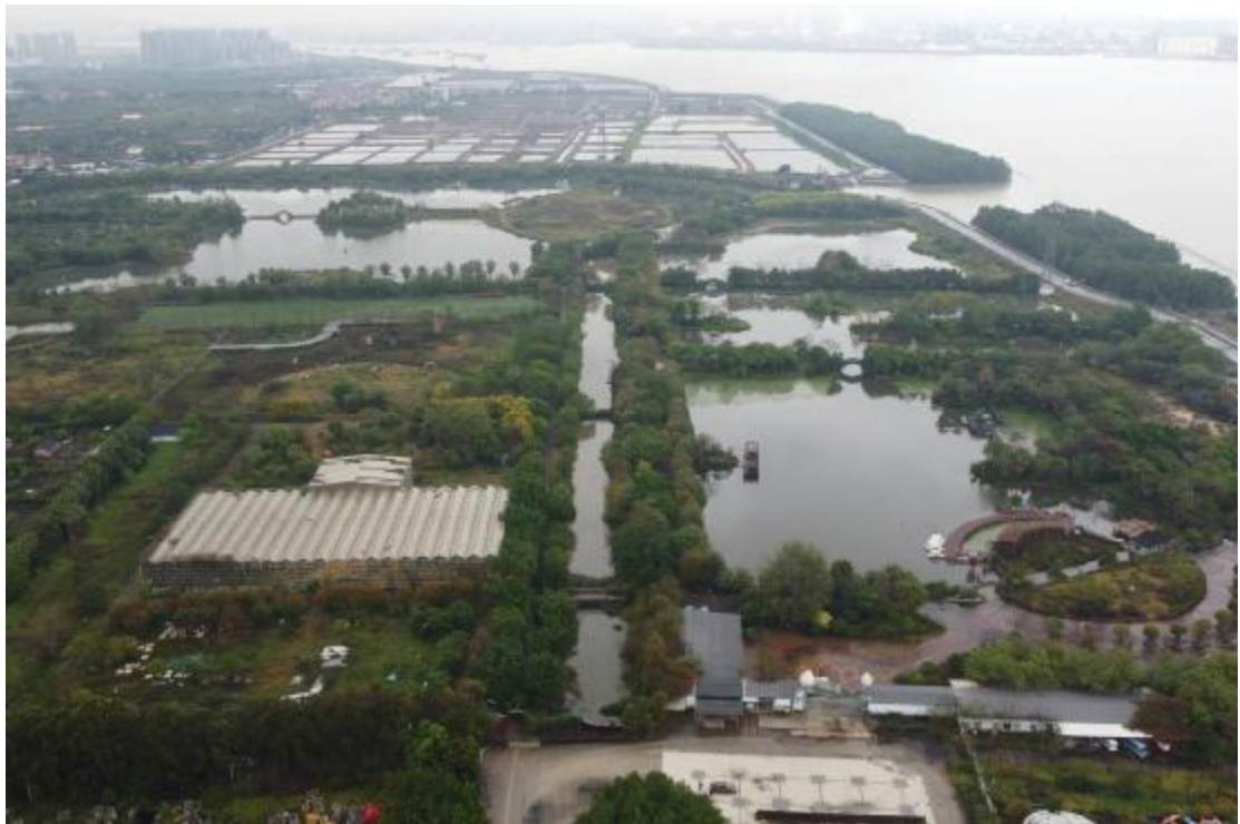
图 21 项目工程番禺段北部现状（南-北）
