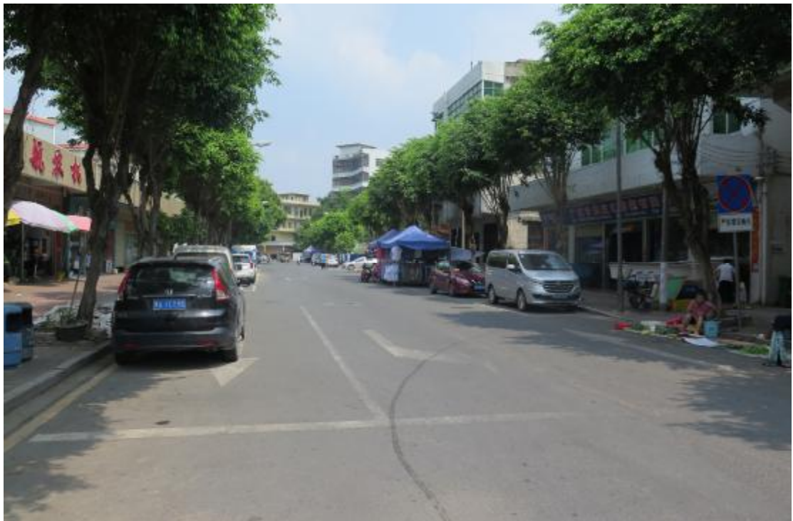
图 35 项目工程番禺段南部现状（南-北）
