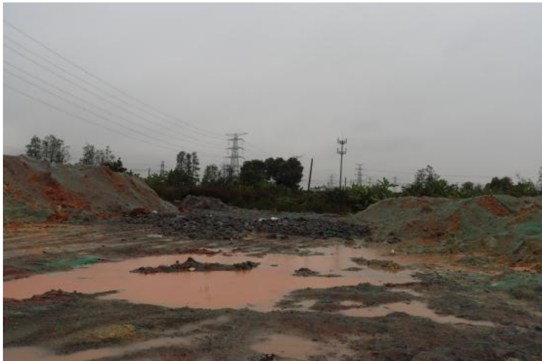
图 43 项目工程南沙段北部现状（东-西）
