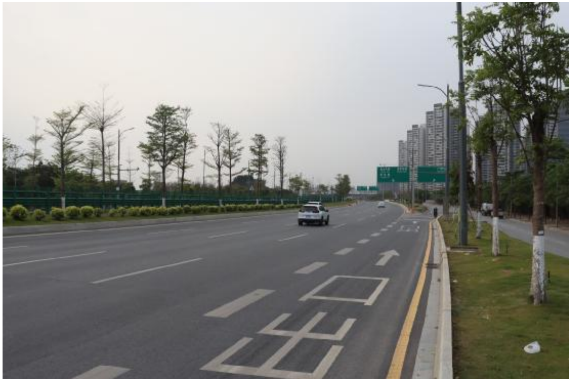
图 23 项目工程番禺段北部现状（南-北）
