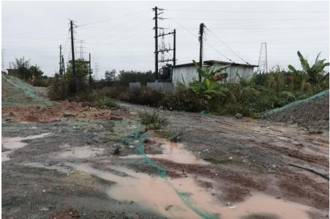
图 44 项目工程南沙段北部现状（东-西）
