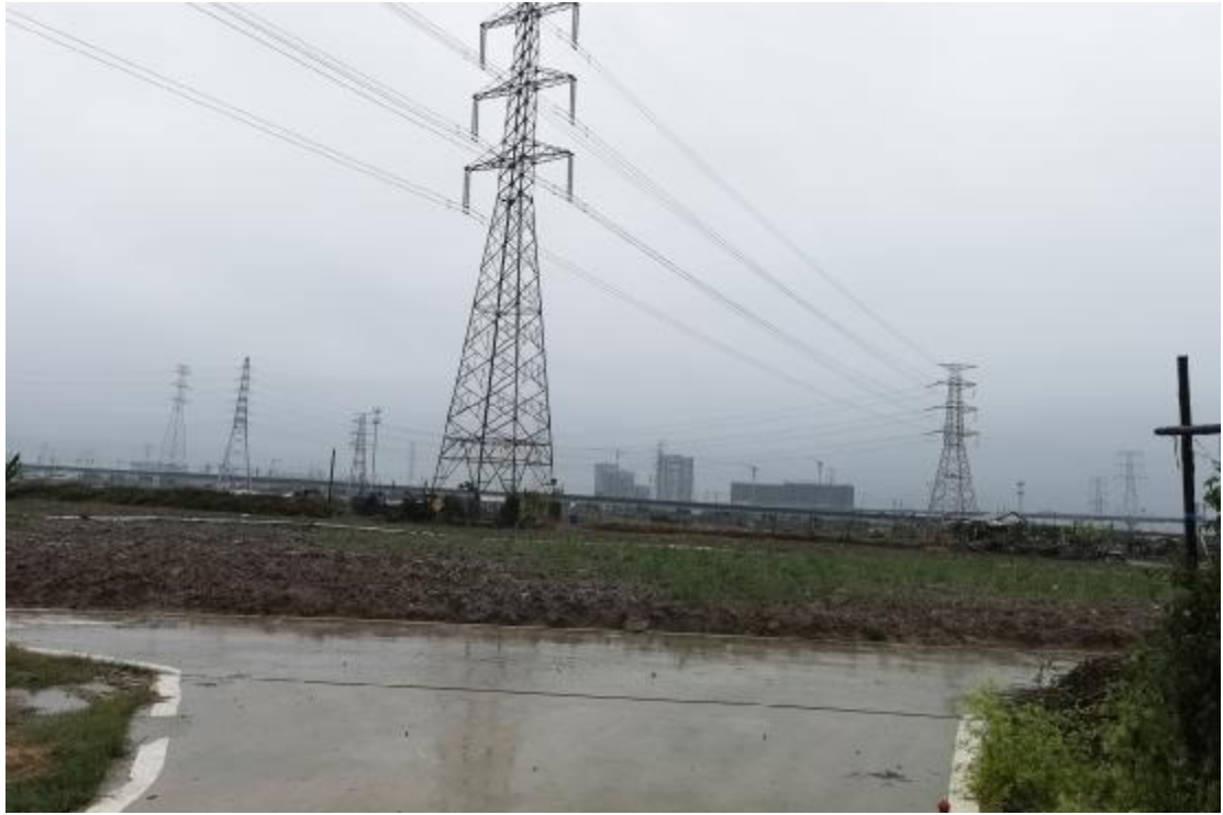
图 52 项目工程南沙段中部现状（南-北）
