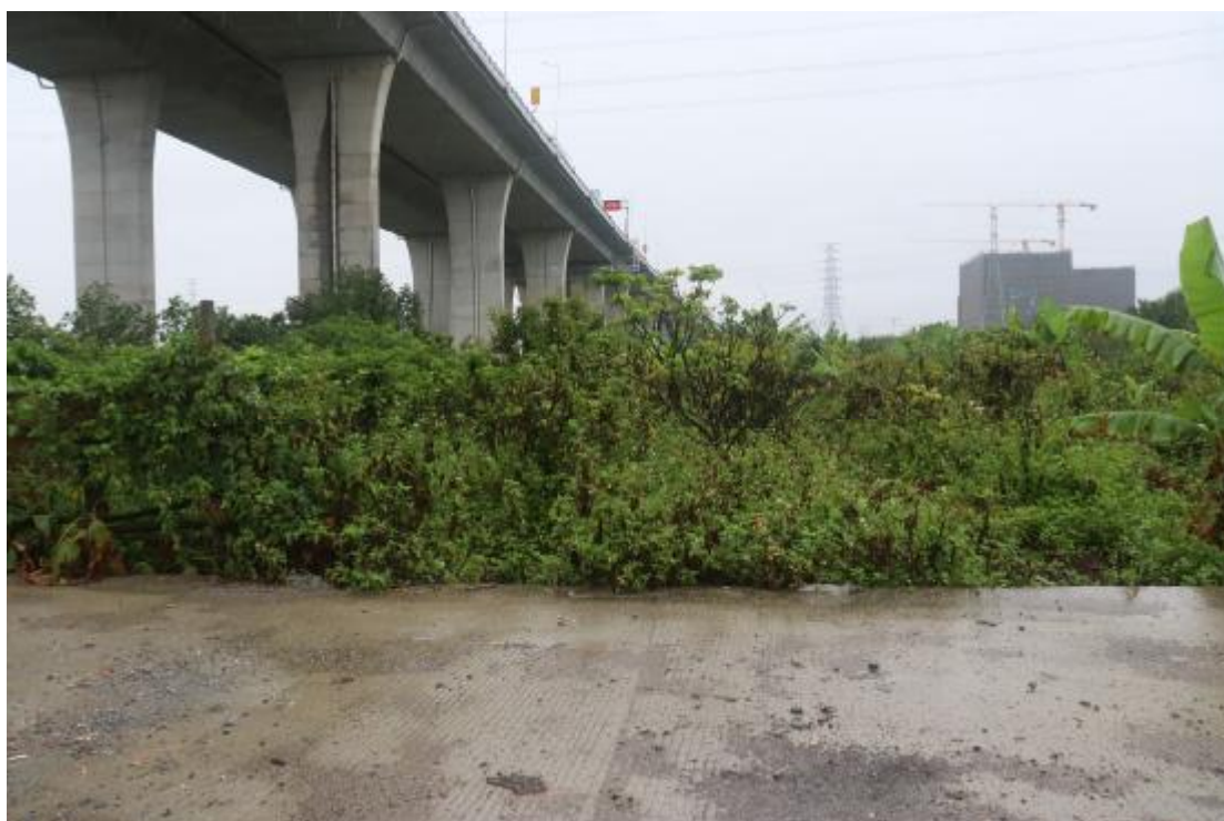
图 55 项目工程南沙段中部现状（西-东）
