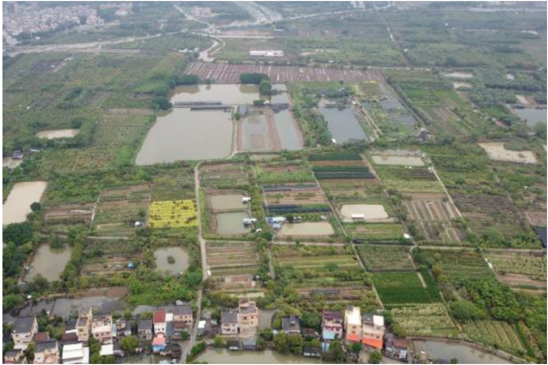
图 20 项目工程番禺段北部现状（南-北）
