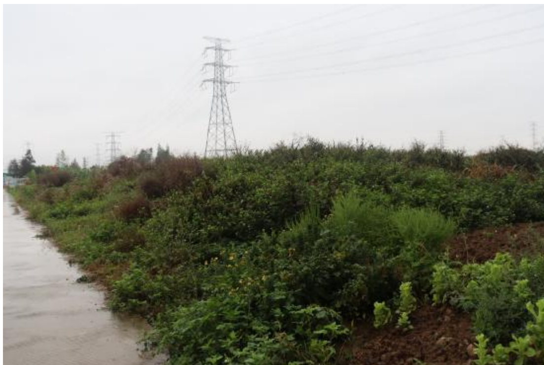
图 54 项目工程南沙段中部现状（西北-东南）
