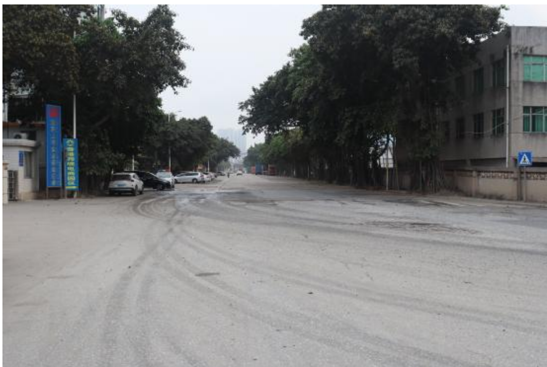
图 25 项目工程番禺段中部现状（北-南）
