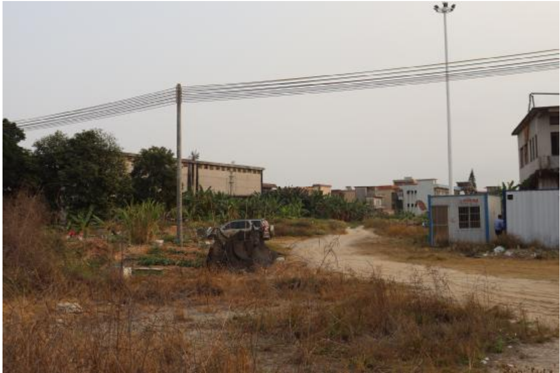
图 26 项目工程番禺段中部现状（北-南）
