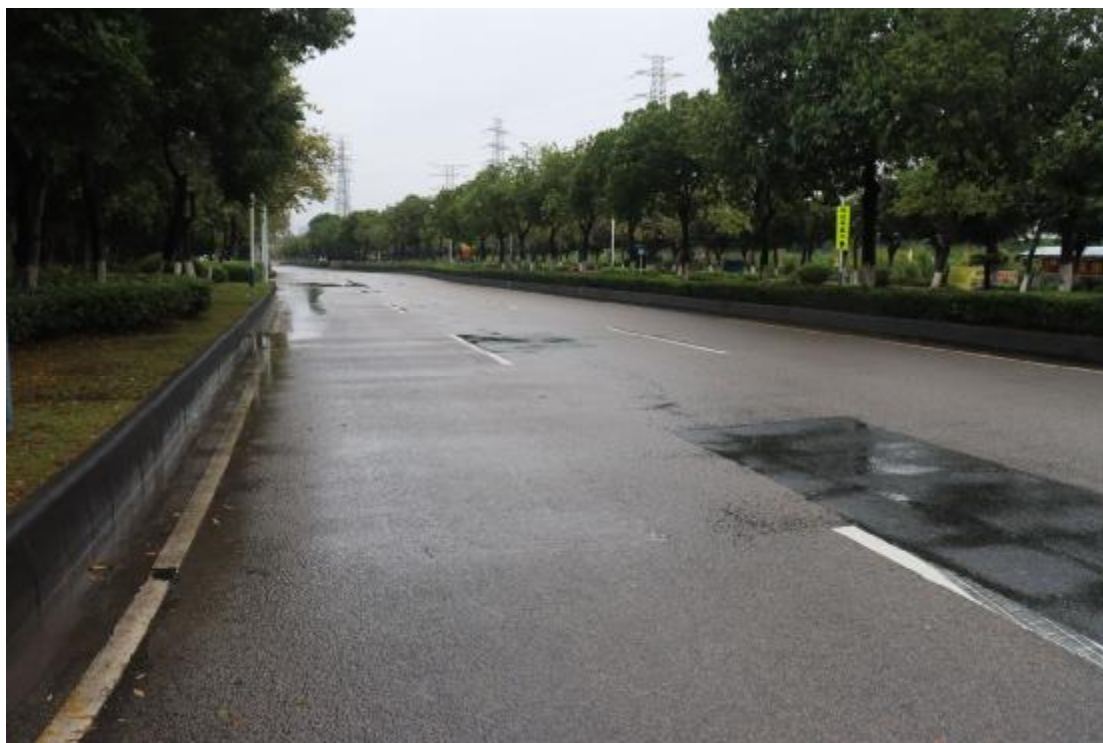
图 62 项目工程南沙段南部现状（西北-东南）
