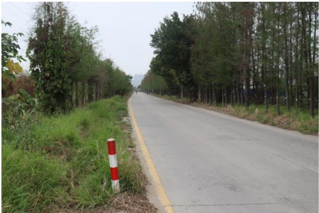
图 29 项目工程番禺段中部现状（南-北）
