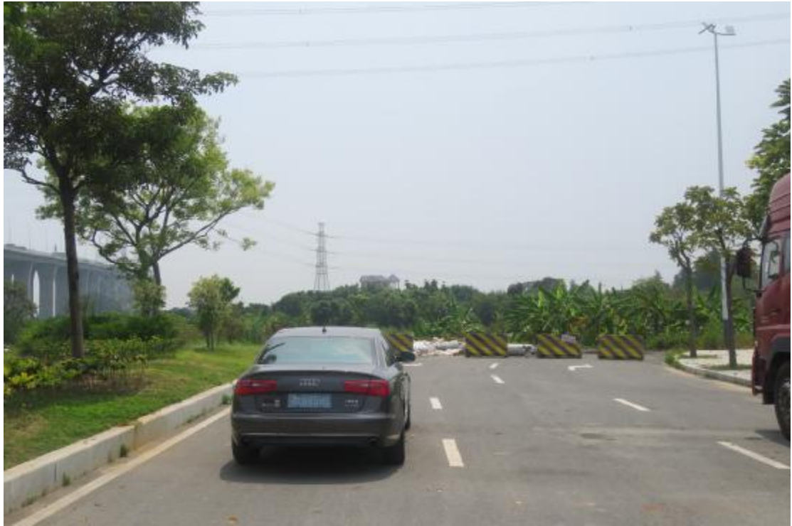
图 64 项目工程南沙段南部现状（西-东）
