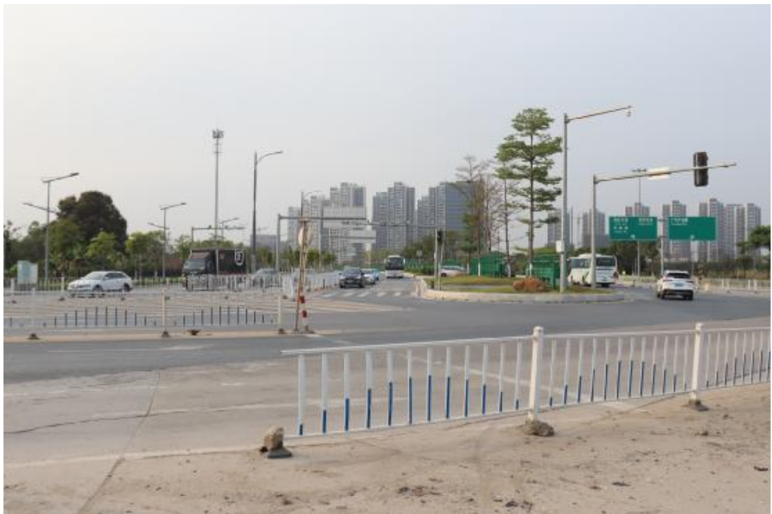
图 39 项目工程番禺段南部现状（南-北）
