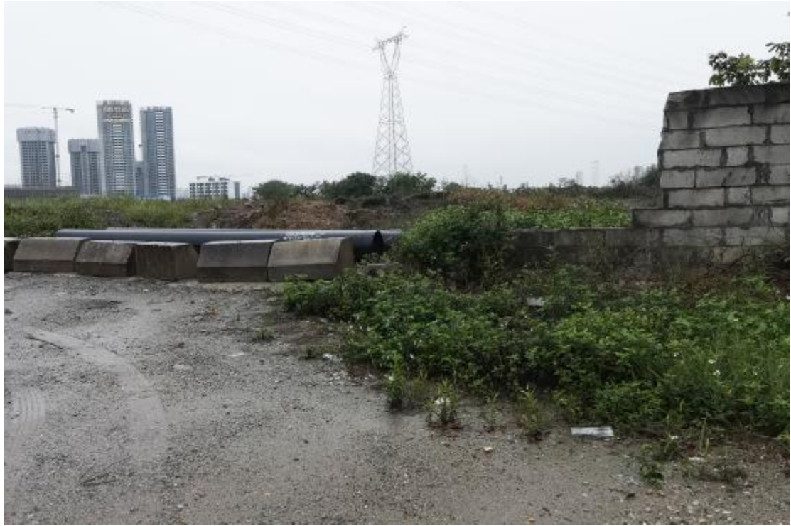
图 46 项目工程南沙段北部现状（南-北）
