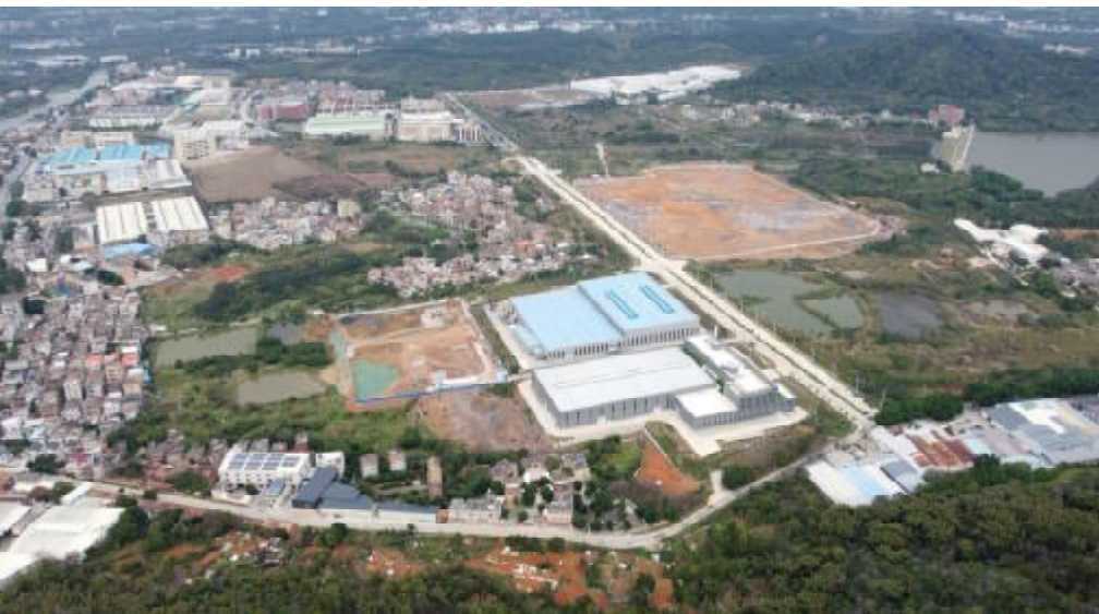
图 11 地块南部厂房现状（东-西）
