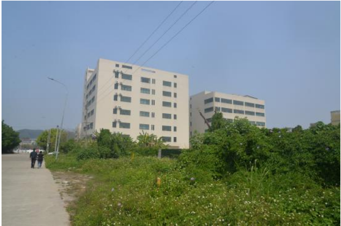
图 22 地块内部地表现状（南-北）
