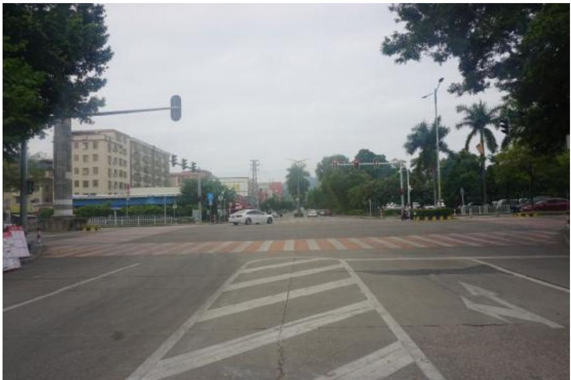
图 15 地块内部地表现状（南-北）
