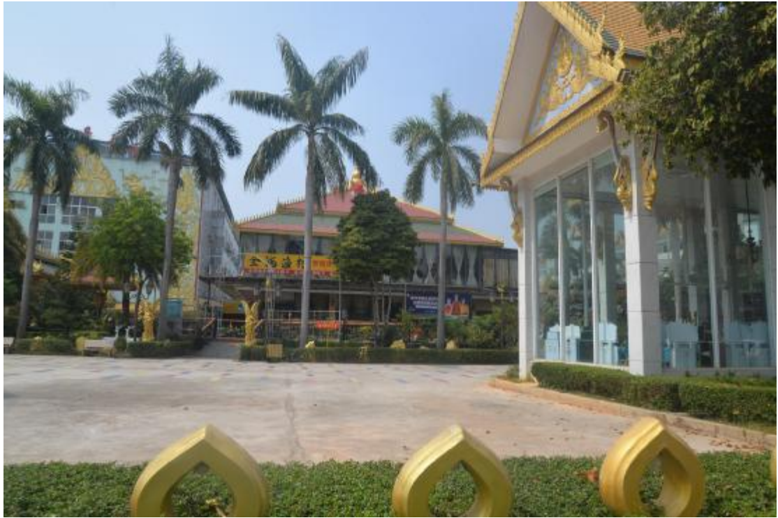
图 26 地块内部地表现状（北-南）
