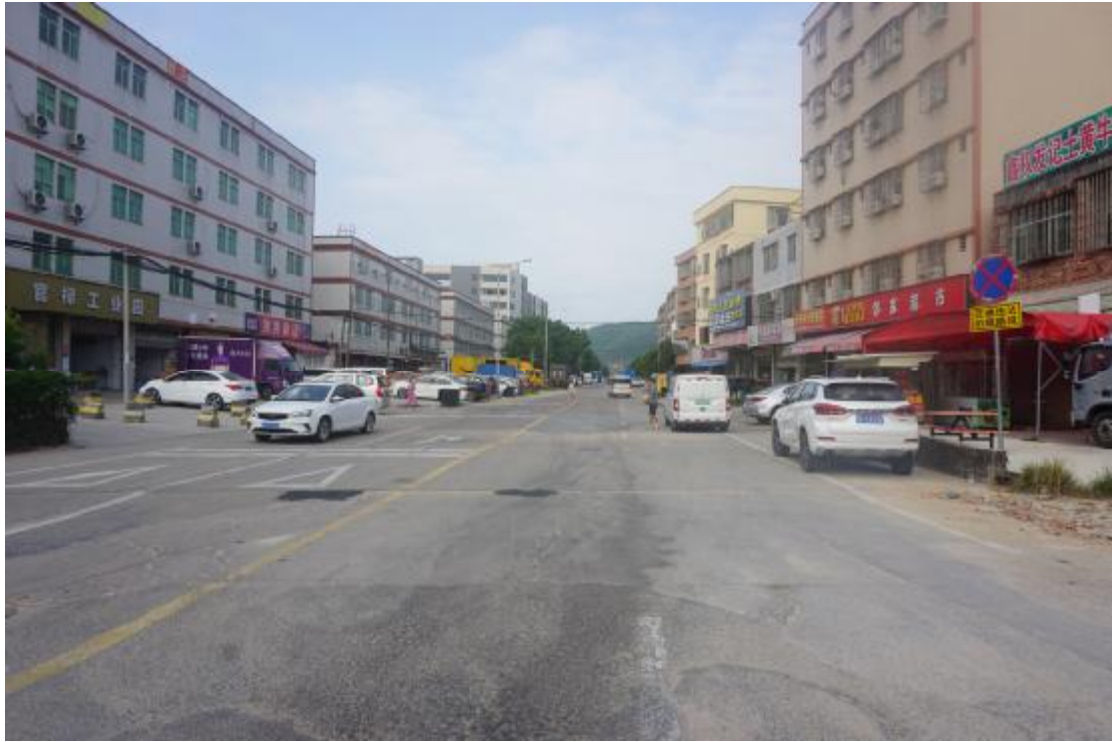
图 12 地块内部地表现状（南-北）
