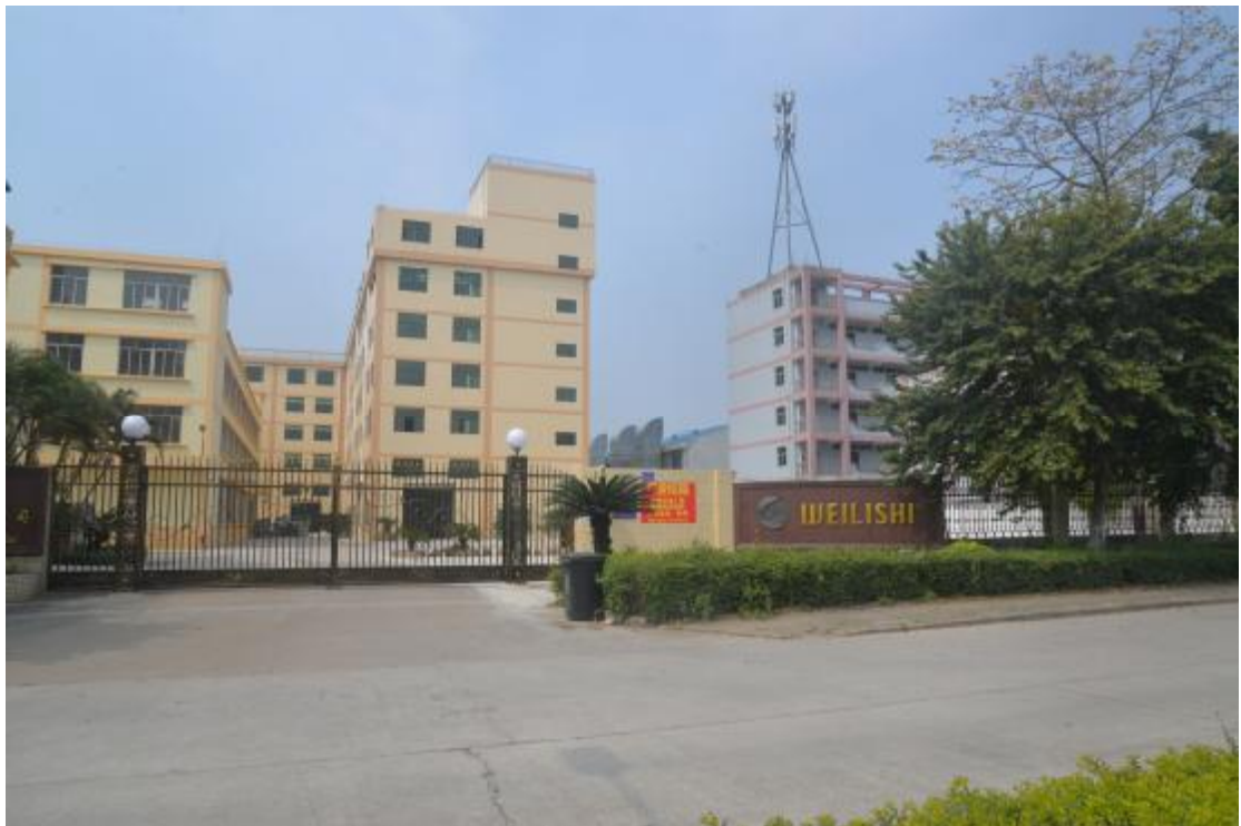
图 19 地块内部地表现状（南-北）
