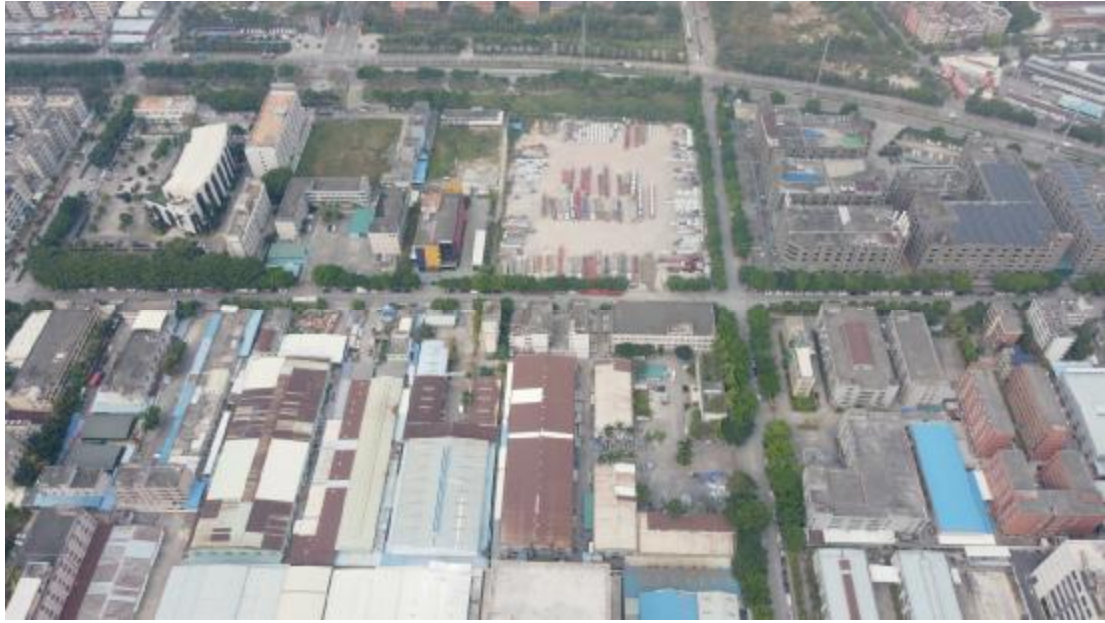
图 8 地块二中部地表现状（东-西）
