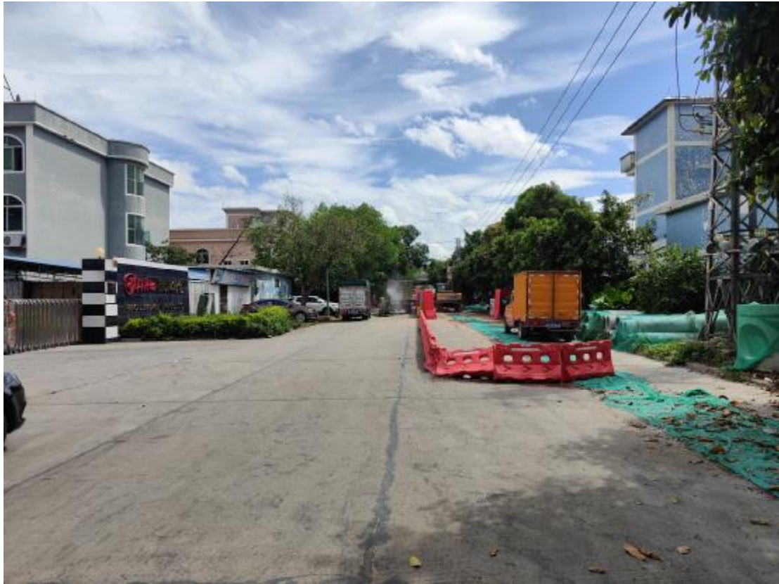
图 16 项目地块内部地貌（西-东）
