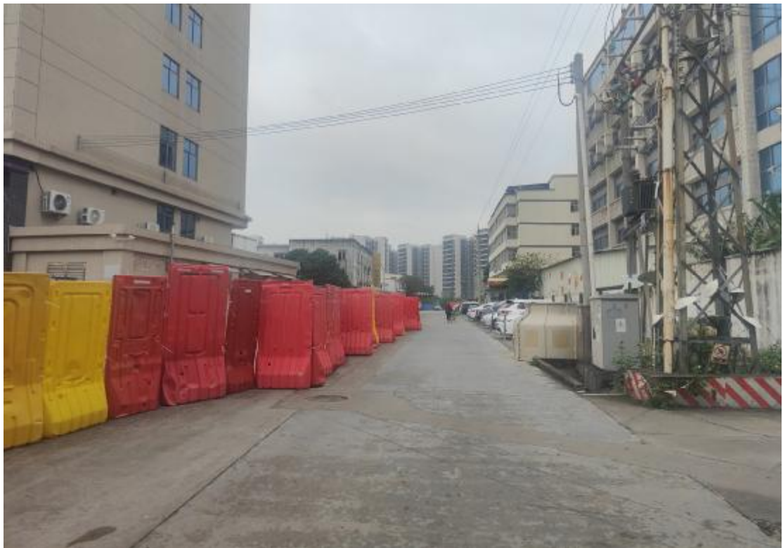
图 21 项目地块内部地貌（东-西）
