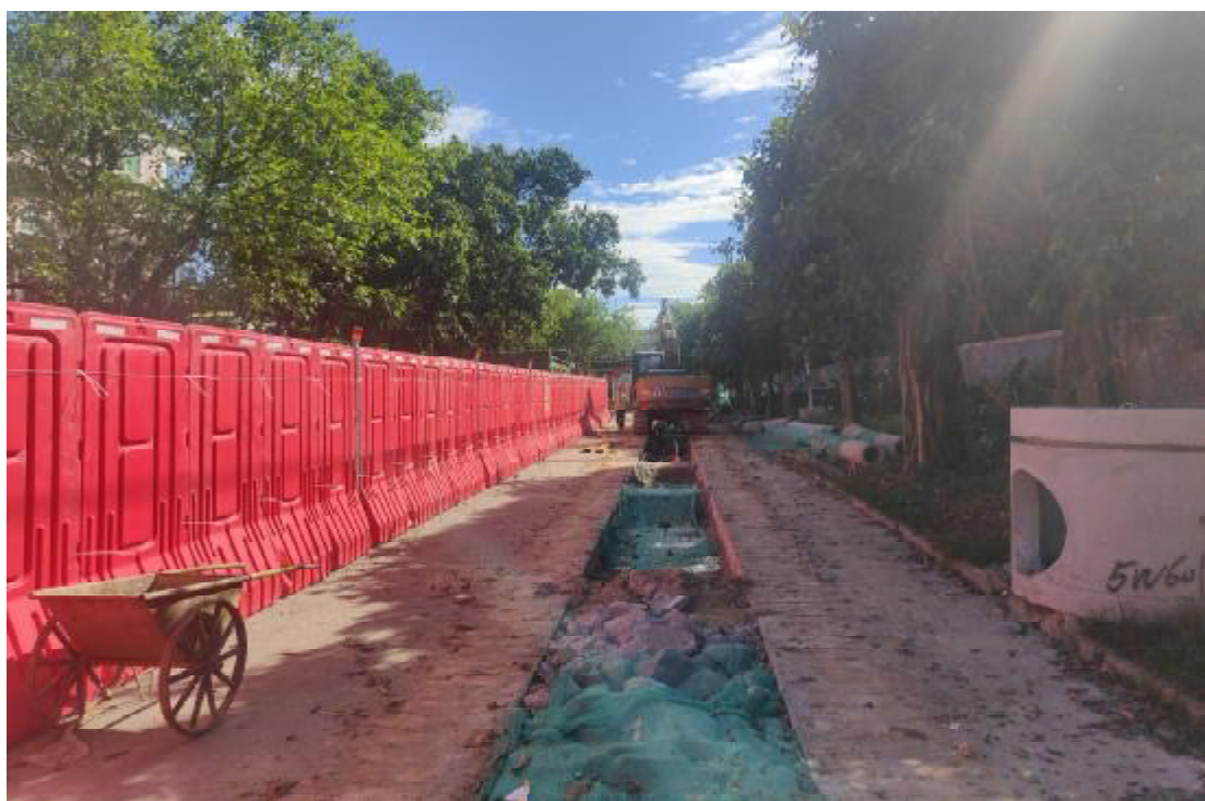
图 15 项目地块内部地貌（东-西）
