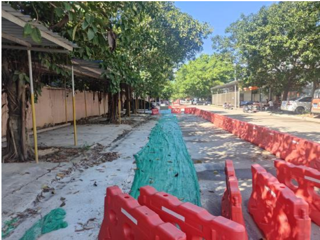
图 17 项目地块内部地貌（东-西）
