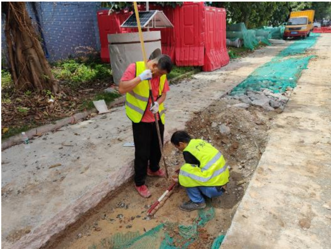
图 23 现场试探（北-南）
