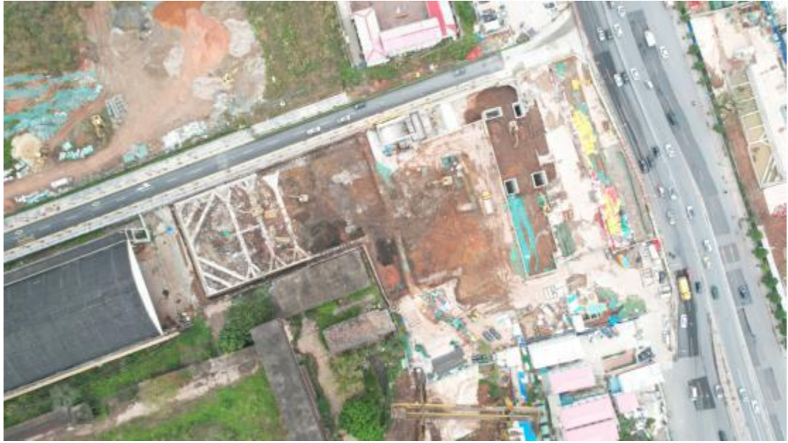
图 31 项目工程清表后现状（上北-下南）
