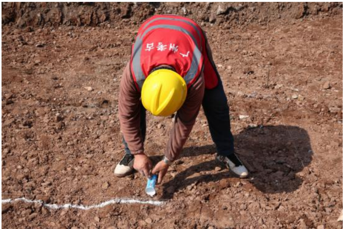
图 63 布设探沟（东-西）
