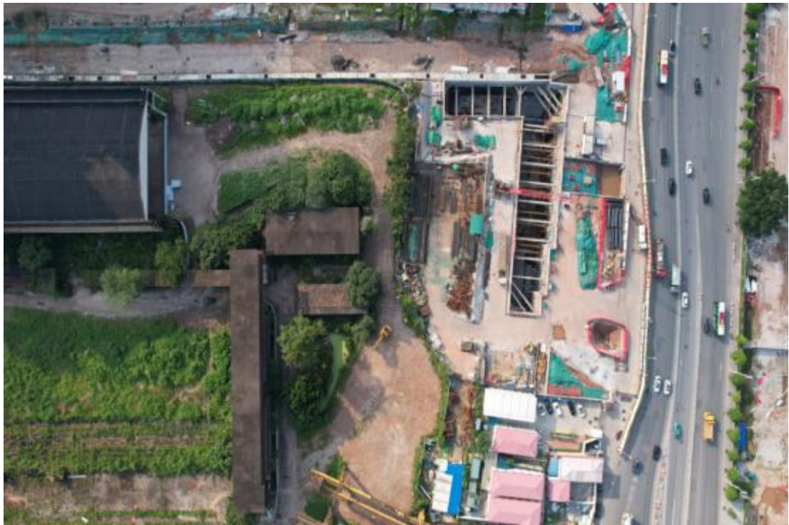
图 13 地块全景航拍图（上北-下南）
