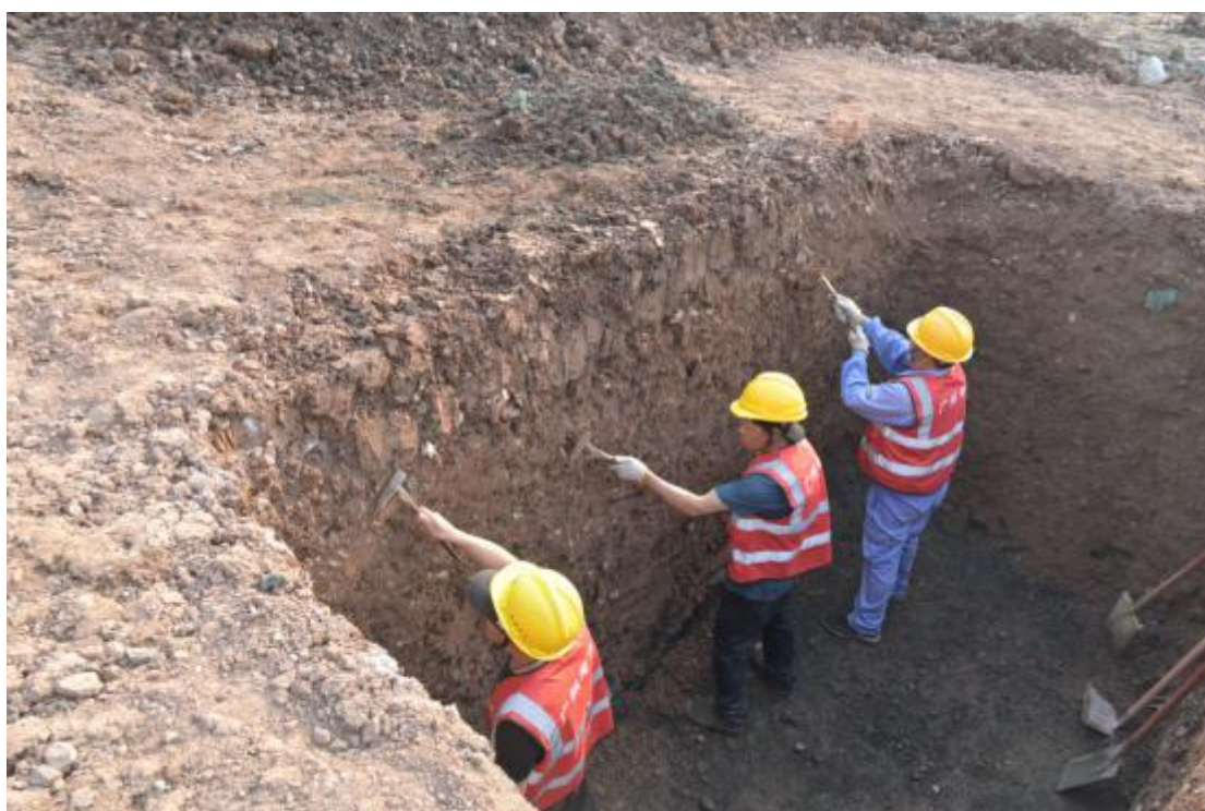
图 66 修整探沟壁（西南-东北）
