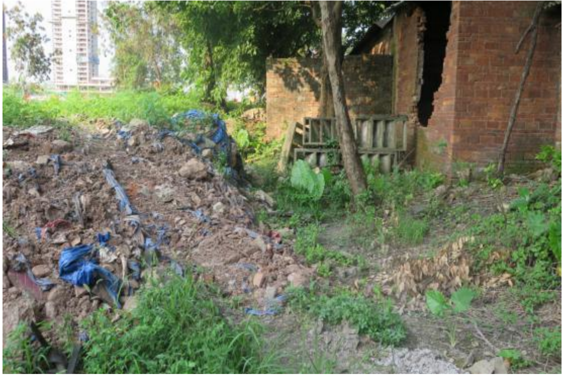
图 26 地块内中部现状（南-北）
