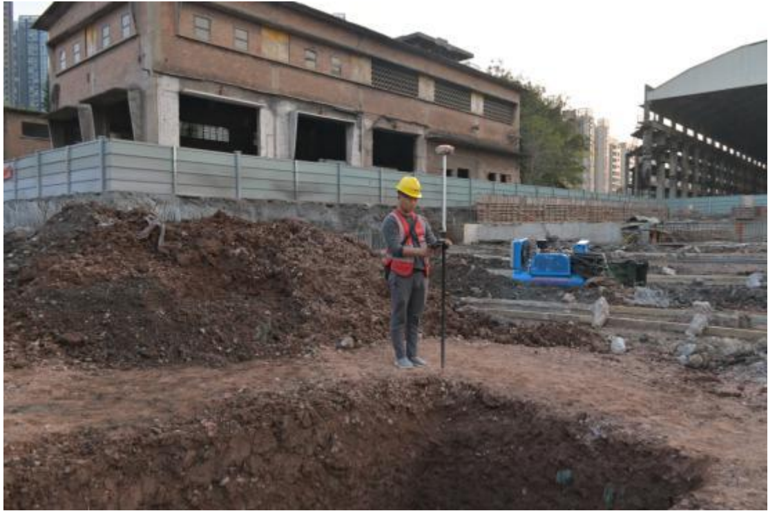
图 70 RTK 测量工作照（东北-西南）
