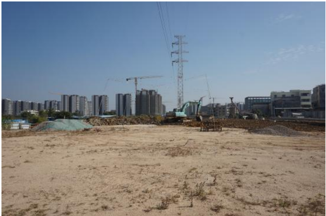
图 15 地块内部现状（北-南）
