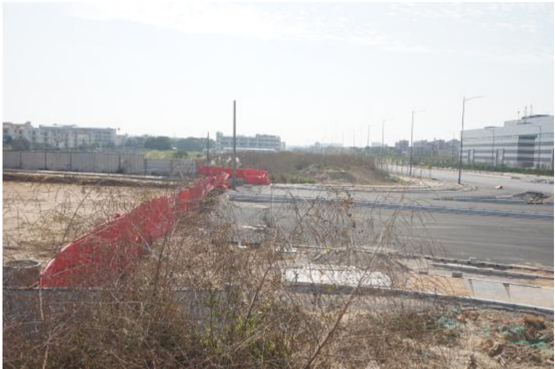
图 19 地块内部现状（东-西）
