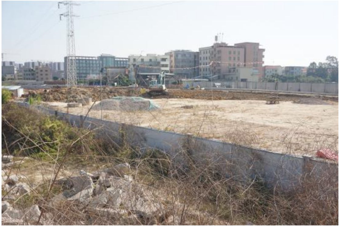
图 20 地块内部现状（北-南）
