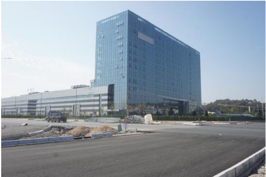
图 14 地块内部现状（东南-西北）
