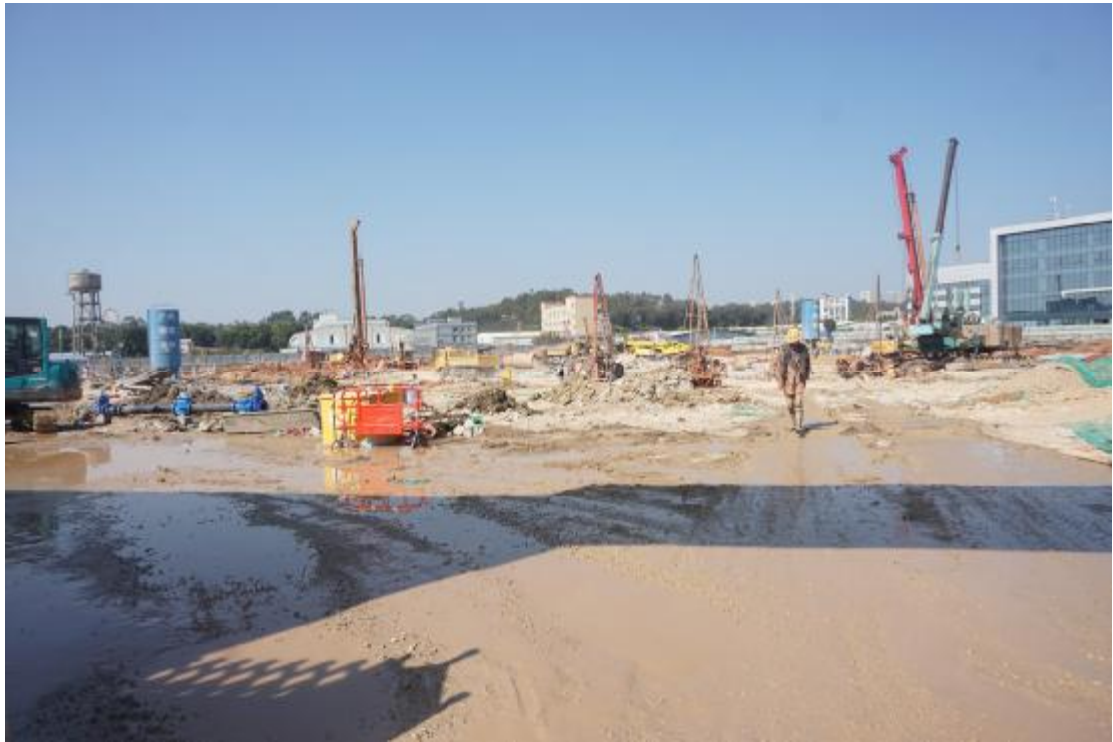
图 8 地块内部现状（东-西）
