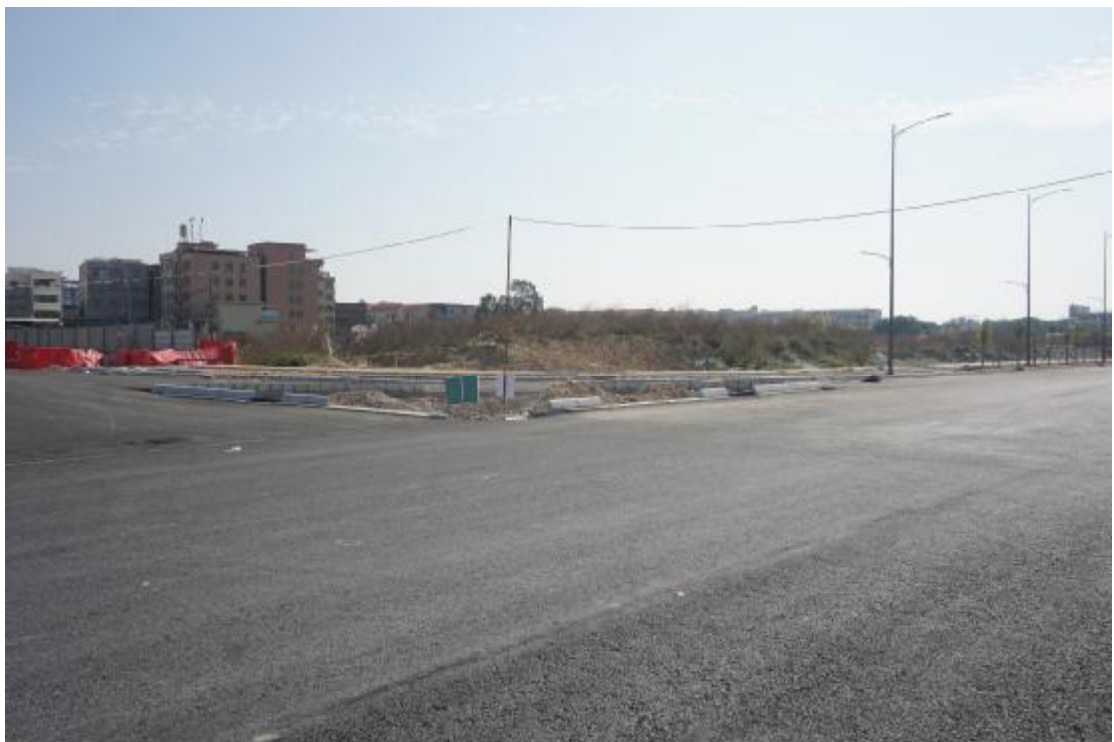
图 13 地块内部现状（东南-西北）
