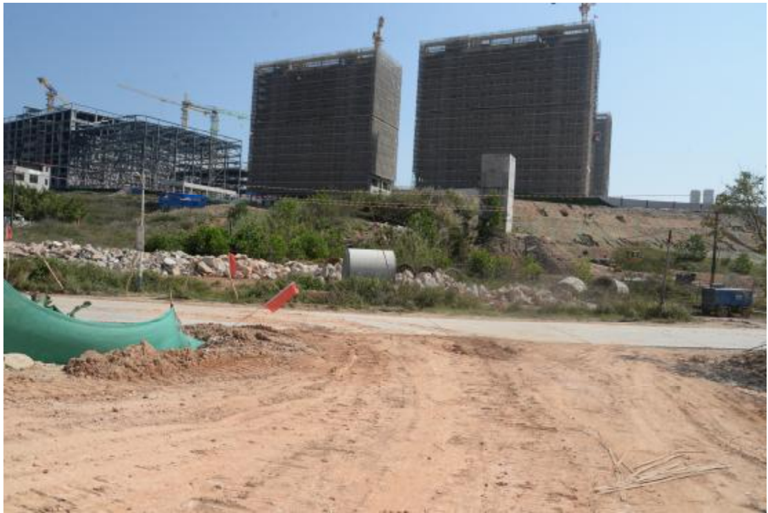
图 29 地表现状（东—西）
