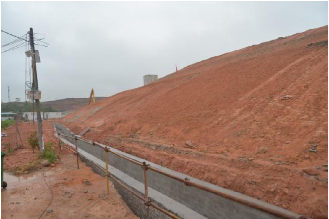
图 13 地表现状（东—西）
