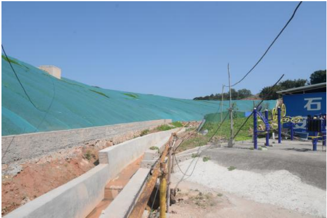
图 19 地表现状（北—南）
