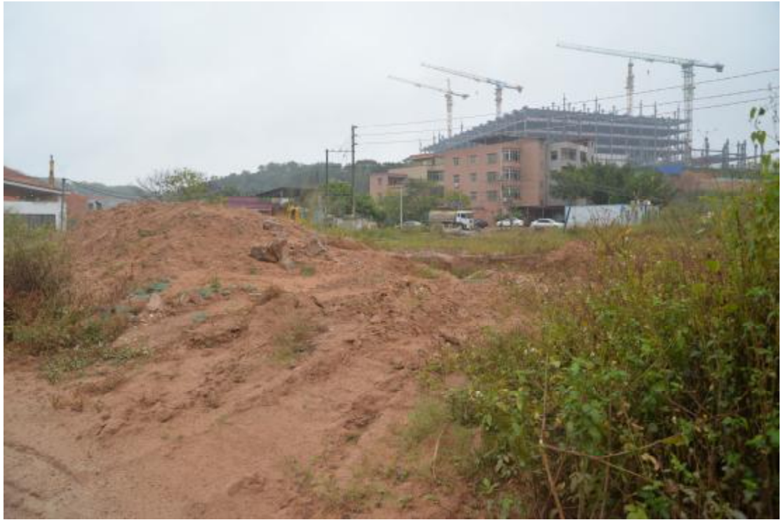
图 16 地表现状（北-南）
