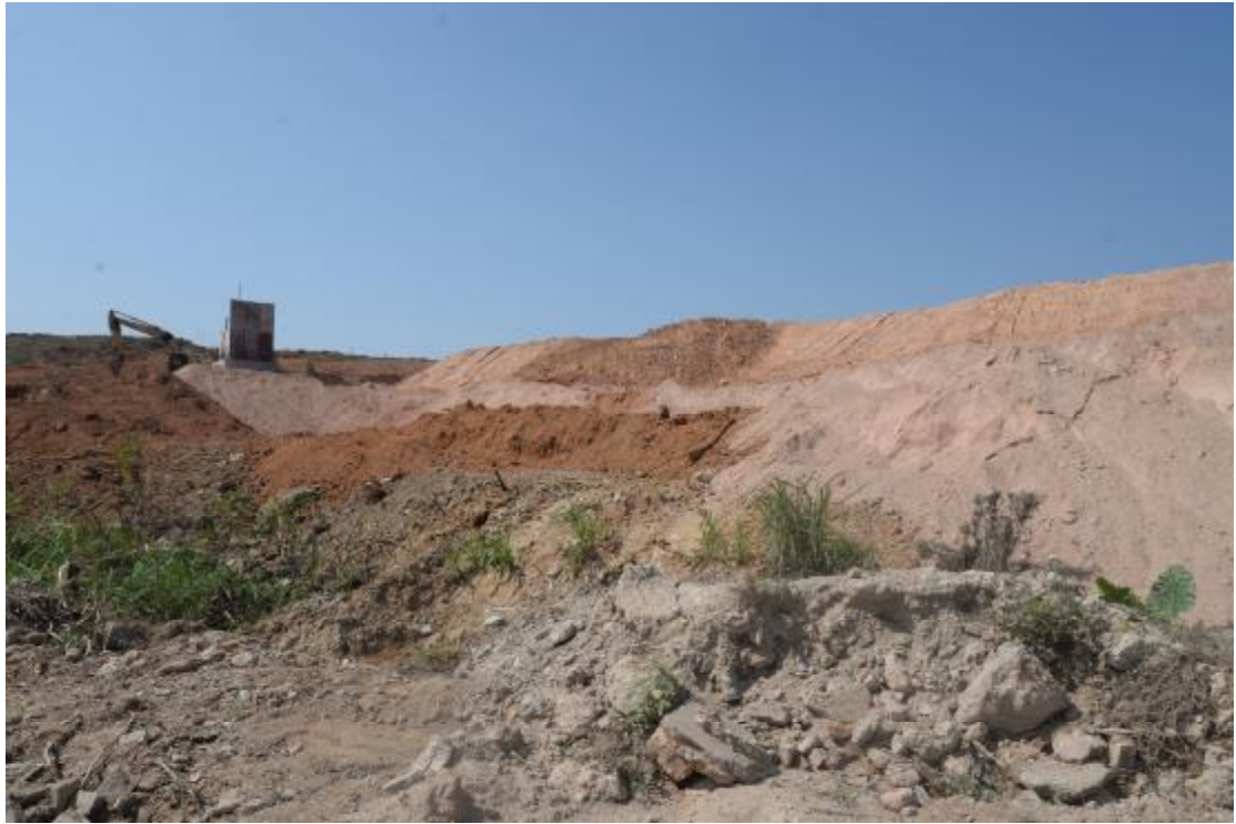
图 22 地表现状（东—西）
