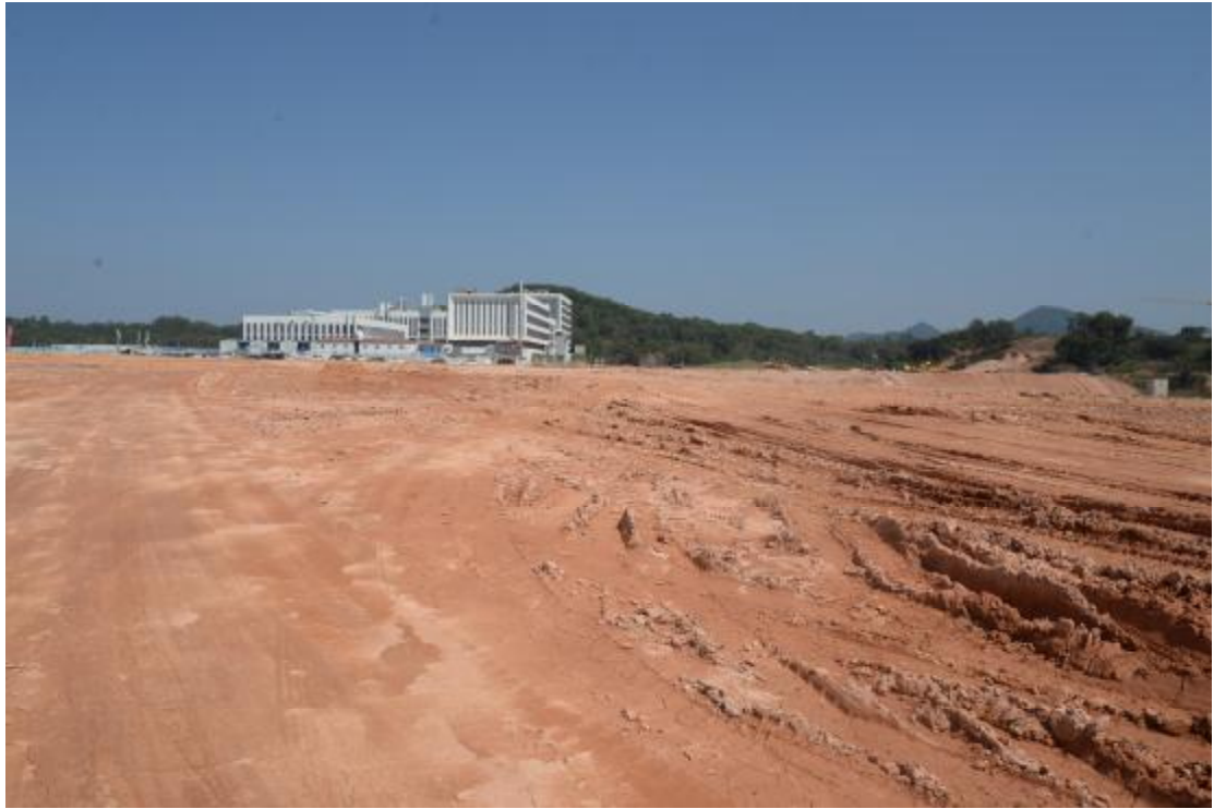
图 26 地表现状（北—南）
