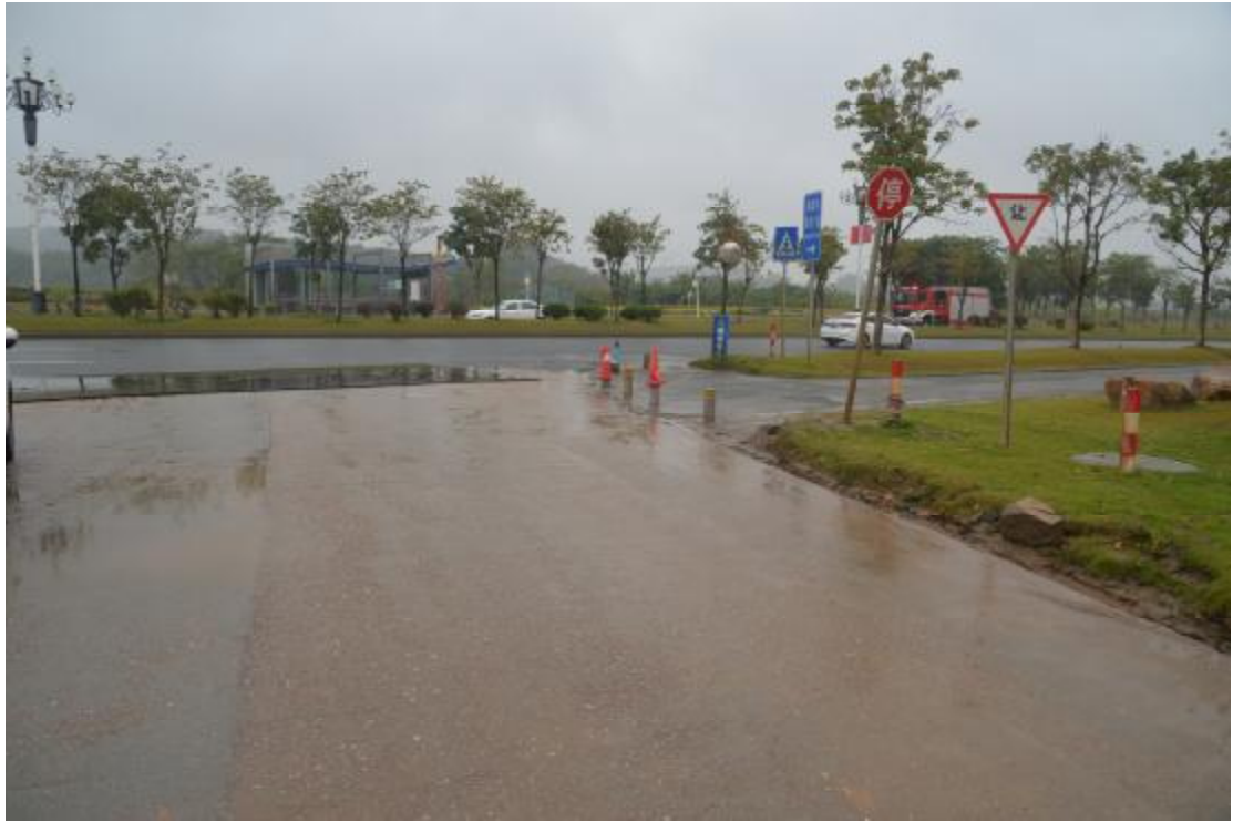
图 10 地表现状（东-西）
