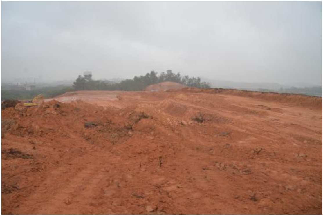
图 18 地表现状（南—北）
