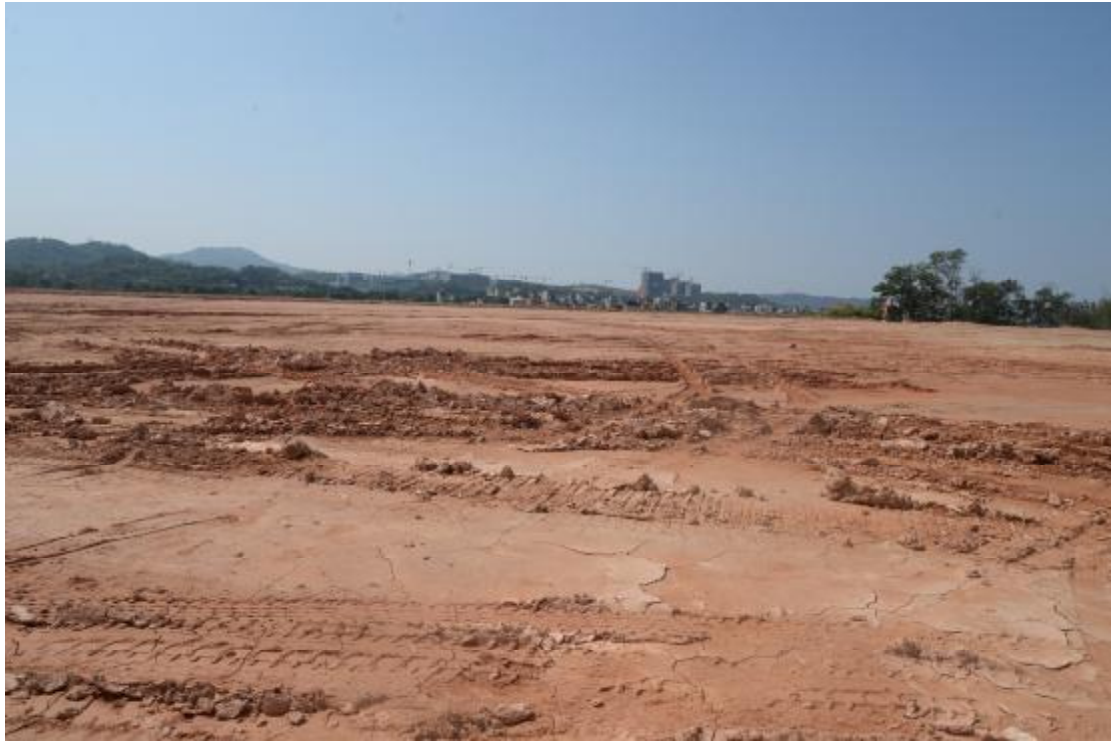
图 24 地表现状（南—北）
