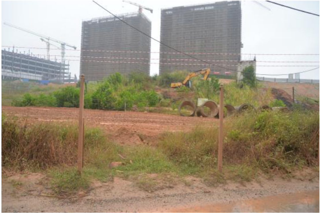
图 14 地表现状（北-南）
