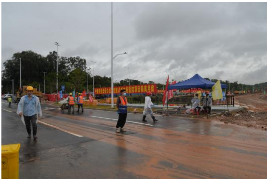
图 11 地表现状（南—北）
