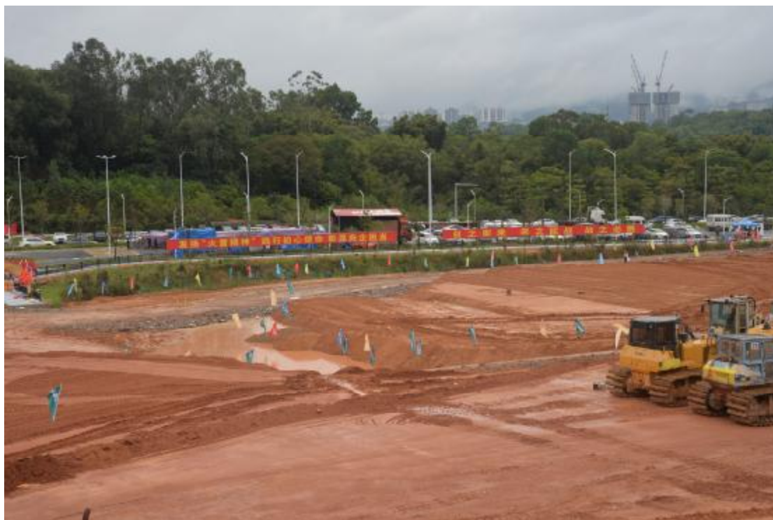
图 20 地表现状（南—北）
