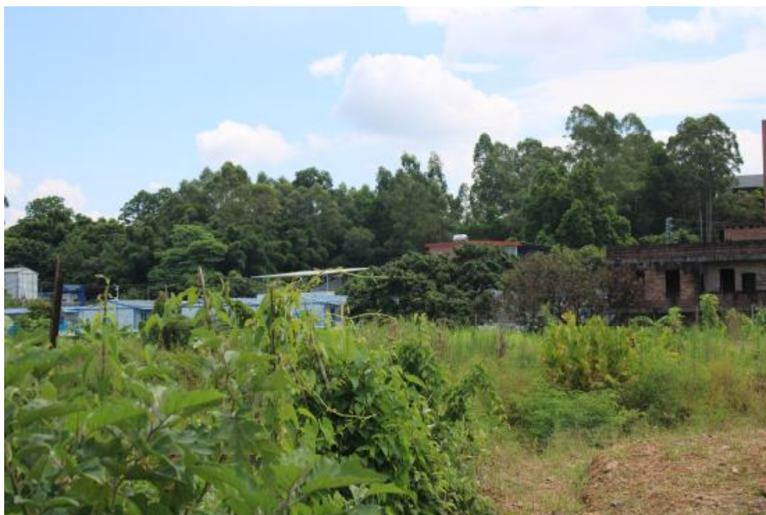
图 20 地表现状（北-南）
