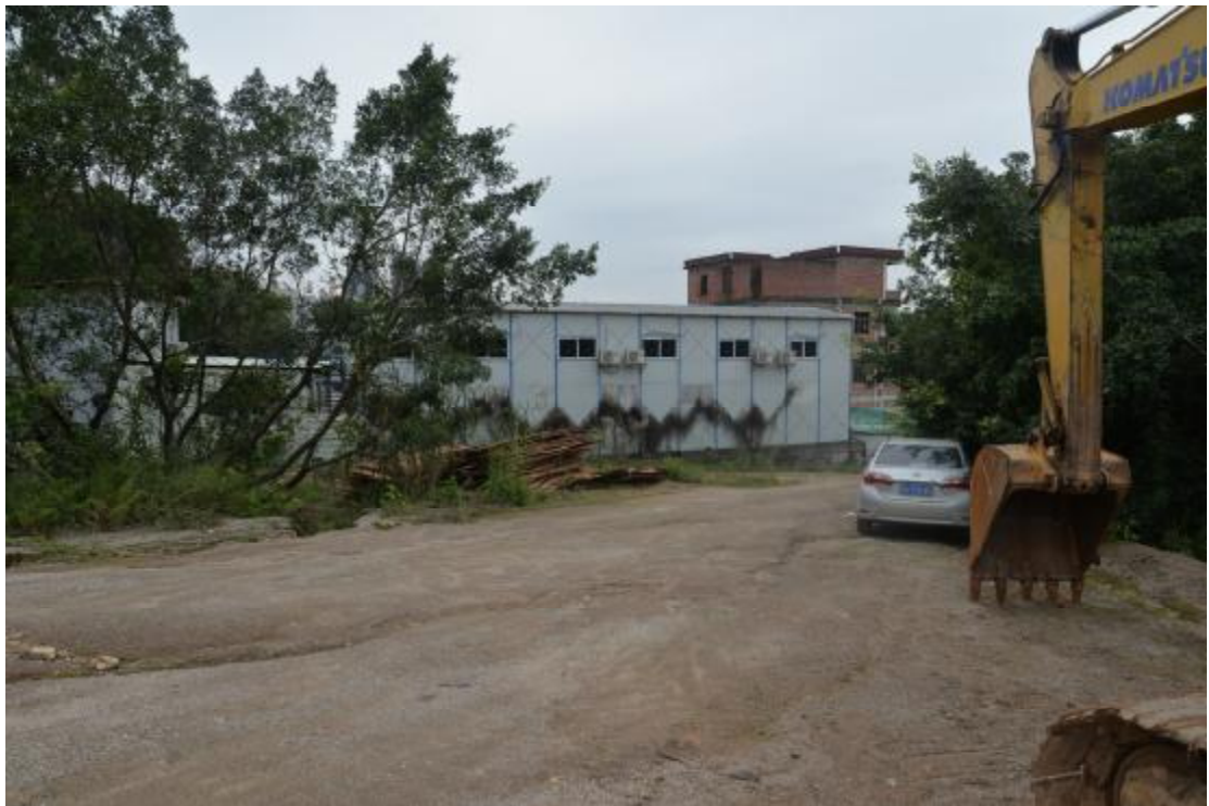
图 33 地表现状（东-西）
