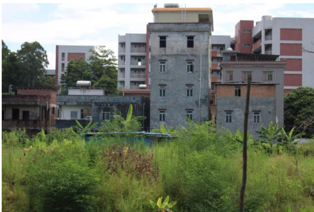
图 24 地表现状（北-南）
