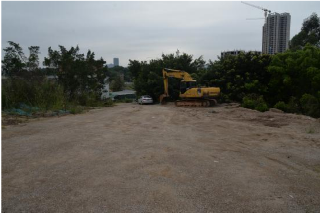
图 30 地表现状（南-北）
