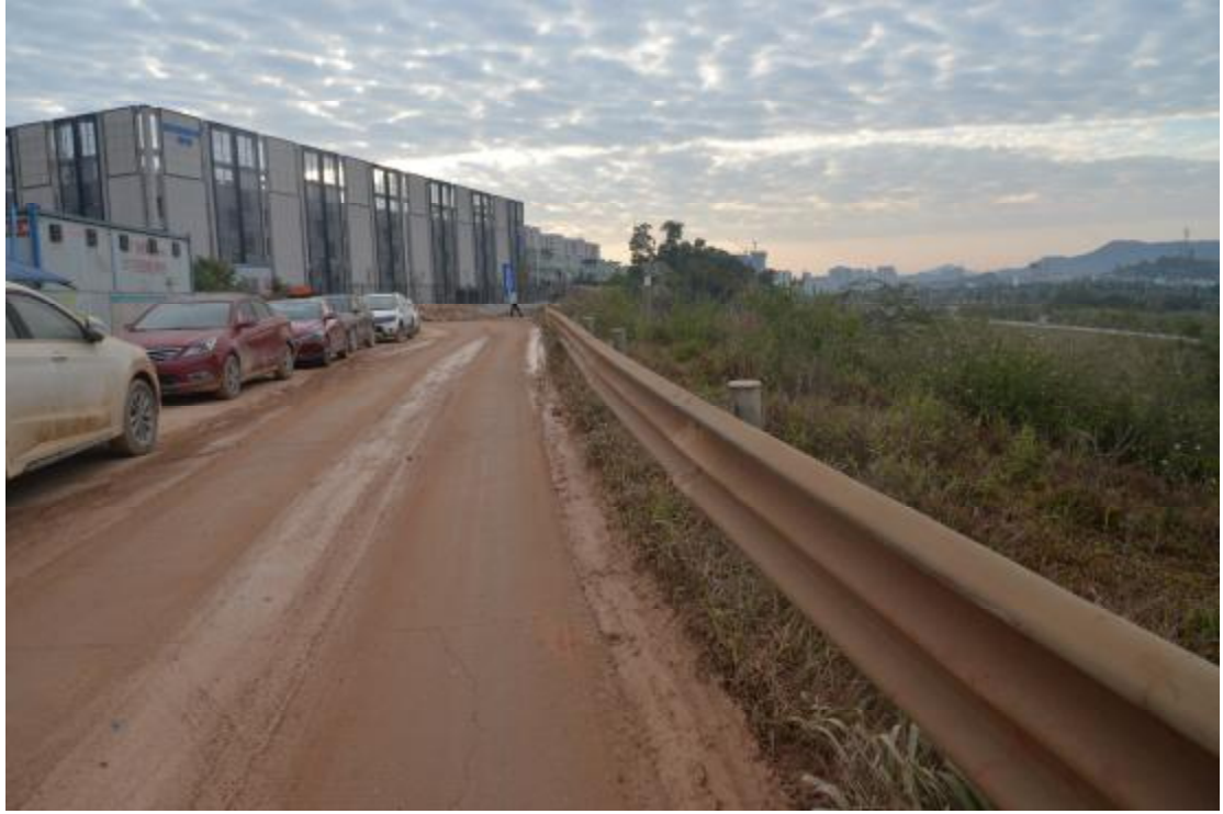
图 23 地表现状（北-南）
