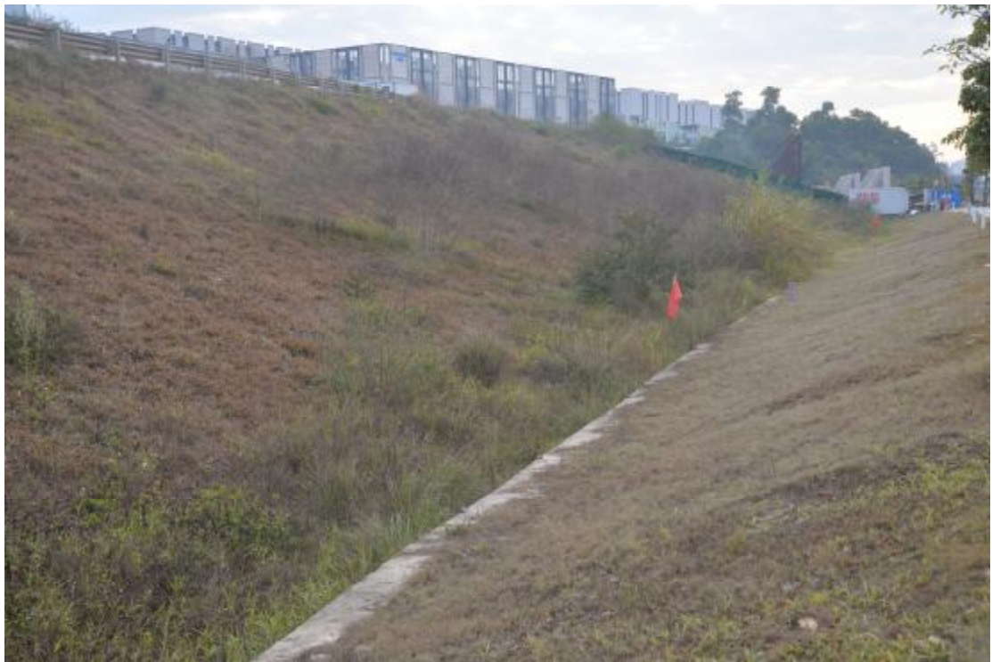
图 22 地表现状（北-南）
