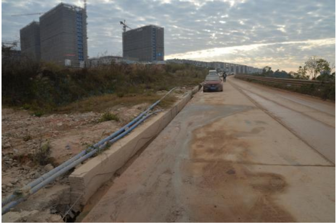
图 25 地表现状（北-南）
