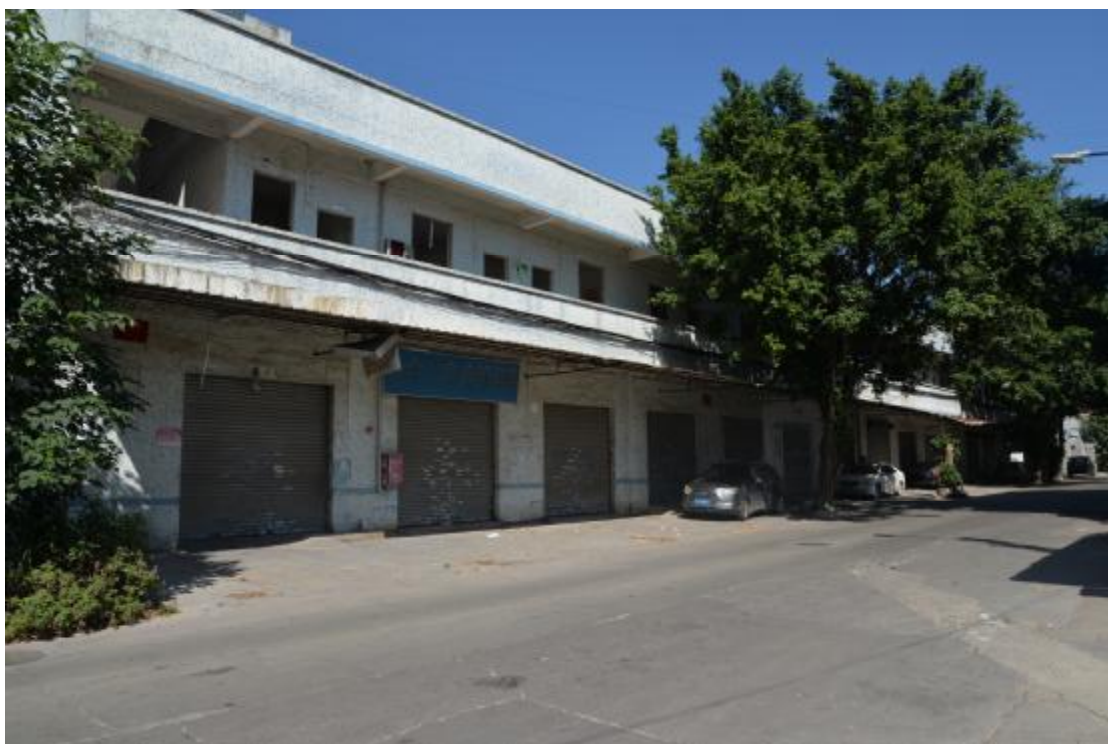
图 24 地表现状（东-西）
