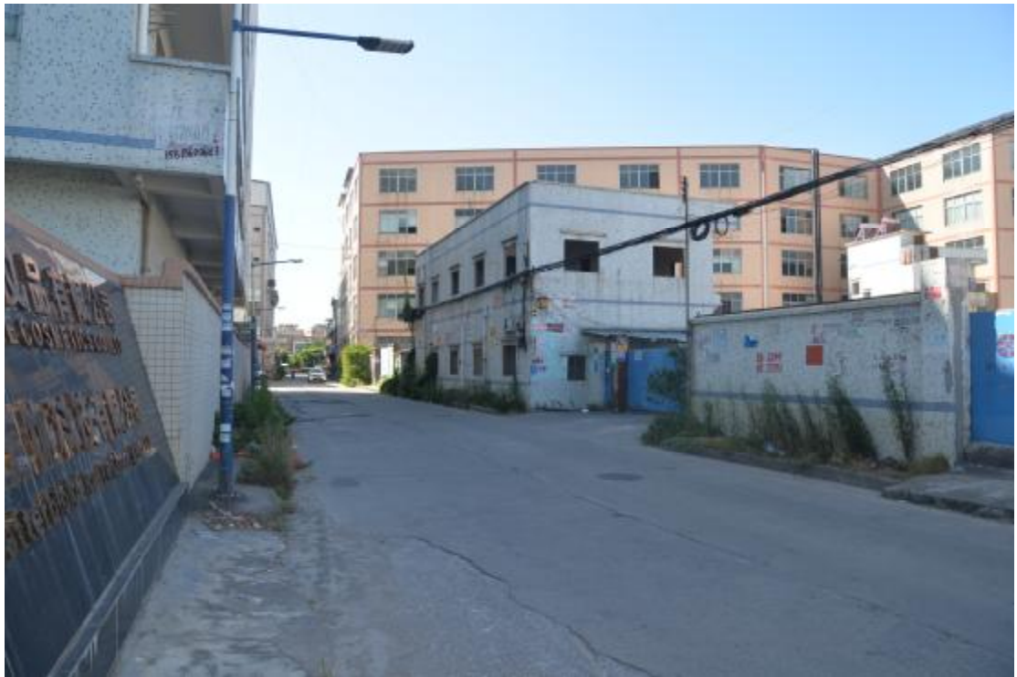
图 20 地表现状（北-南）
