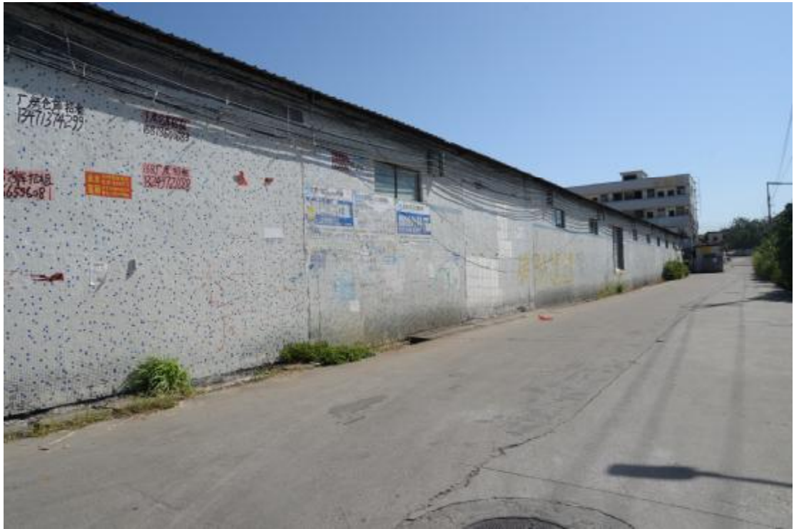
图 13 地表现状（南-北）
