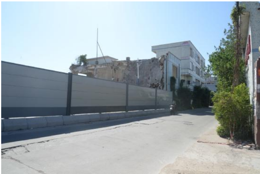
图 17 地表现状（北-南）
