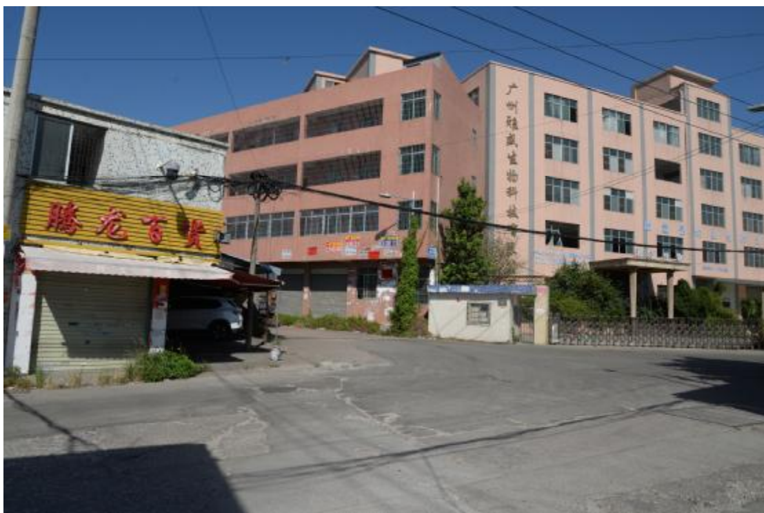
图 12 地表现状（东-西）
