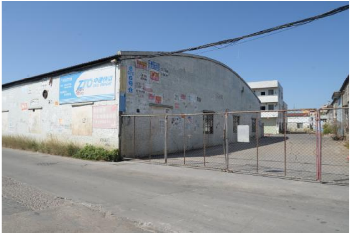
图 15 地表现状（东-西）
