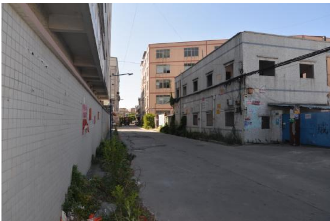
图 22 地表现状（南-北）
