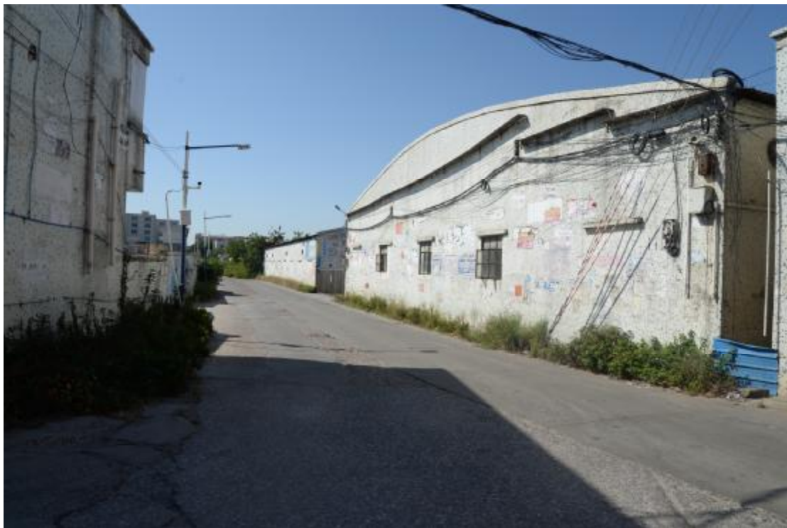
图 11 地表现状（北-南）
