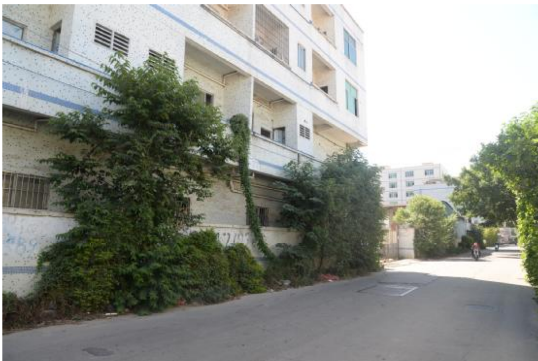
图 18 地表现状（北-南）
