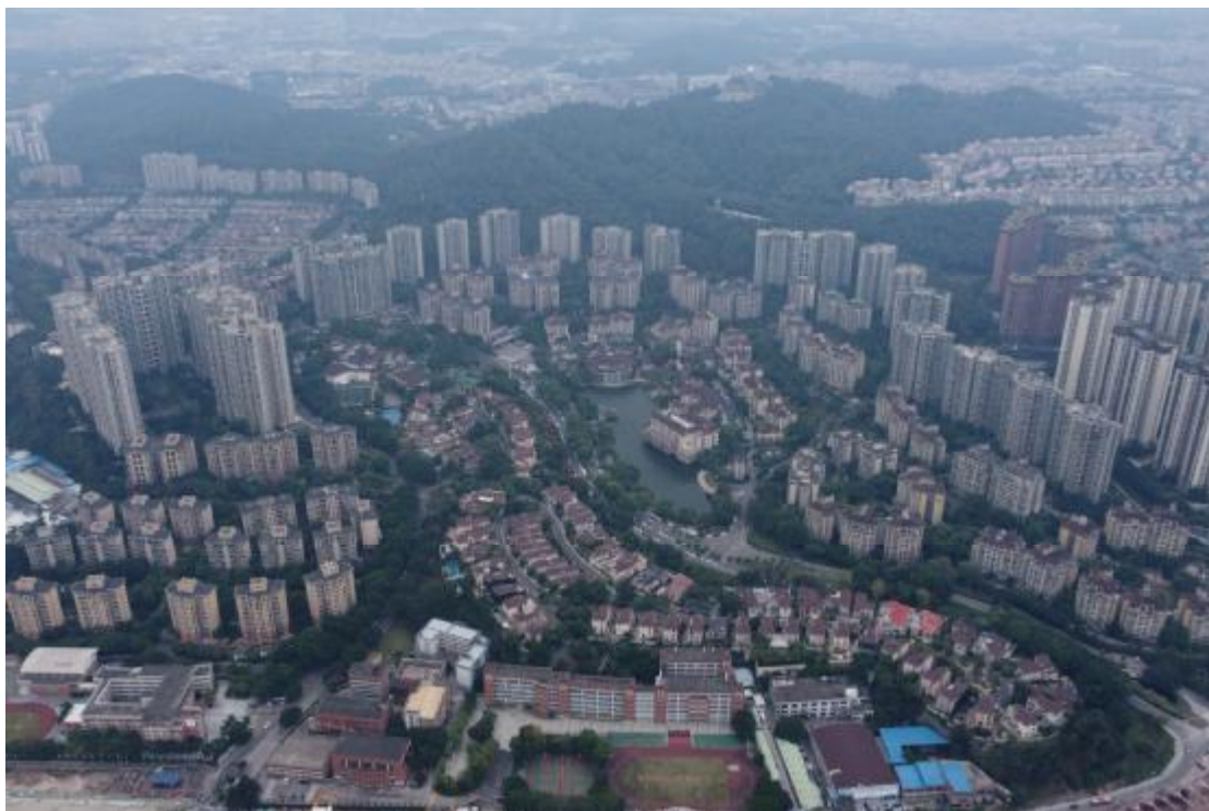
图 11 地块南部地形地貌航拍图（北-南）
