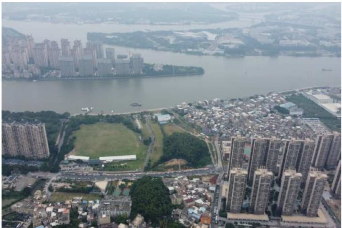
图 9 地块北部地形地貌航拍图（南-北）
