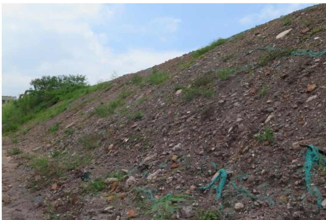
图 30 地块内现状（北-南）
