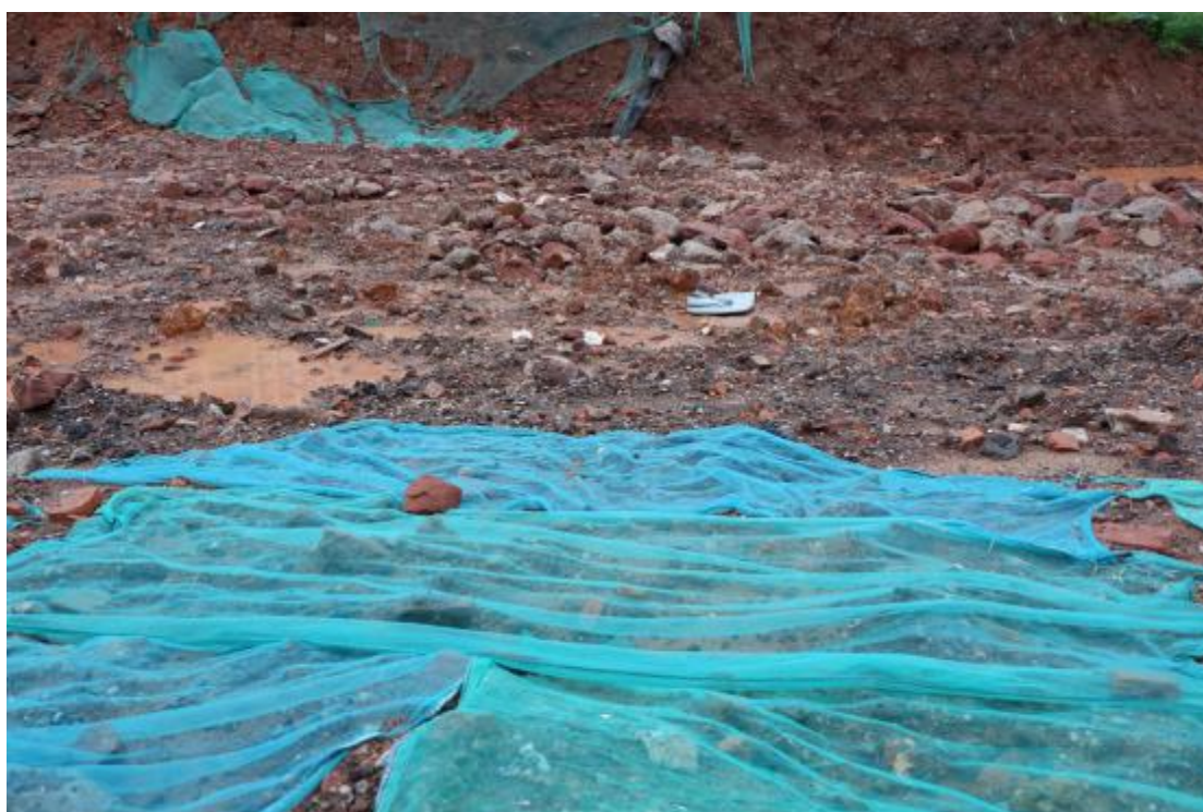
图 20 地块内北部现状（南-北）
