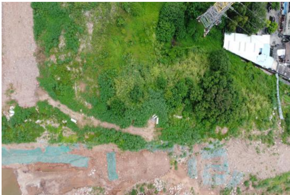
图 15 地块内北部现状航拍（上南-下北）
