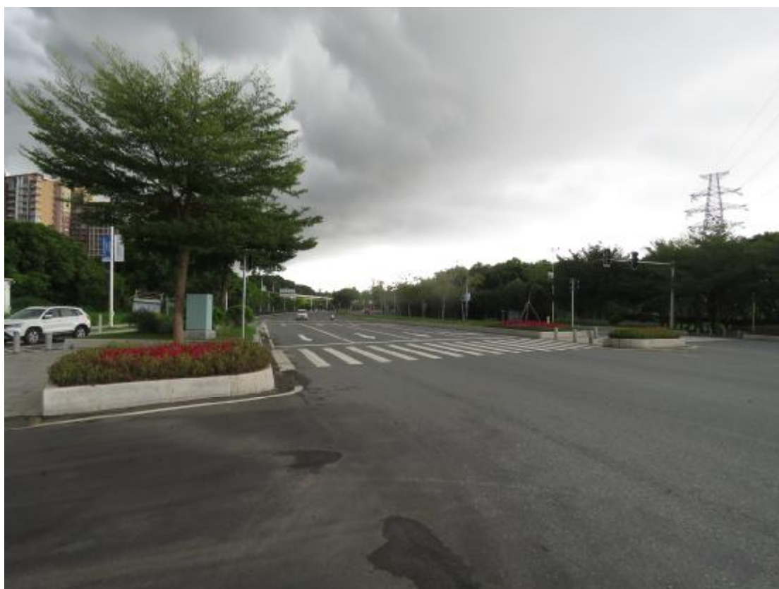
图 9 A 段地表现状（东-西）
