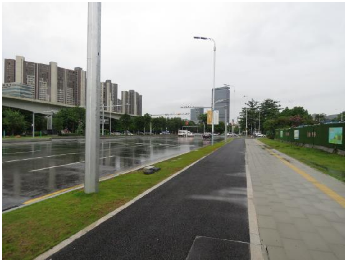
图 13 B 段地表现状（东-西）
