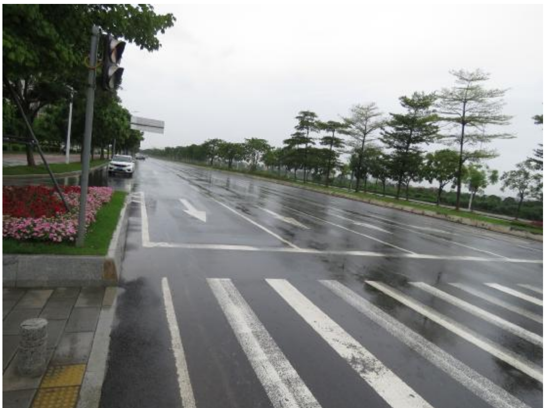
图 41 E 段地表现状（南-北）
