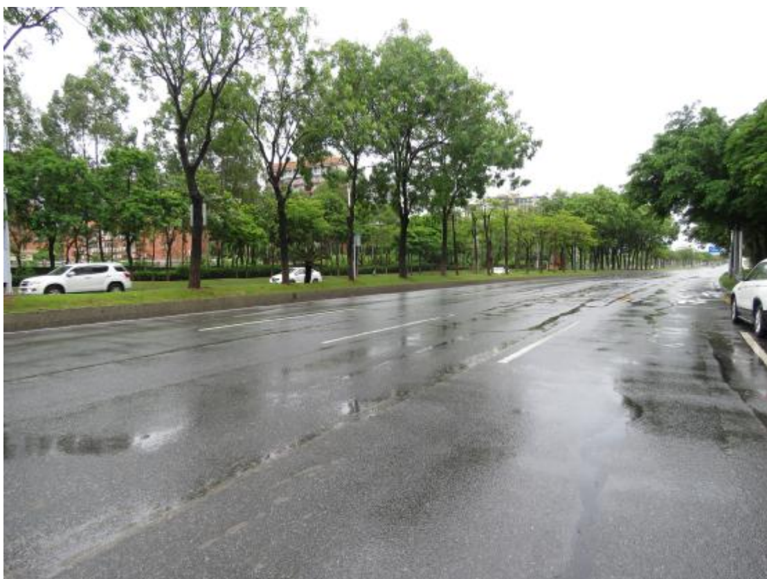
图 27 D 段地表现状（北-南）
