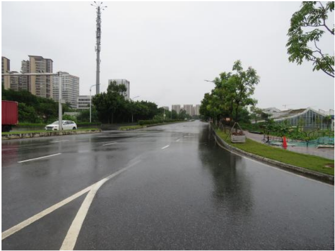
图 36 E 段地表现状（东-西）
