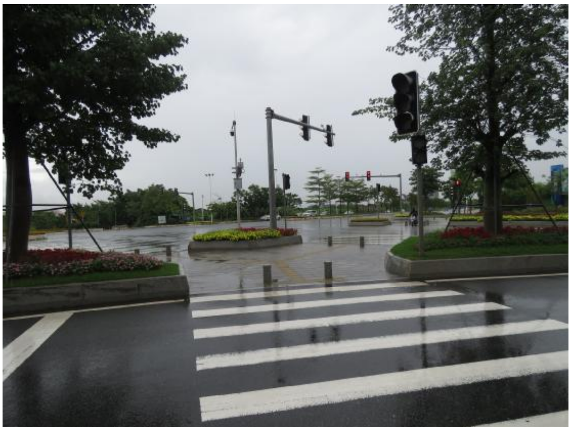
图 39 E 段地表现状（西-东）
