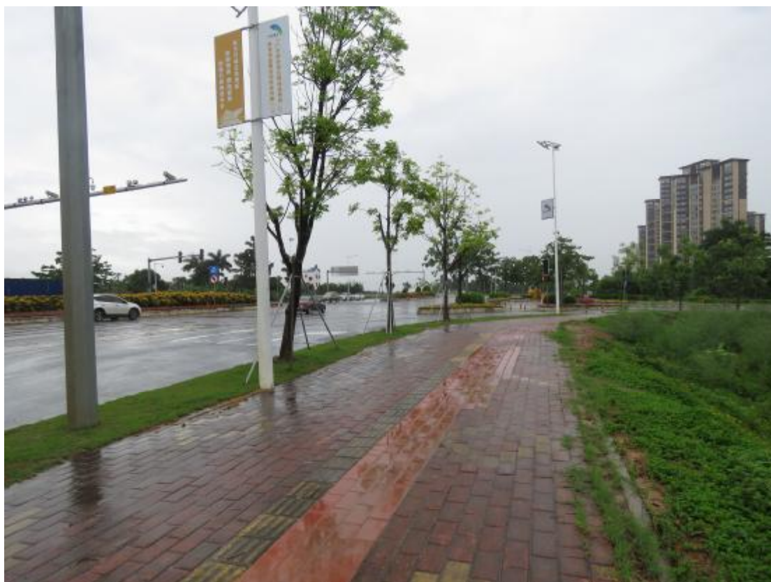
图 34 E 段地表现状（北-南）
