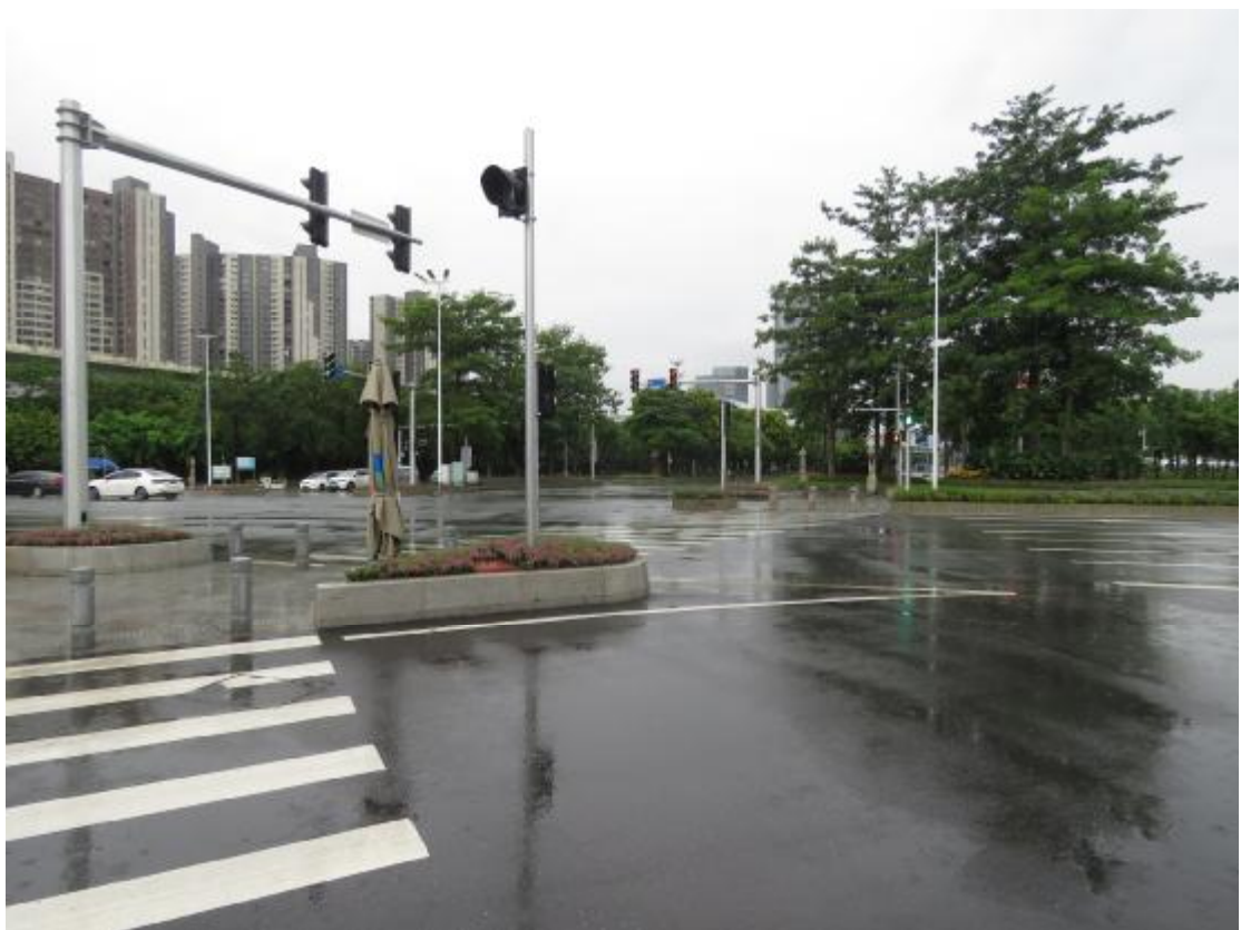
图 15 B 段地表现状（东-西）
