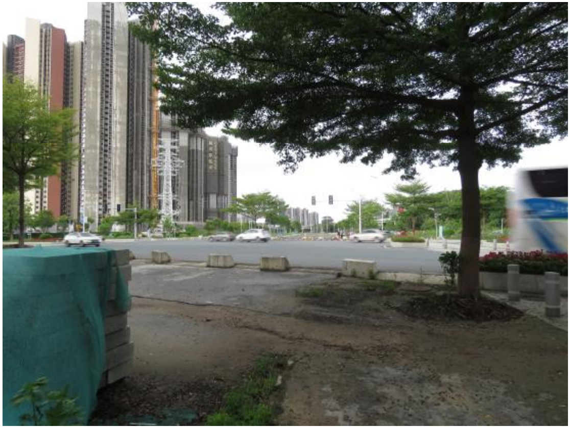
图 12 A 段地表现状（东-西）
