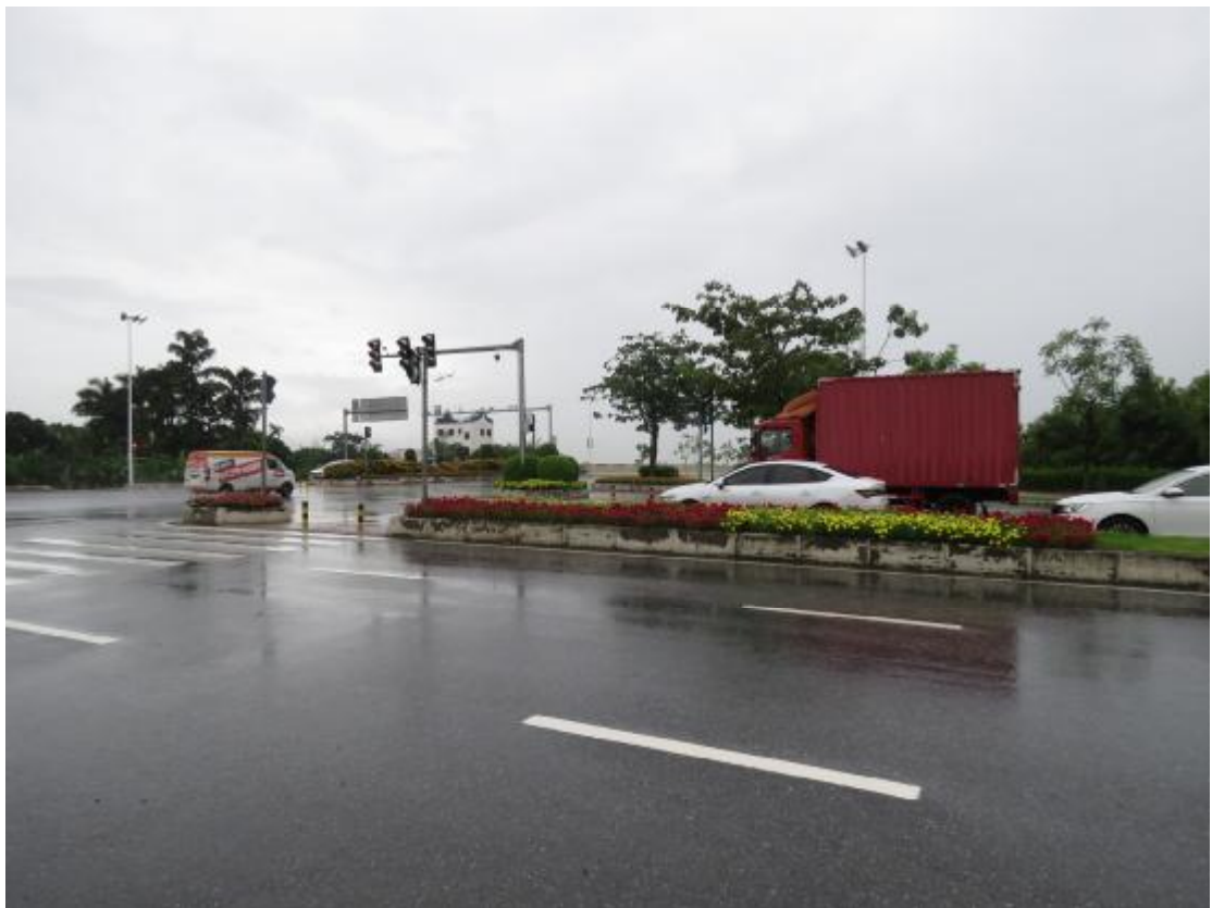
图 37 E 段地表现状（北-南）
