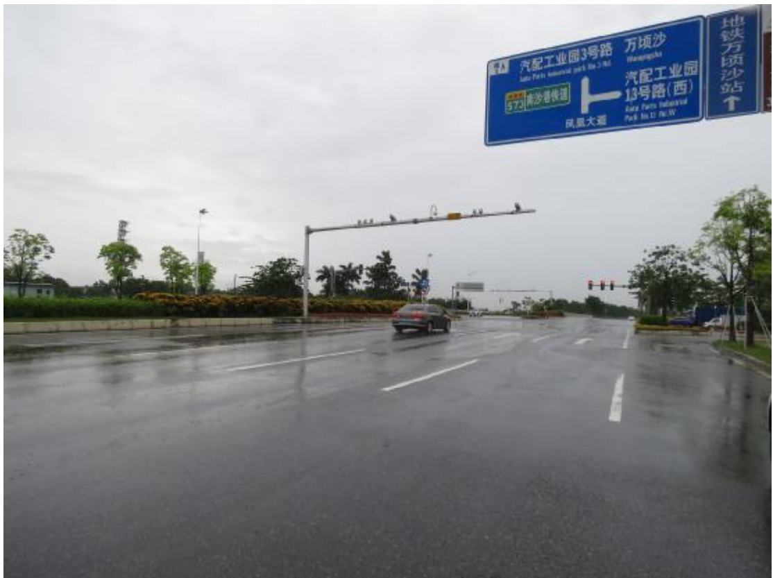
图 33 E 段地表现状（北-南）
