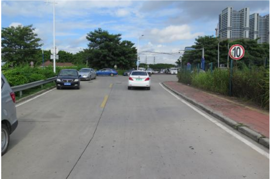
图 12 地块内东部现状（东-西）
