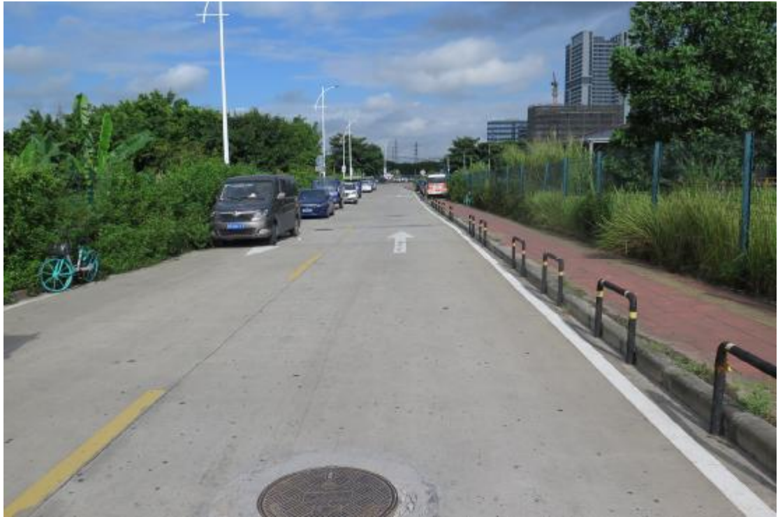
图 10 地块内东部现状（东-西）
