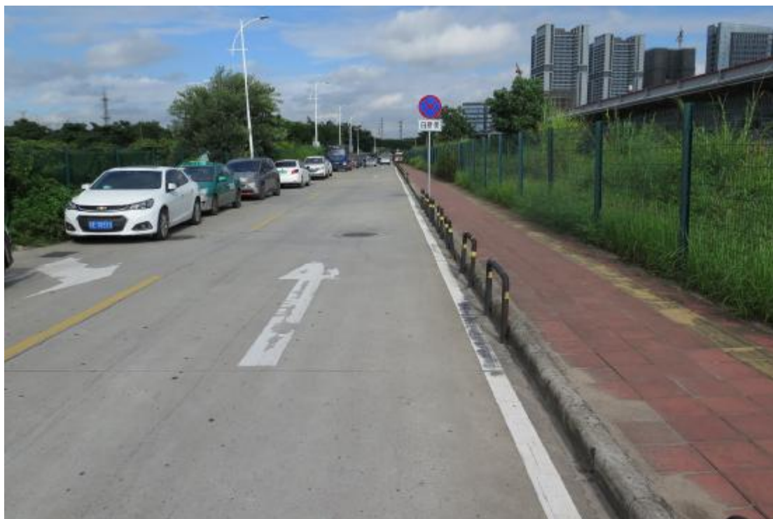
图 8 地块内东部现状（东-西）
