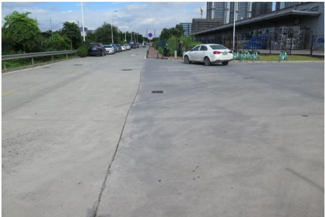
图 13 地块内中东部现状（东-西）
