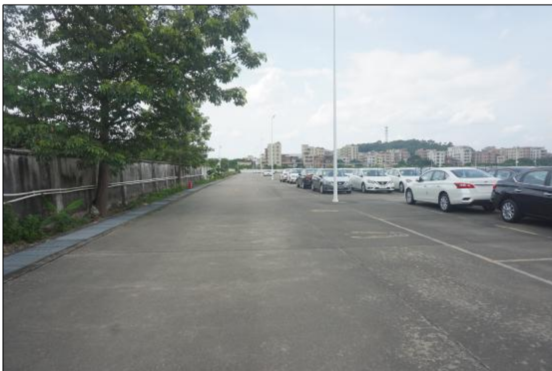
图 21 地块内部现状（南-北）
