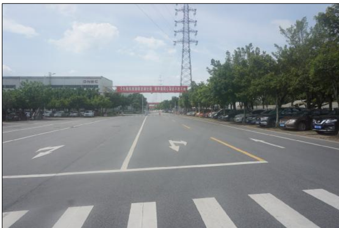
图 11 地块内部现状（南-北）
