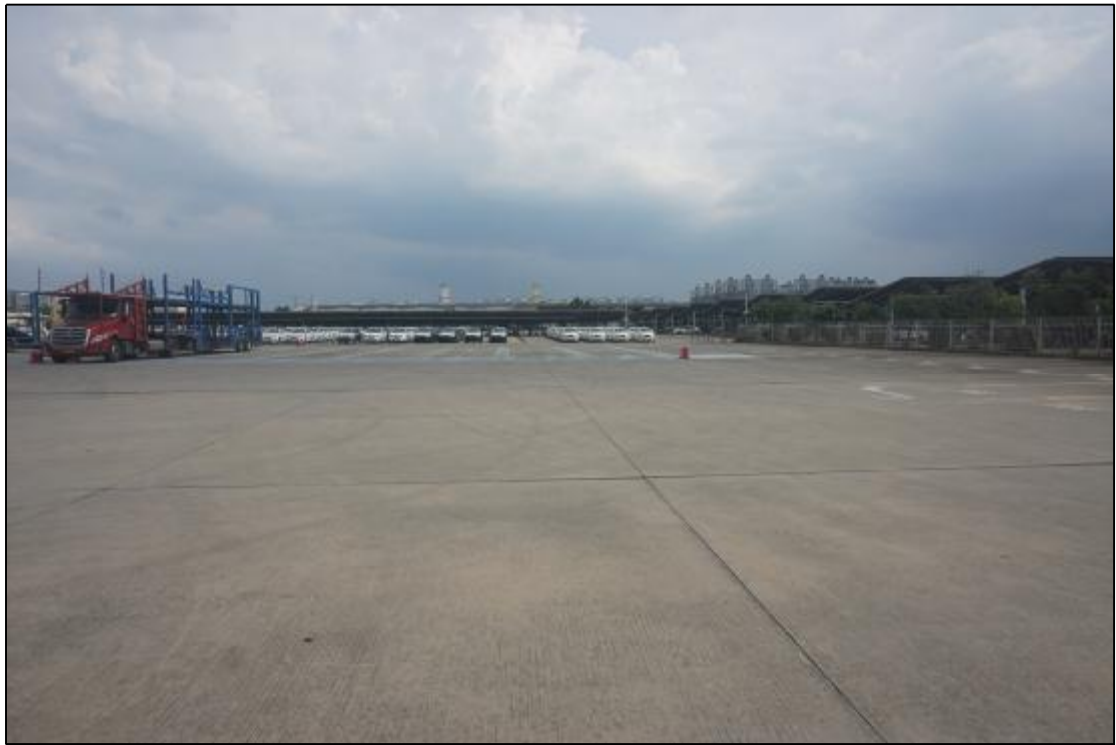
图 16 地块内部现状（西-东）
