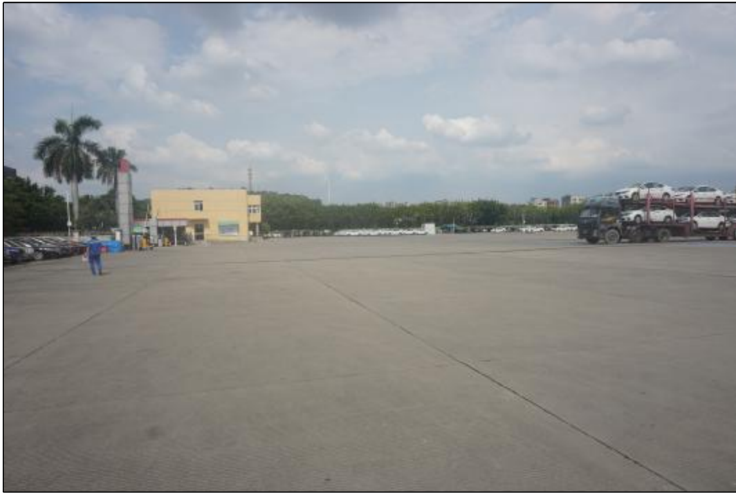
图 18 地块内部现状（西-东）
