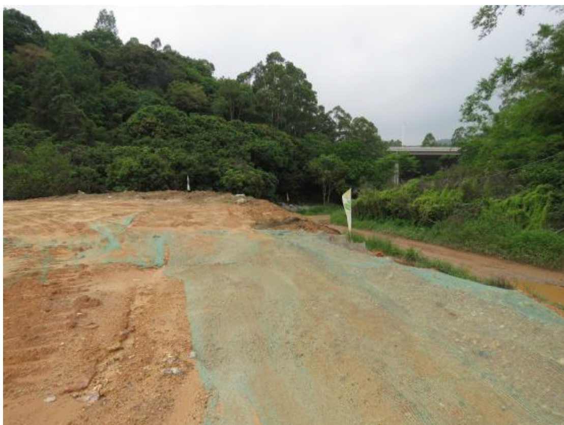
图 16 地表现状（东-西）
