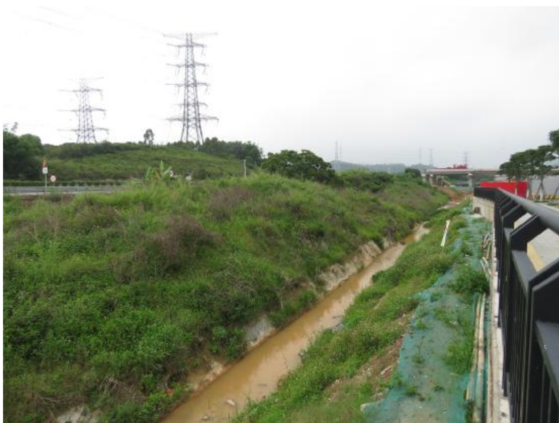
图 10 地表现状（东-西）
