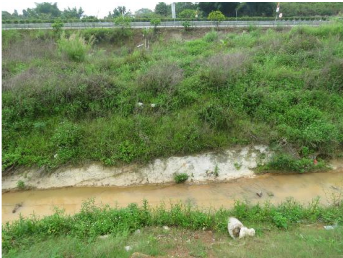
图 11 地表现状（北-南）
