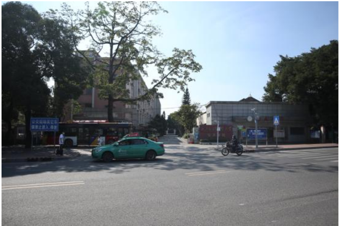
图 32 地块中部广东外语外贸大学（东北-西南）
