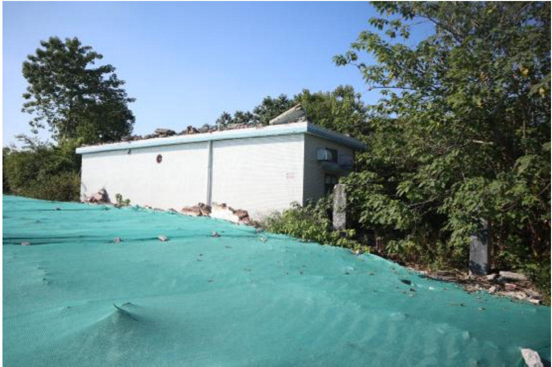
图 18 地块西北部现状（东南-西北）
