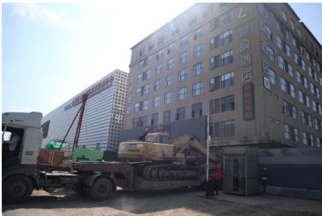
图 14 地块东北部未拆除建筑（东部-西南）
