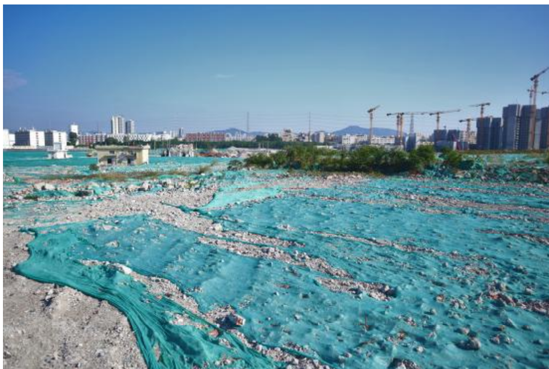
图 26 地块西南部远景（西北-东南）
