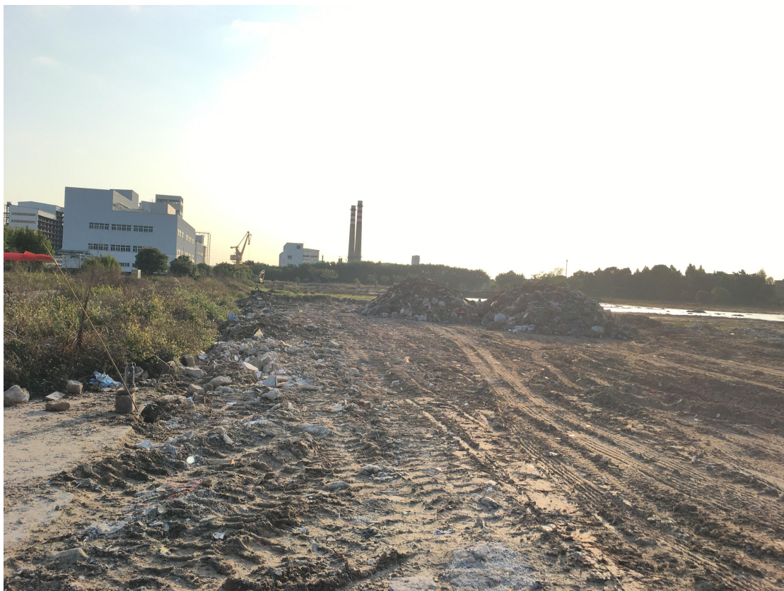
图 8 地表现状（东-西）
