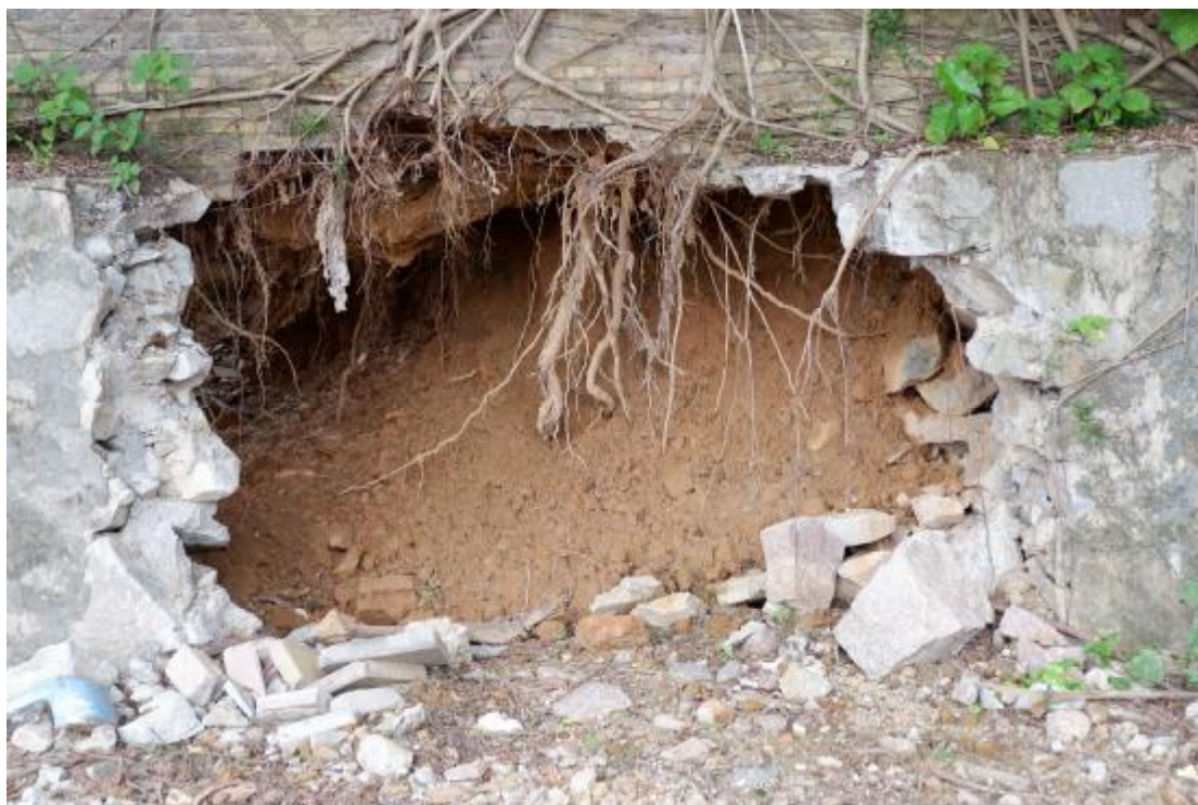
图 26 地块东部建筑垫土（西-东）
