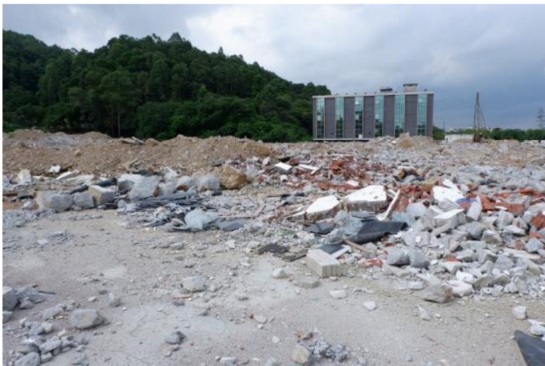
图 28 地块东部现状（北-南）
