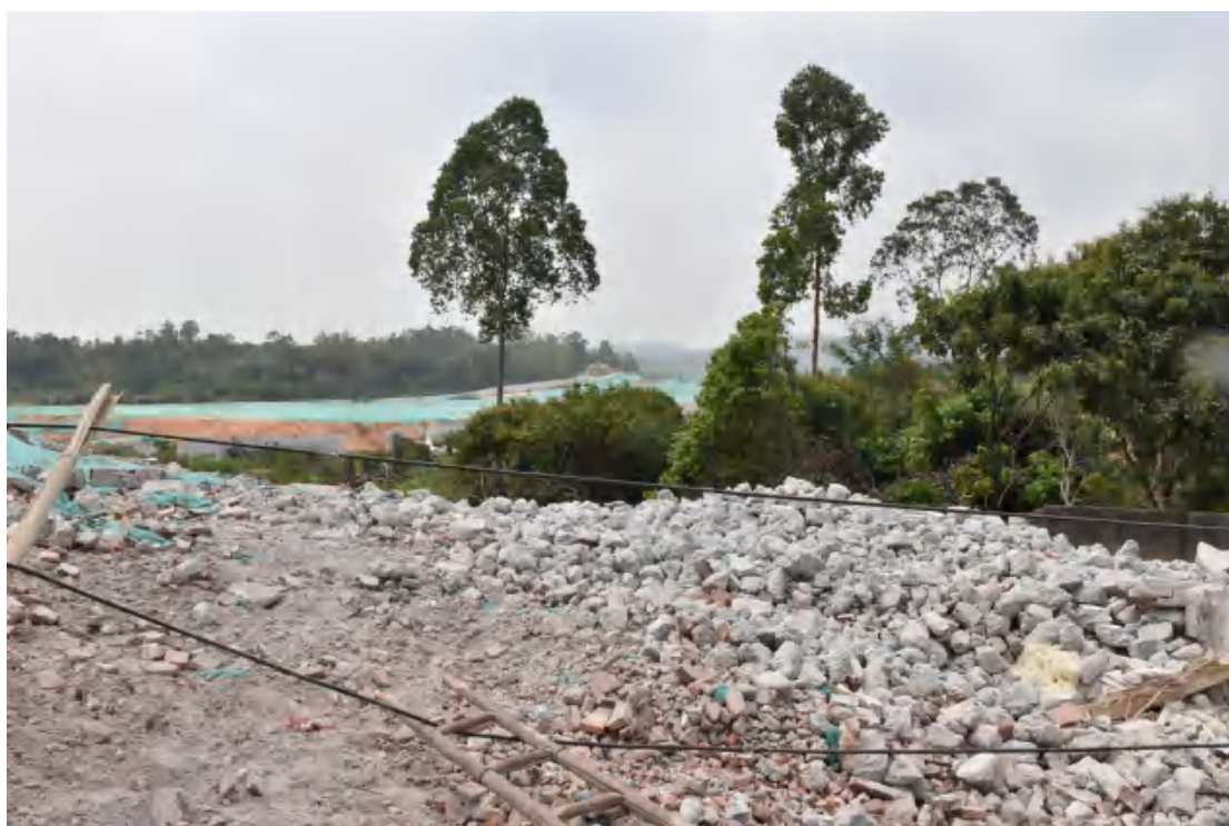
图 11 地块地表现状（北—南）
