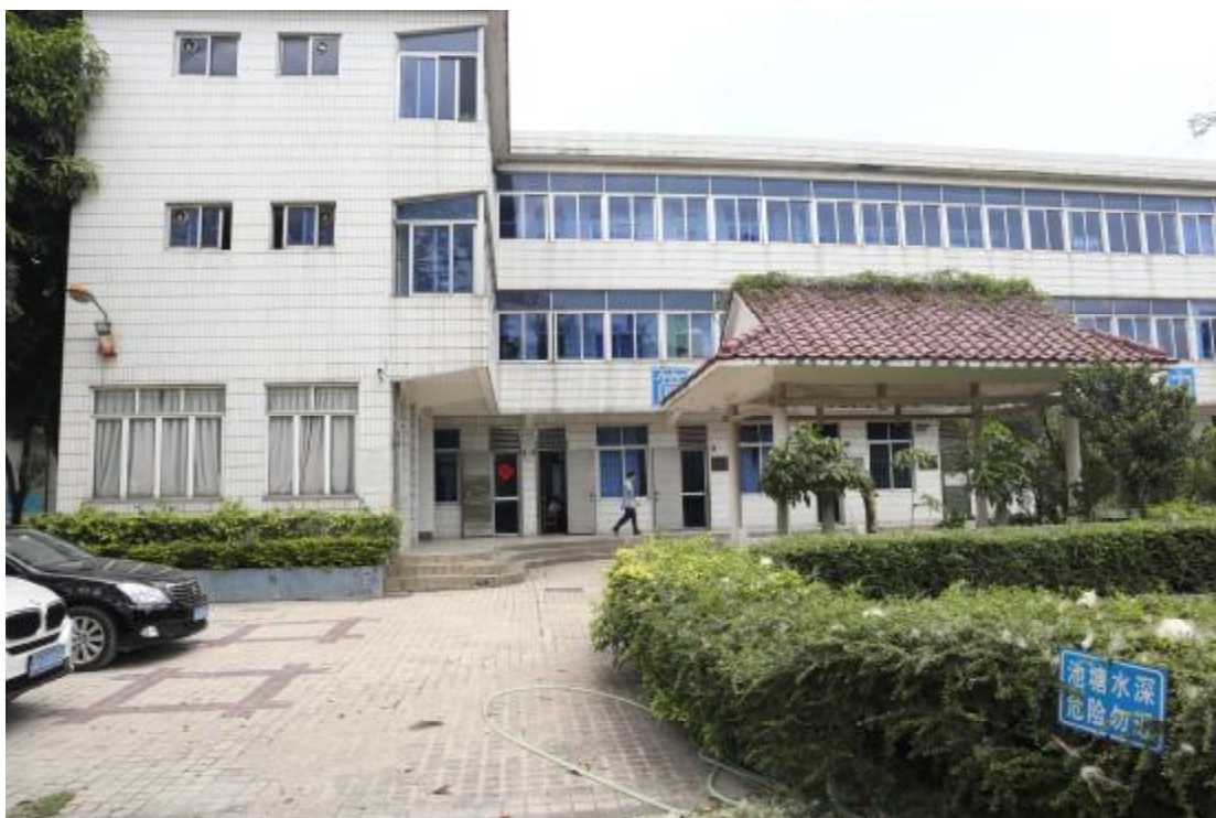
图 18 地块东南部现状（南-北）
