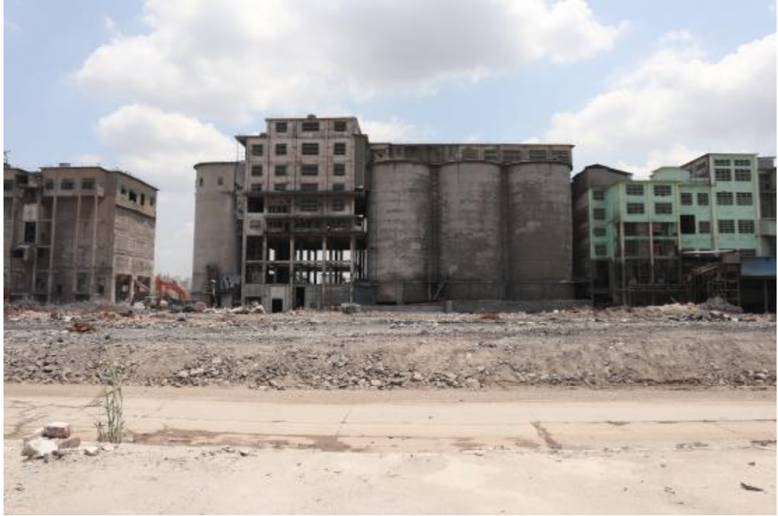
图 21 地块中部现状（西-东）
