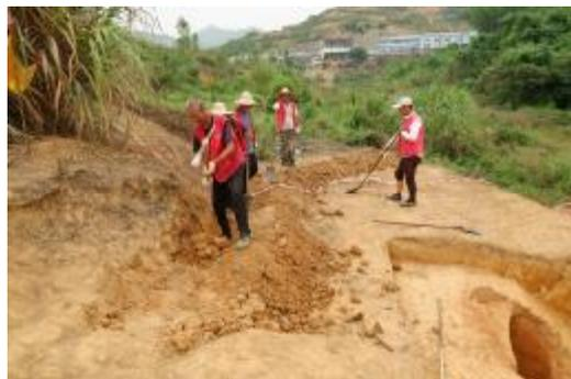
图 39 修挖发掘区域排水渠
