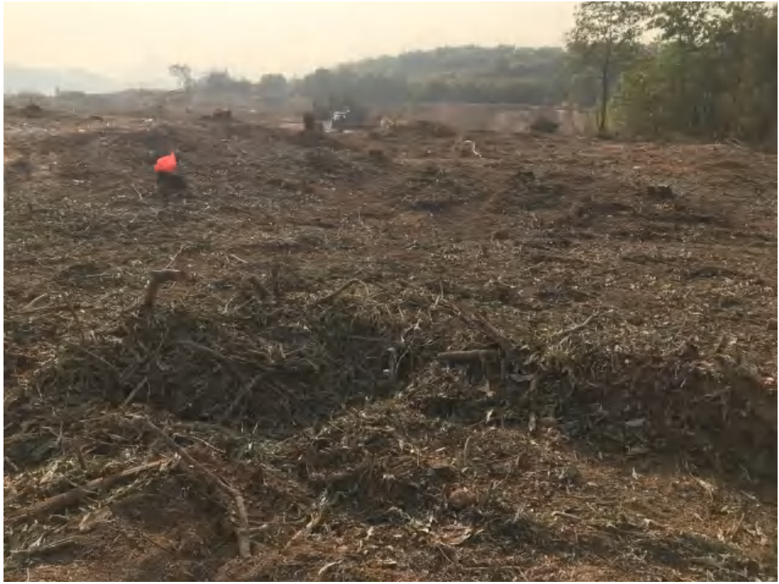
图 26 北部地块地表现状（东—西）
