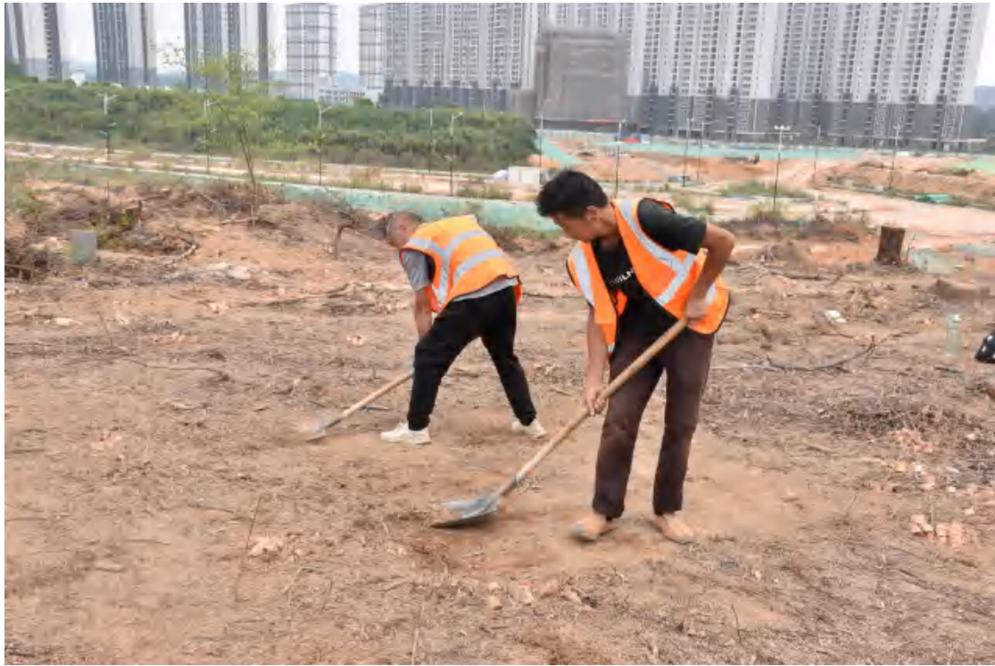
图 62 探沟表面清理（西北-东南）
