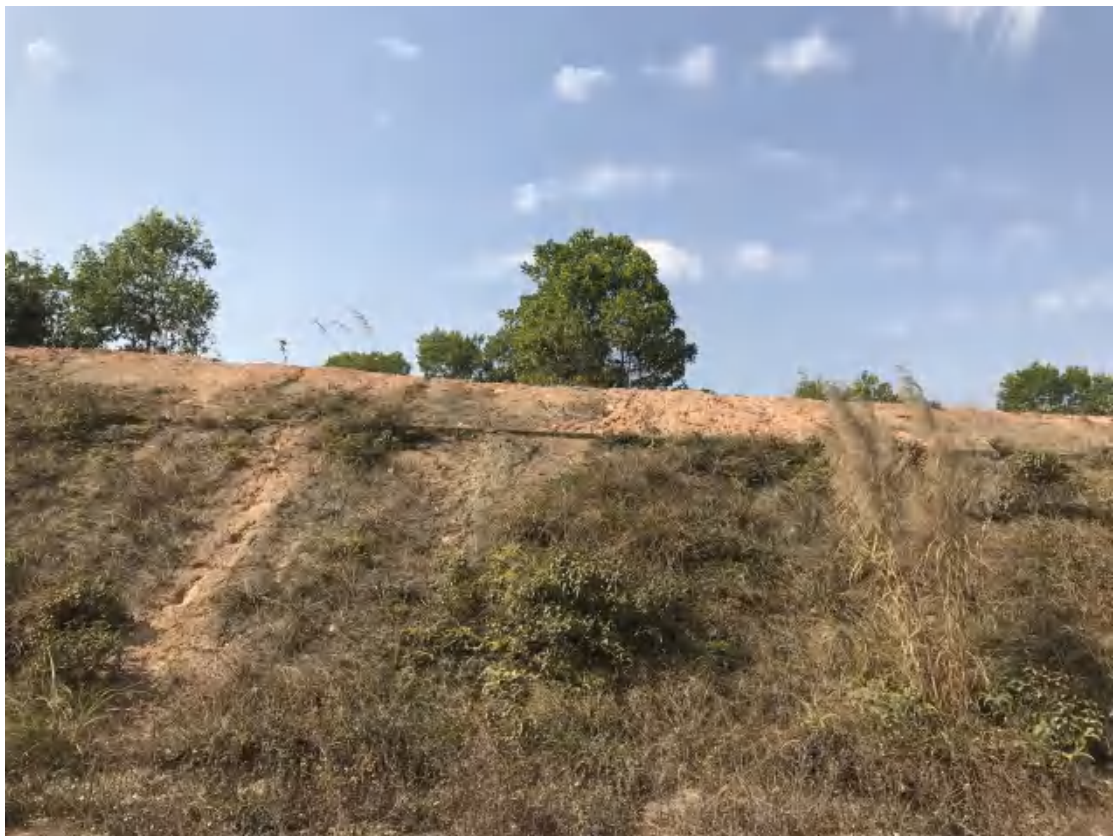
图 17 南部地块山岗现状（南—北）
